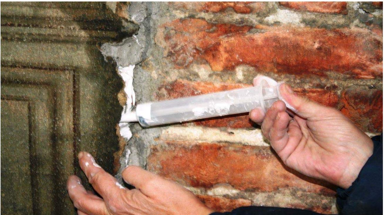
Vista della parte alta del portale durante le operazioni di infiltrazione e di stuccatura
