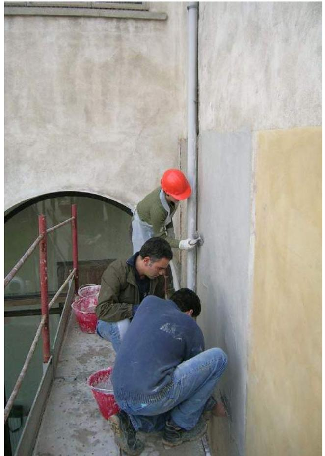
Vista del “muro- campione” durante le operazioni di rifacimento dell’intonaco con calce e sabbia nella parte alta e di cocciopesto nella parte bassa.
