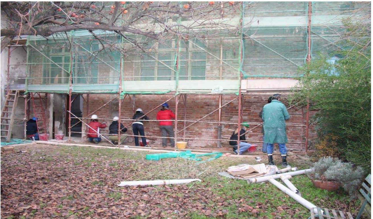
Scrostatura del pianterreno e smaltimento delle macerie operato dagli stessi partecipanti del corso
