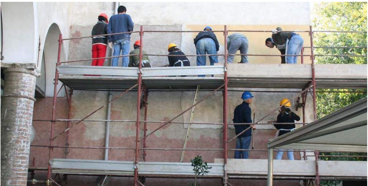
Vista del “muro- campione” durante le operazioni di idrolavaggio e il rifacimento dell’intonaco
