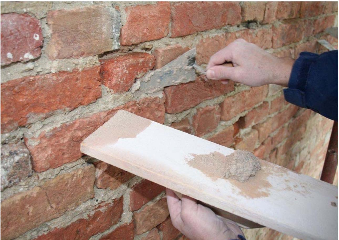
Particolari della stuccatura dei giunti, con malta di calce e sabbia, operata dai partecipanti del corso con l'assistenza degli istruttori
