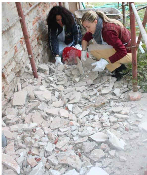
Progetto del “Muro-campione” e vista delle operazioni di scrostamento da parte dei partecipanti del Corso, dell’intonaco cementizio degradato del muro di palazzo Mazzola
