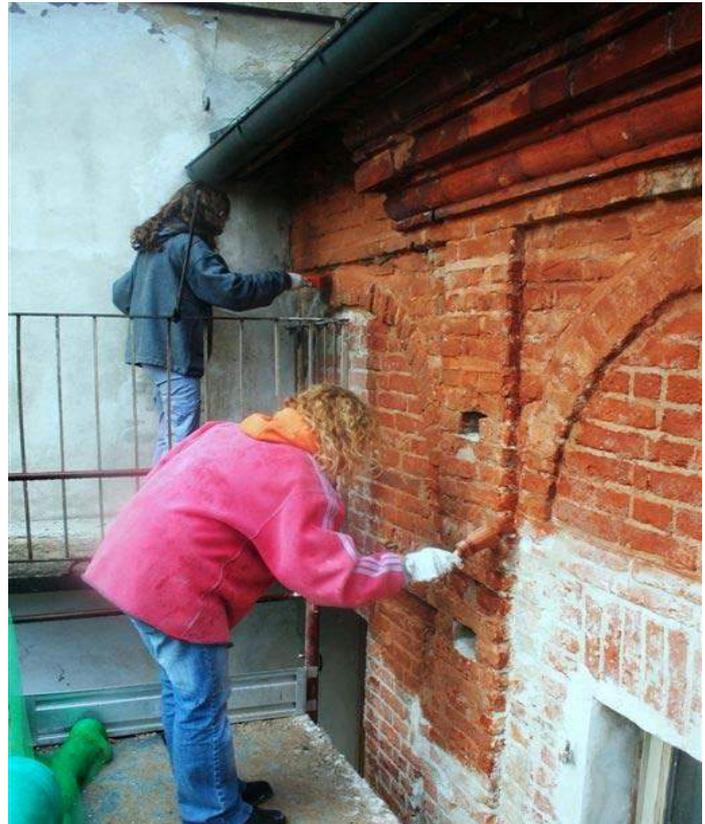
Particolari dopo la scrostatura e stuccatura e inizio della “scialbatura” operata dai partecipanti del corso, con l’assistenza degli istruttori
