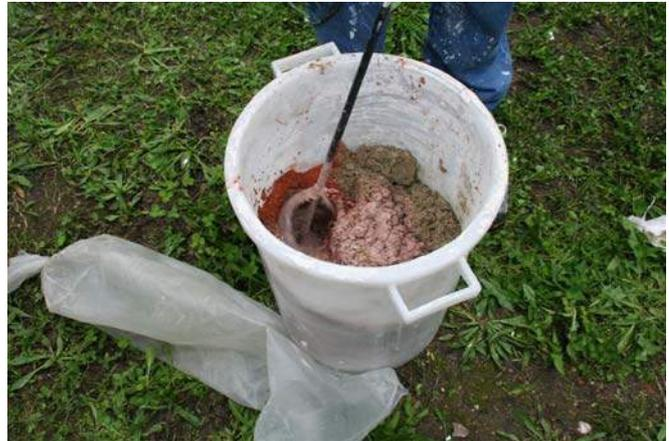
Vista degli attrezzi impiegati e della preparazione delle malta di calce e a cocciopesto
