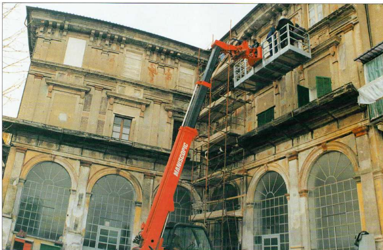
23. Ponteggio fisso per il rilievo della campata-tipo e piattaforma mobile per il monitoraggio delle altre parti di facciata.
