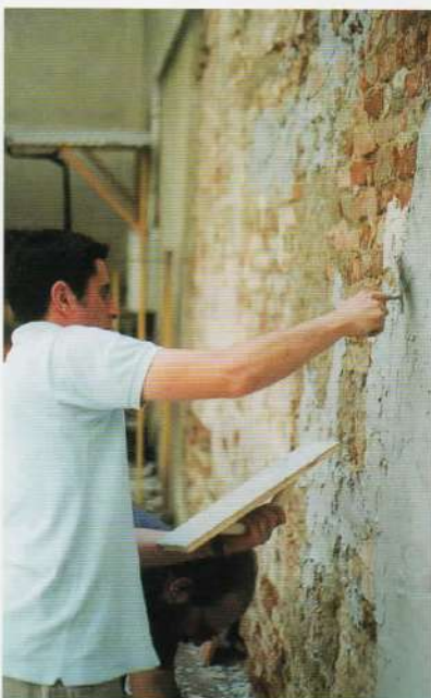
Rincocciatura, stuccatura delle commessure, rinzafo, intonaco e finitura del muro di prova
