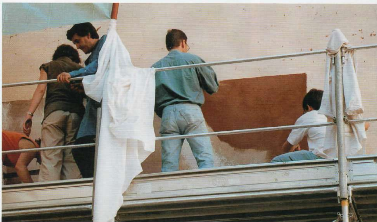
Restauro dell'intonaco e coloritura generale del fondo con colore mattonaceo
