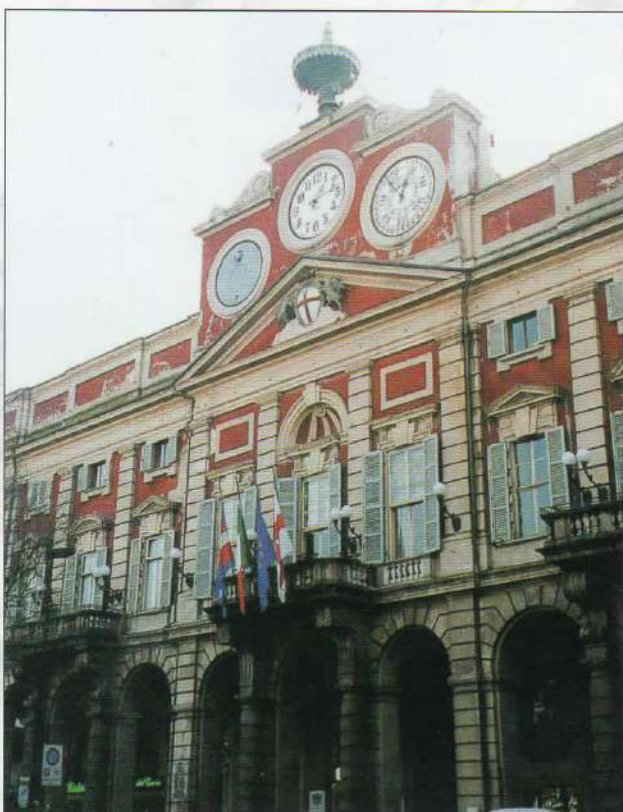
Palazzo Comunale di Alessandria, nel cui cortile si è svolto il Corso di restauro delle facciate storiche, nell'ambito del Piano colore di Alessandria, con la realizzazione della "Tavolozza dei colori" della Città
