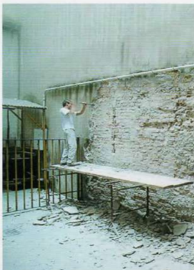
"Muro di prova" del laboratorio del corso, prima della preparazione, durante l'operazione di scrostamento dell'intonaco degradato e di l'idrolavaggio del muro, dopo lo scrostamento
