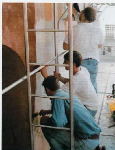
Restauro dell'intonaco e coloritura generale del fondo con colore mattonaceo
