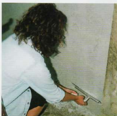
Rincocciatura, stuccatura delle commessure, rinzafo, intonaco e finitura del muro di prova
