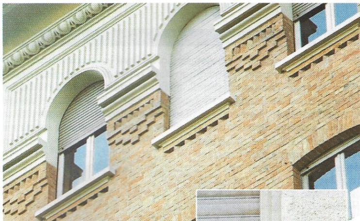
rata con latte di calce della ditta Piasco e terre coloranti naturali della ditta Dolci. I davanzali e le parti in sporgenza in cemento, particolarmente esposti all'acqua, sono stati protetti con Antol Acquaprof della Torggler, una malta fine impermeabilizzante applicata a pennello.
