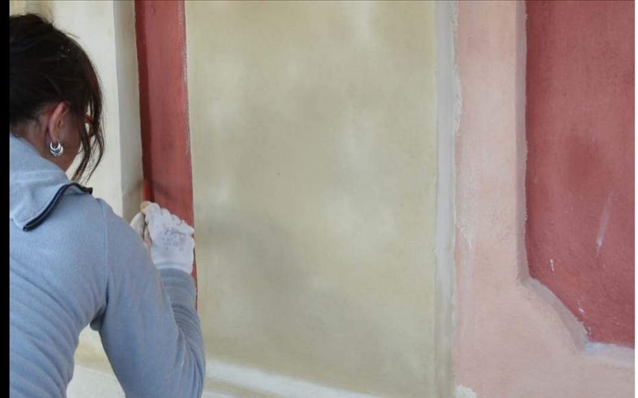
Coloritura tricromatica della Cappella, con colori a calce e terre coloranti, desunti dalle tracce di colorazione storica
