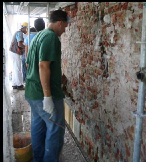
La demolizione dell'intonaco cementizio degradato, realizzato negli anni '80
