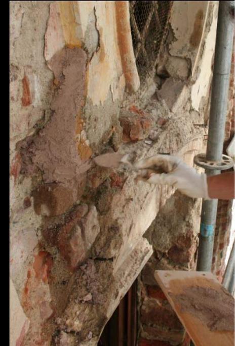
Fissaggio dei bordi degli intonaci decoesi, con infiltrazioni e “chiodature”,
