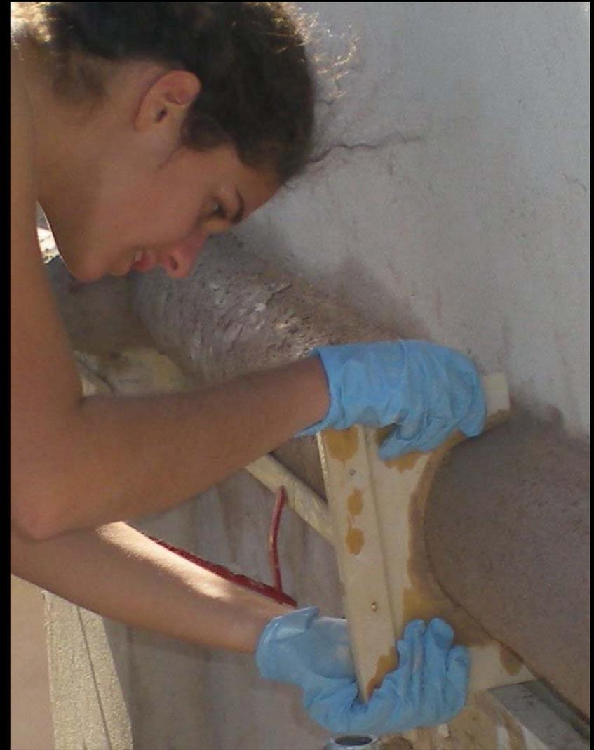
Sbozzatura con Intonaco al cocchiopesto della cornice torica e profilatura della stessa con la “dima” preparata in laboratorio
