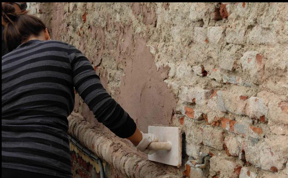
Stuccatura delle commessure, posa del sottofondo al cocchiopesto
