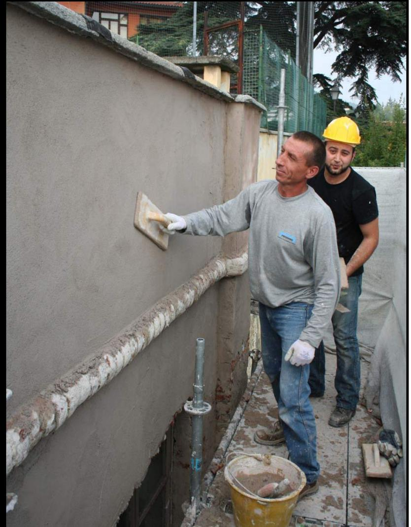
Finitura dell'intonaco a stucco sul sottofondo al cocchiopesto
