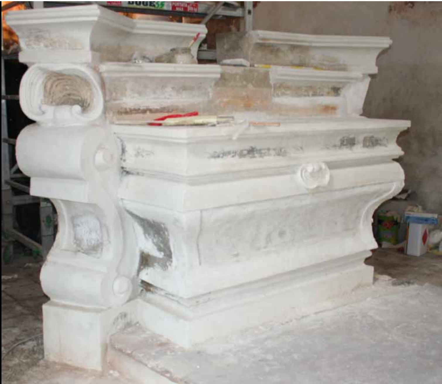
Restauro dell'altare in stucco dell'abside
