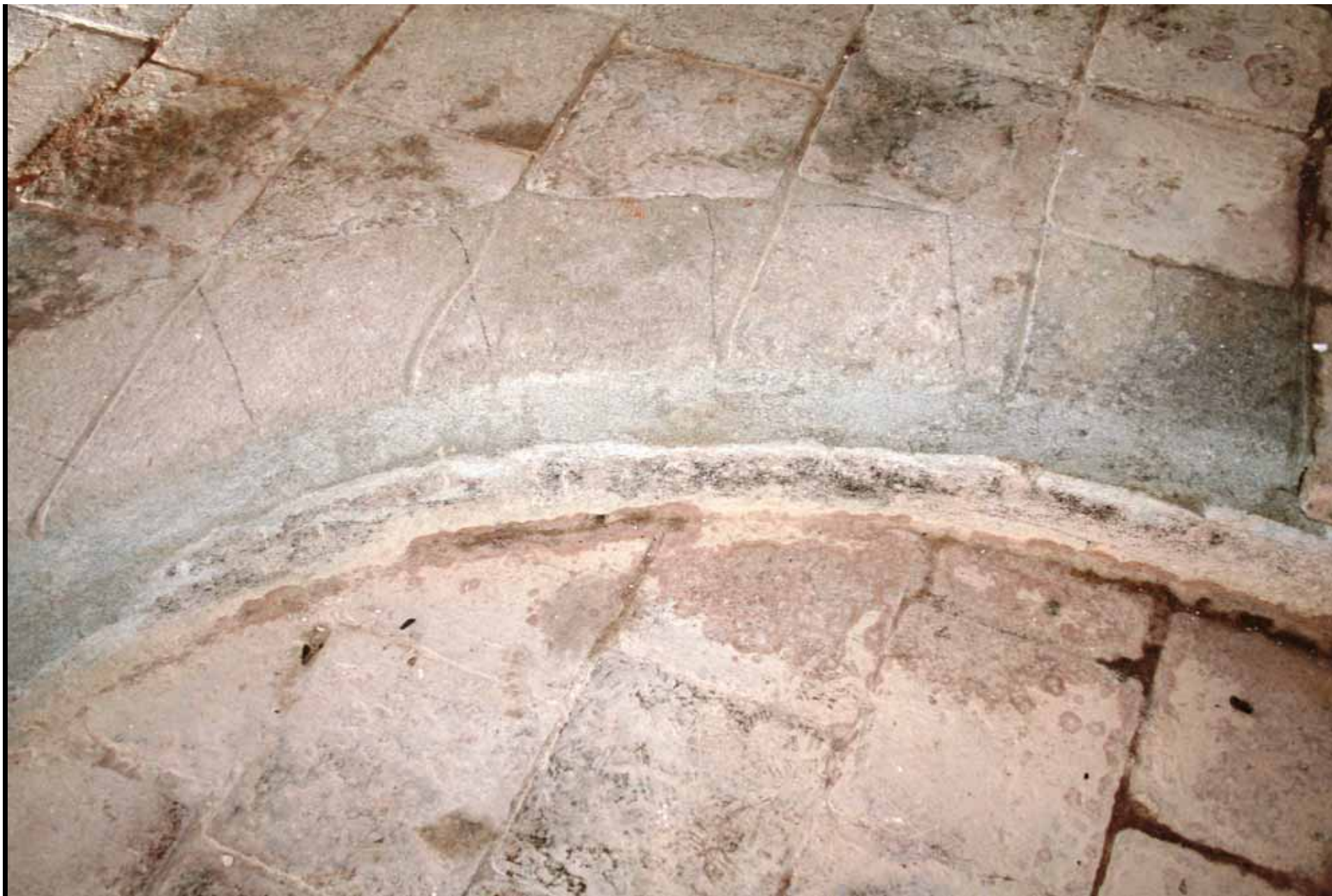
Stato di conservazione della pavimentazione in cotto della zona dell'altare, parzialmente sostituite con intonaco cementizio, prima del restauro
