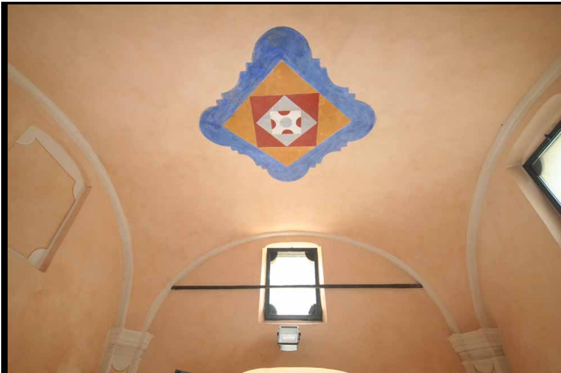
Le pareti e la volta dell'entrata della Cappella, dopo il restauro delle coloriture, in base alle stratigrafie
