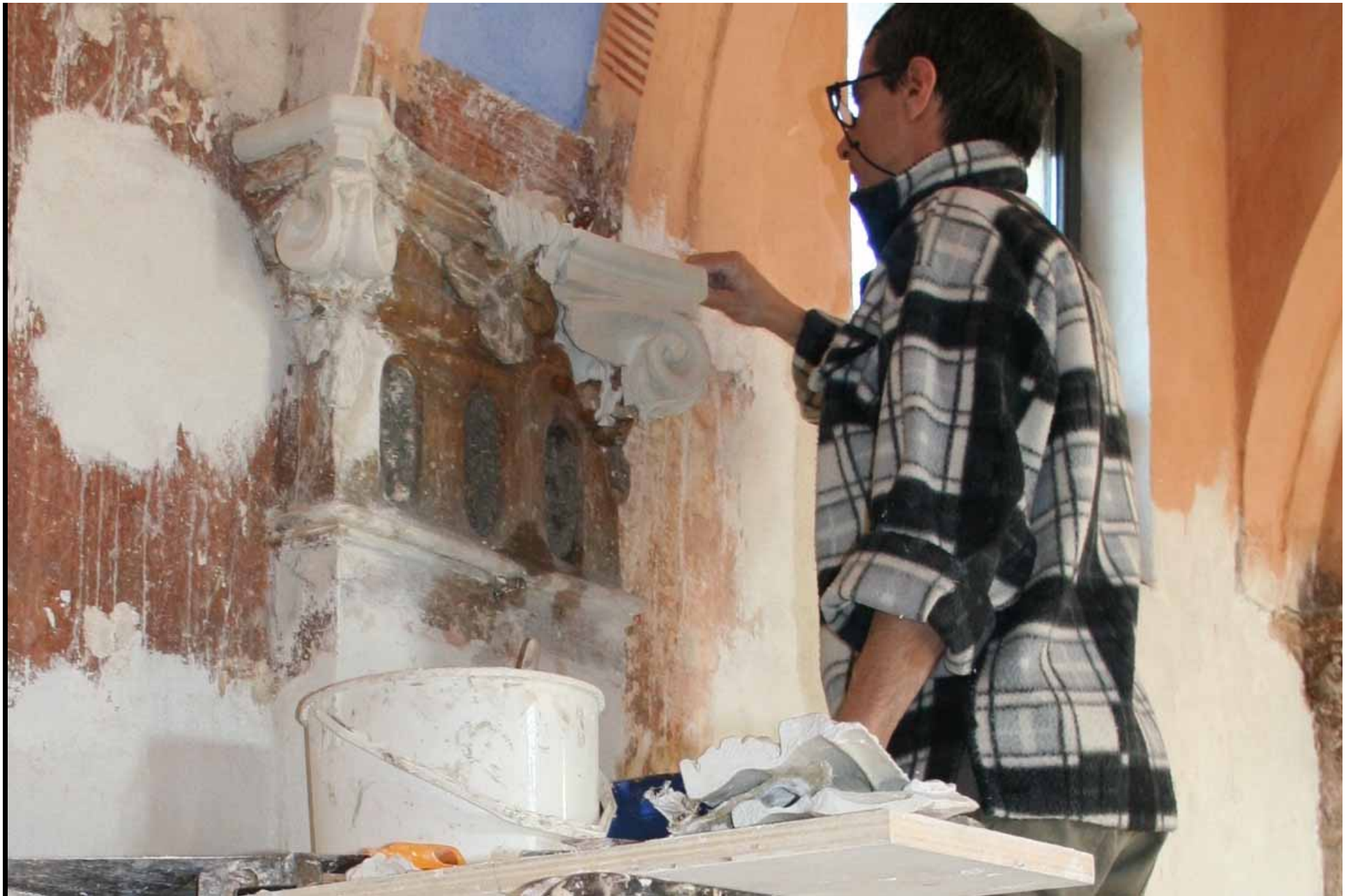
Ripristino delle parti mancanti del capitello riprodotto nella foto precedente
