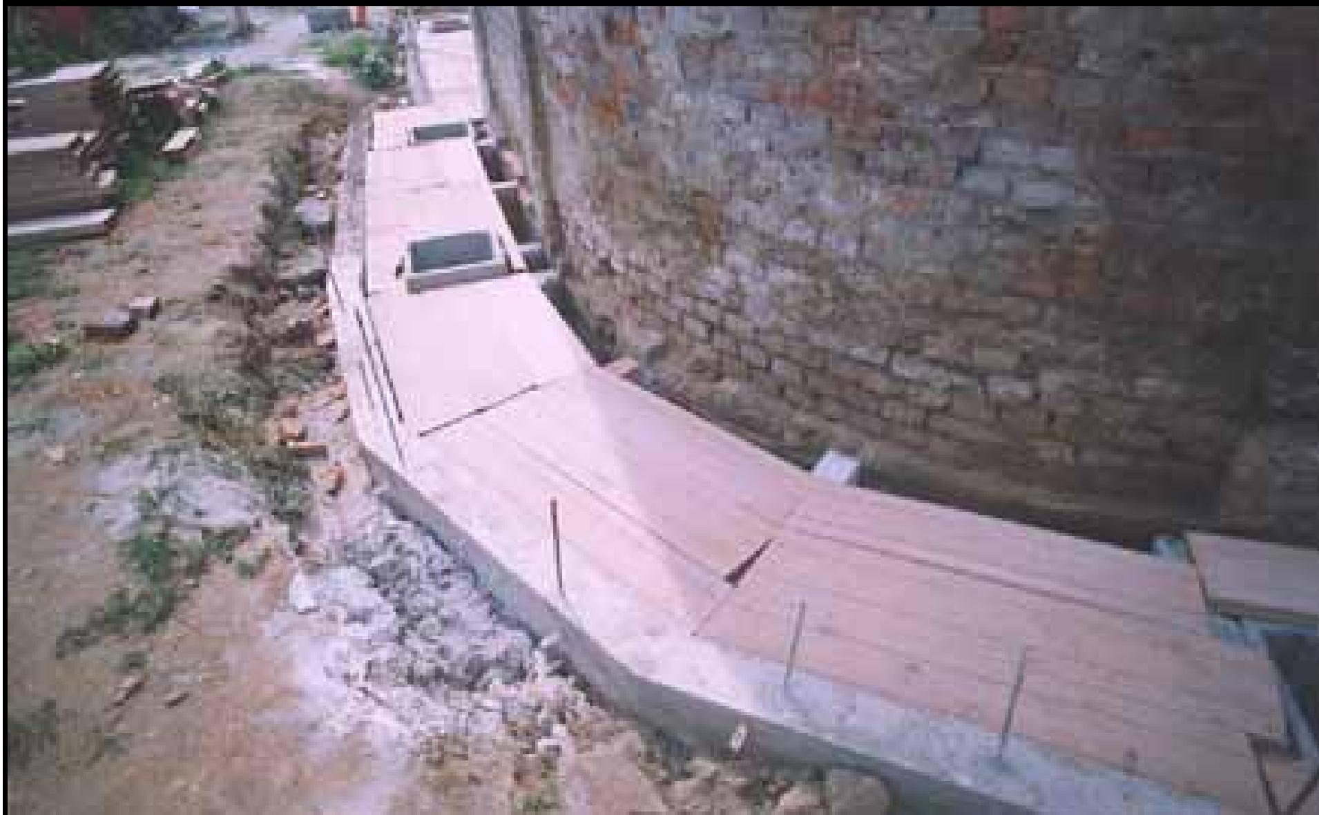
Vista del vespaio aerato attorno alle fondazioni con i pozzetti in corrispondenza dei pluviali, prima del getto della soletta di copertura
