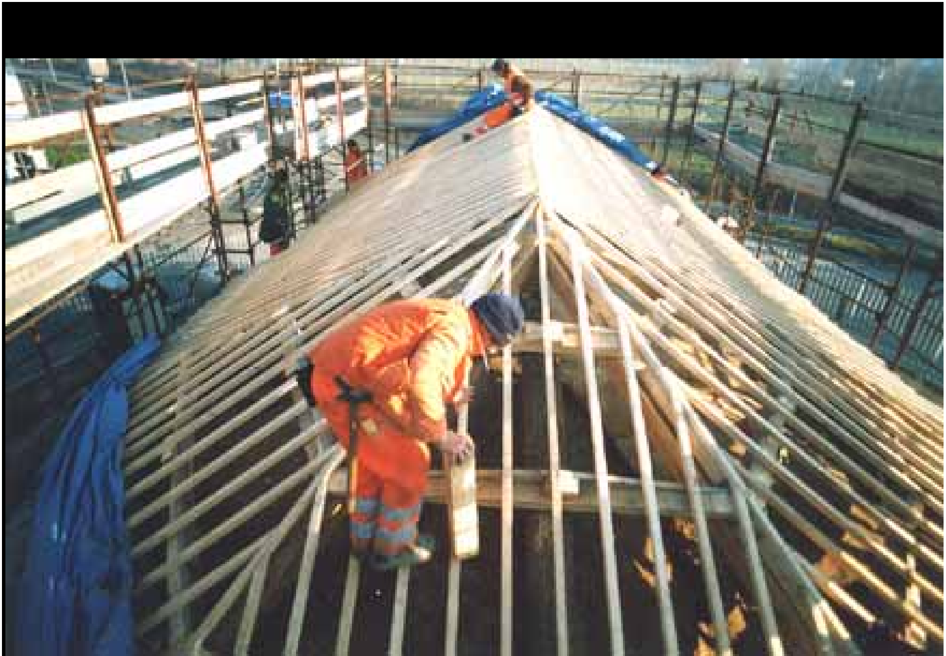
Particolare della posa dei listelli in legno del tetto dal lato dell'abside
