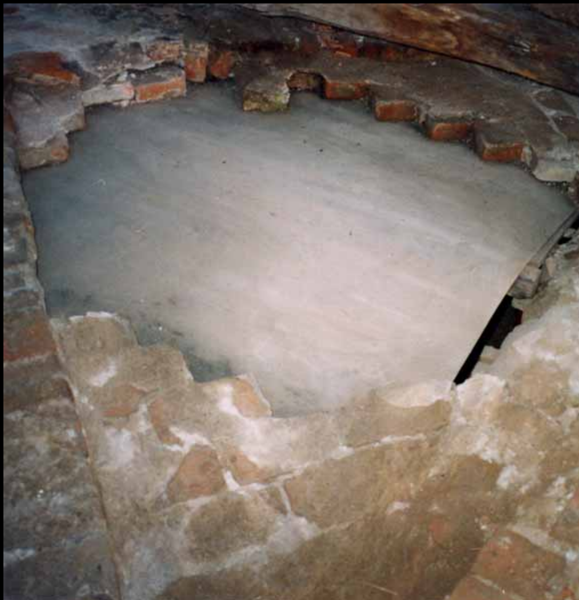
Armatura di legno compensato curvato in corrispondenza della volta sfondata
