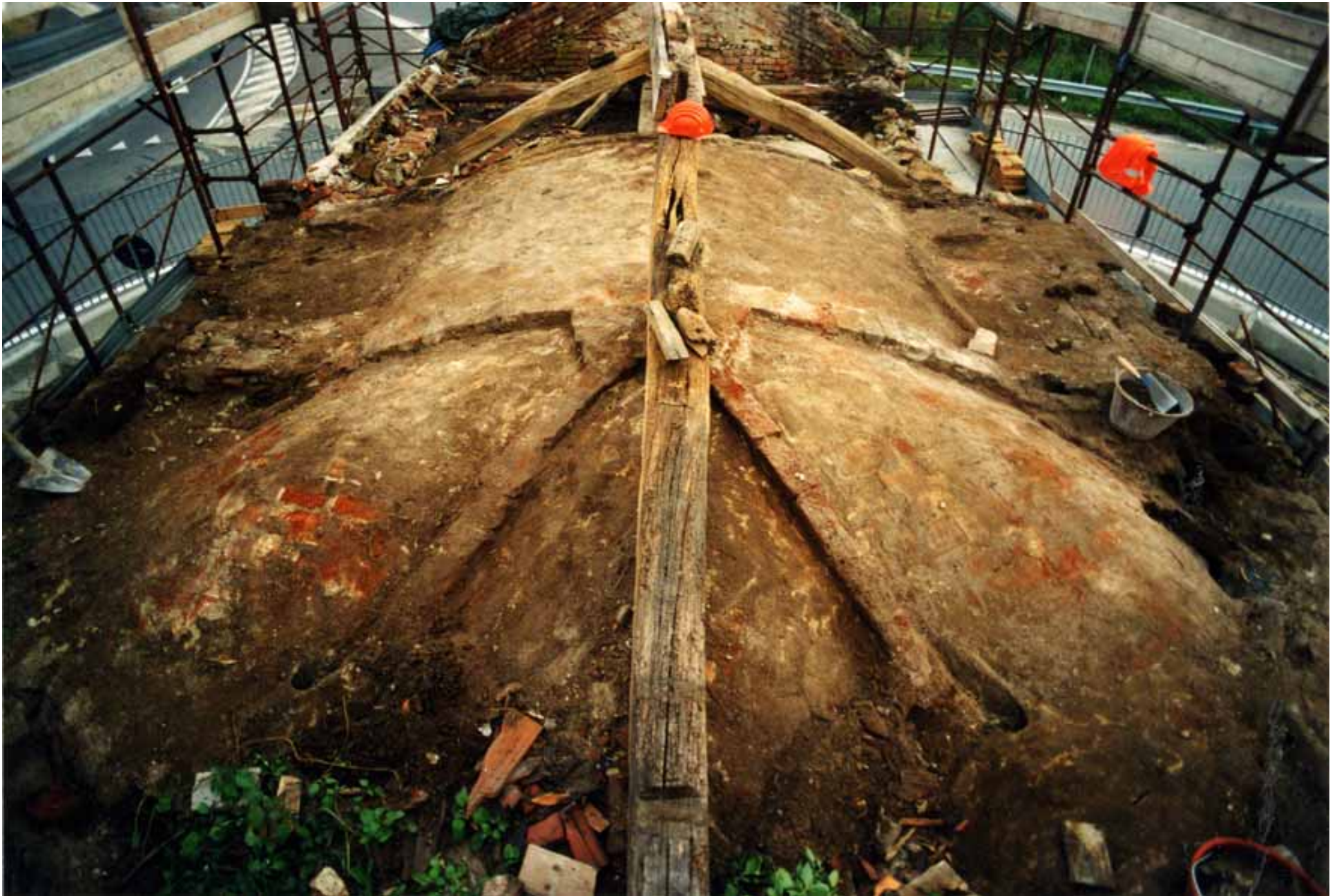
Vista della volta, dal lato dell'abside, dopo la rimozione della carpenteria degradata
