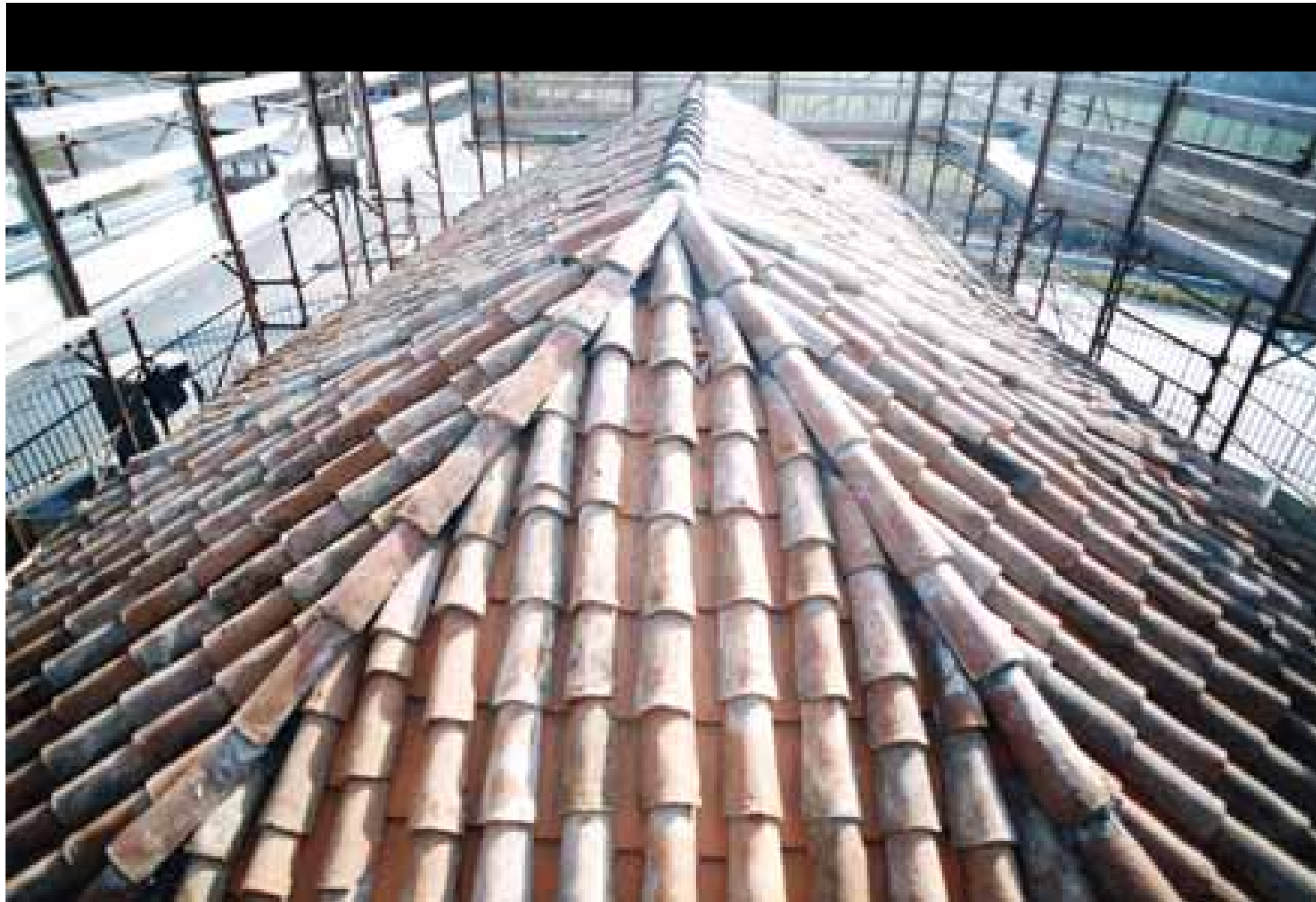
Vista del tetto della Cappella con la posa dei coppi completata, lato abside
