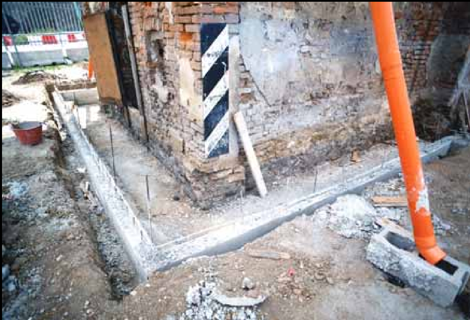
Particolare del muro d'ambito del vespaio aerato, dopo il getto in c.a.
