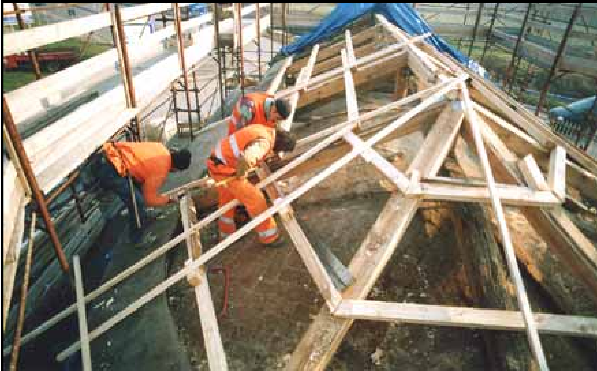
Particolare della posa dei correnti e dei listelli in legno del tetto con la vista della volta e del cordolo sottostante in c.a dell'abside
