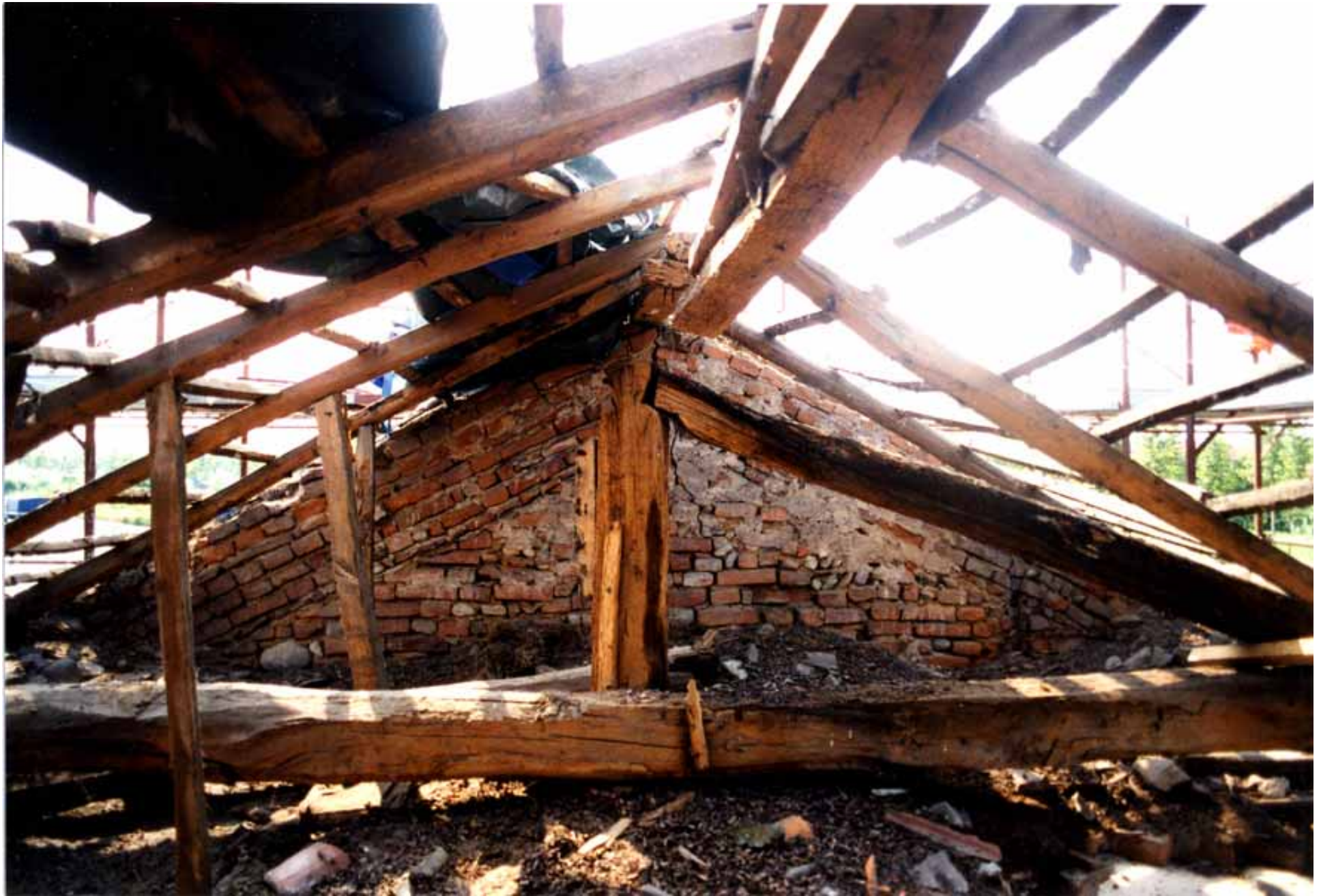
Stato di conservazione della carpenteria sopra la volta sfondata, lato abside
