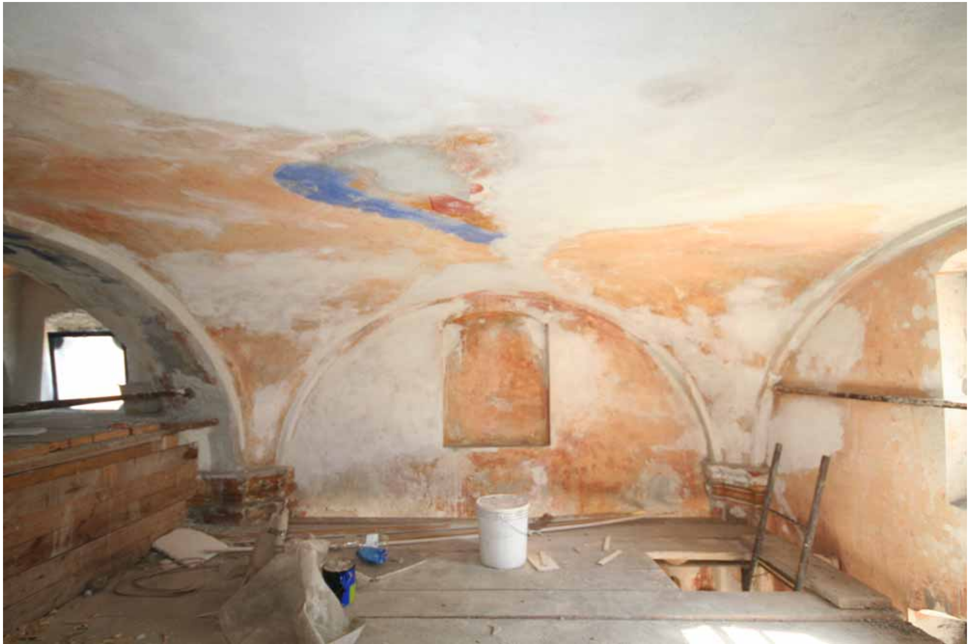
La volta dell'entrata della Cappella, prima del restauro delle coloriture
