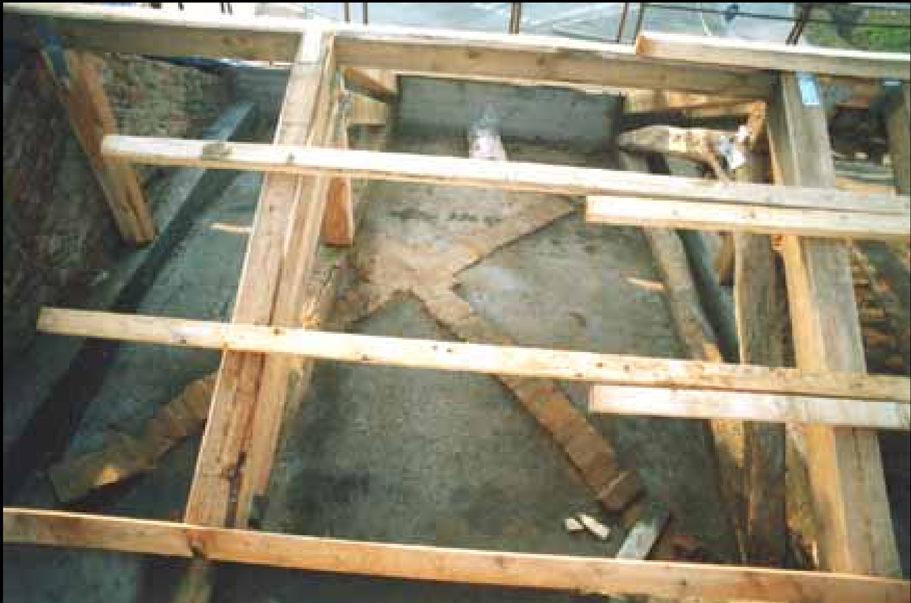
Particolare delle capriate e dei correnti in legno del tetto, dopo il ripristino, con i cordoli trasversali in c.a. e la volta restaurata sottostanti
