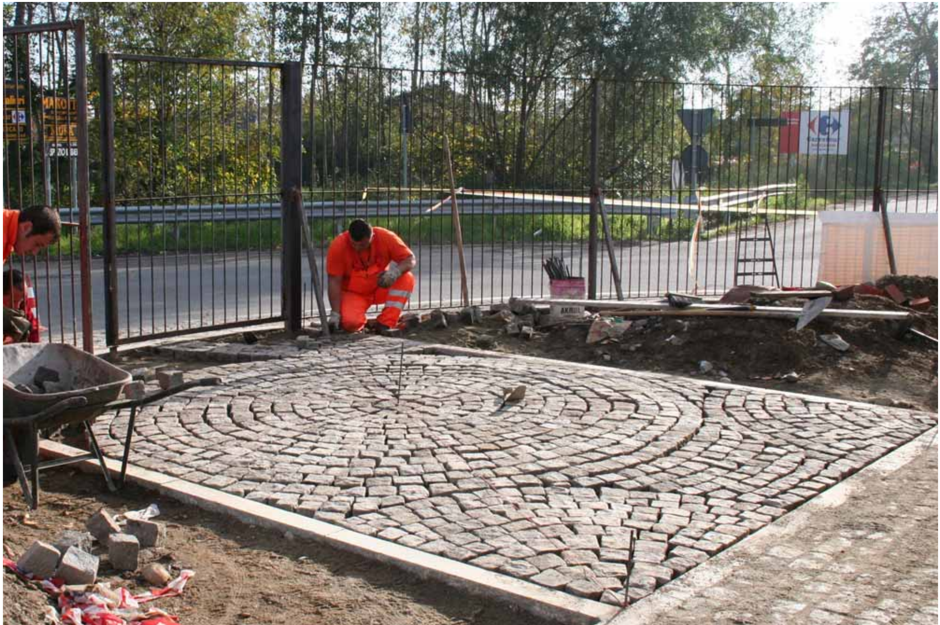
Pavimentazione a selciato dell'ingresso, durante la costruzione
