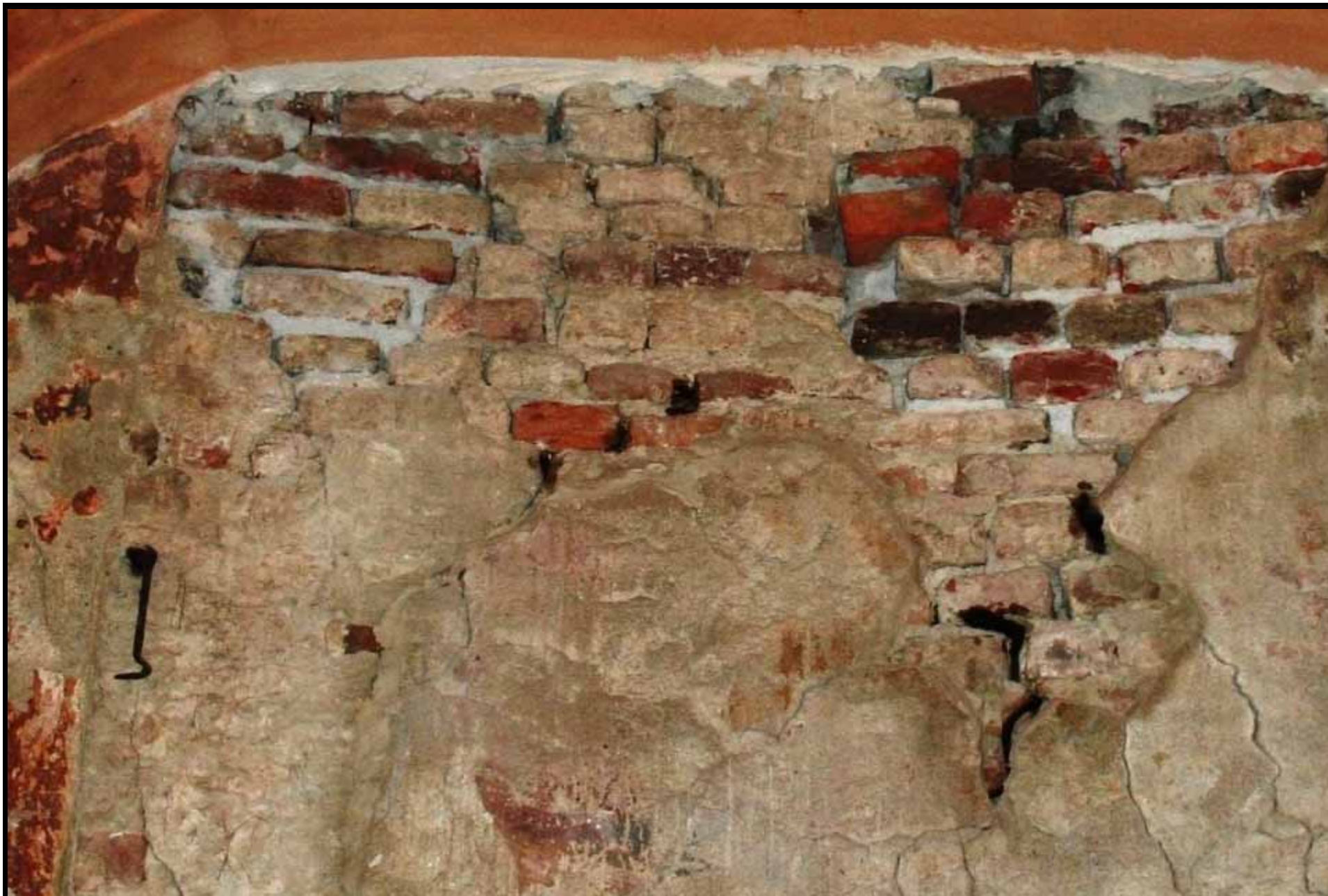
Restauro della muratura della parte alta dell'affresco, dopo la rimozione vegetazione che la invadeva
