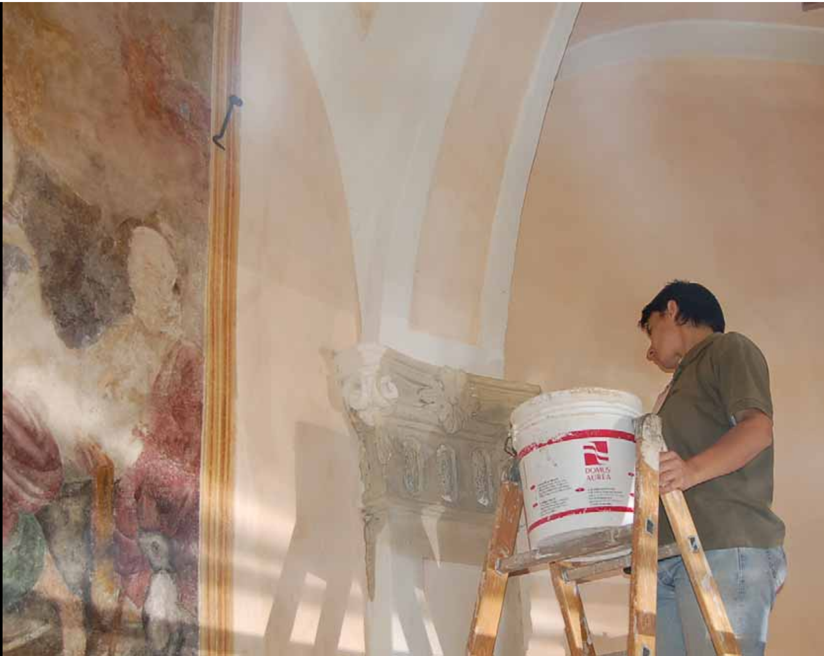
Particolare della coloritura delle pareti e delle volte, in base alle stratigrafie
