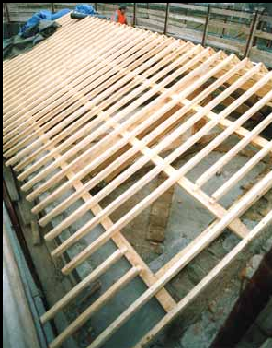
Particolare dei listelli in legno del tetto dal lato dell'ingresso, con la "finestra" prevista per 'ispezione del sottotetto
