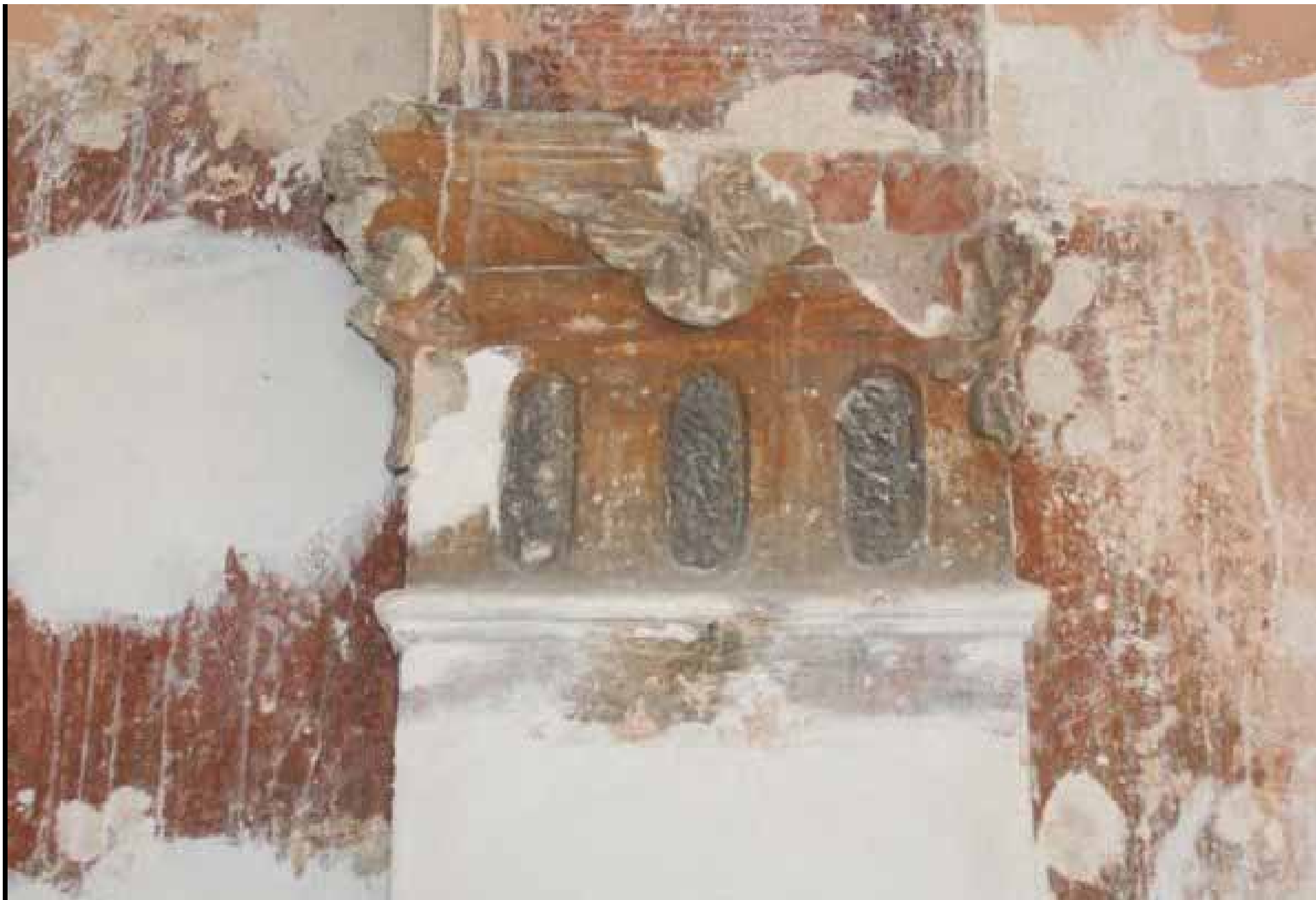
Stato di conservazione dei capitelli in stucco dell'abside
