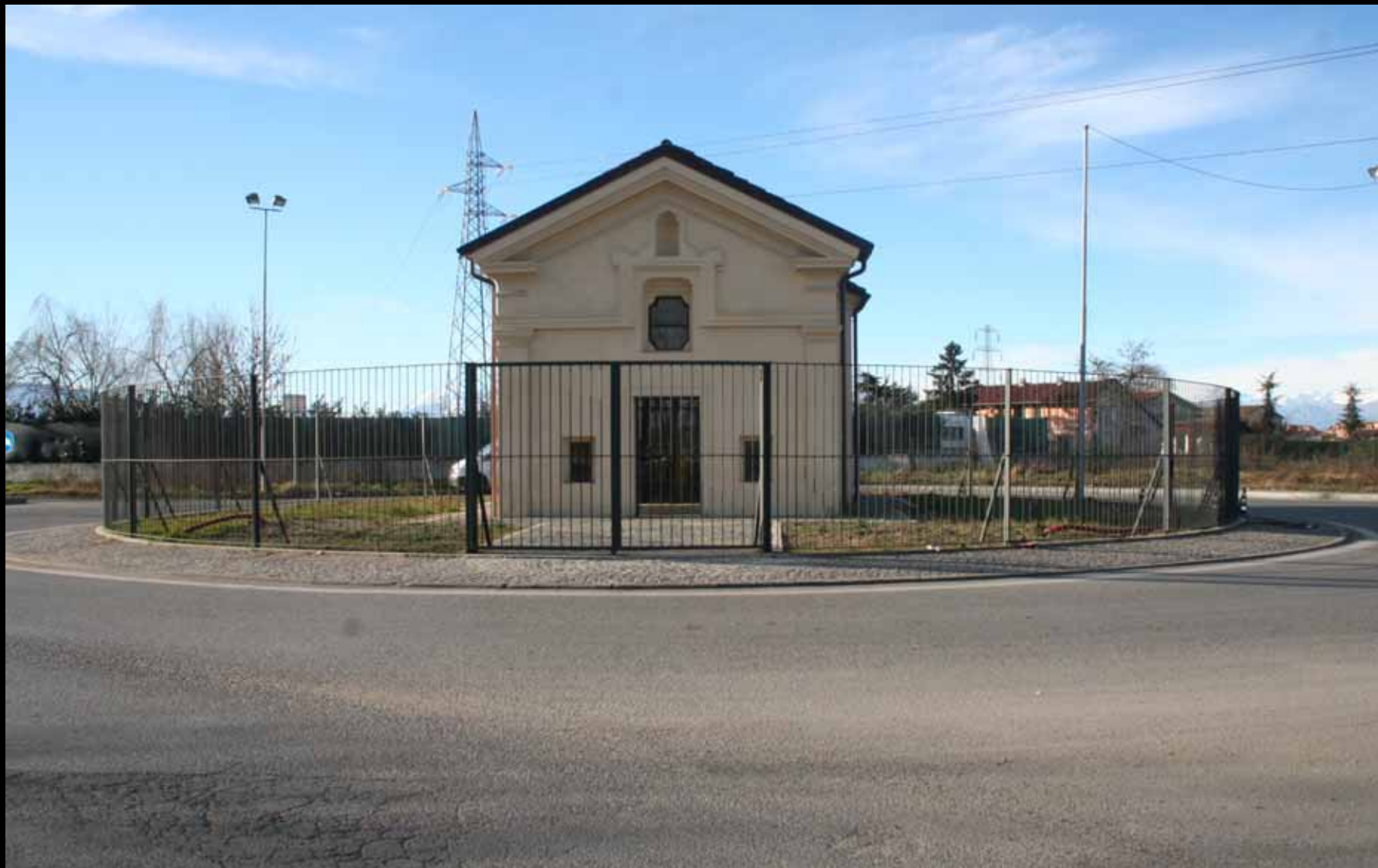
Vista generale della Cappella San Rocco dopo i restauri dell'esterno
