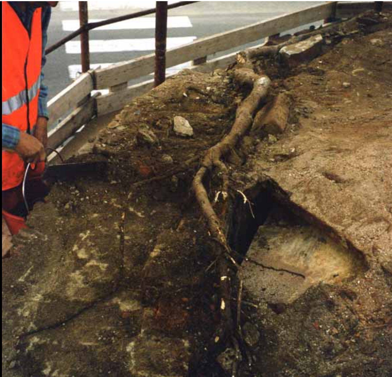
Stato di conservazione della volta dell'abside, invasa dalla vegetazione
