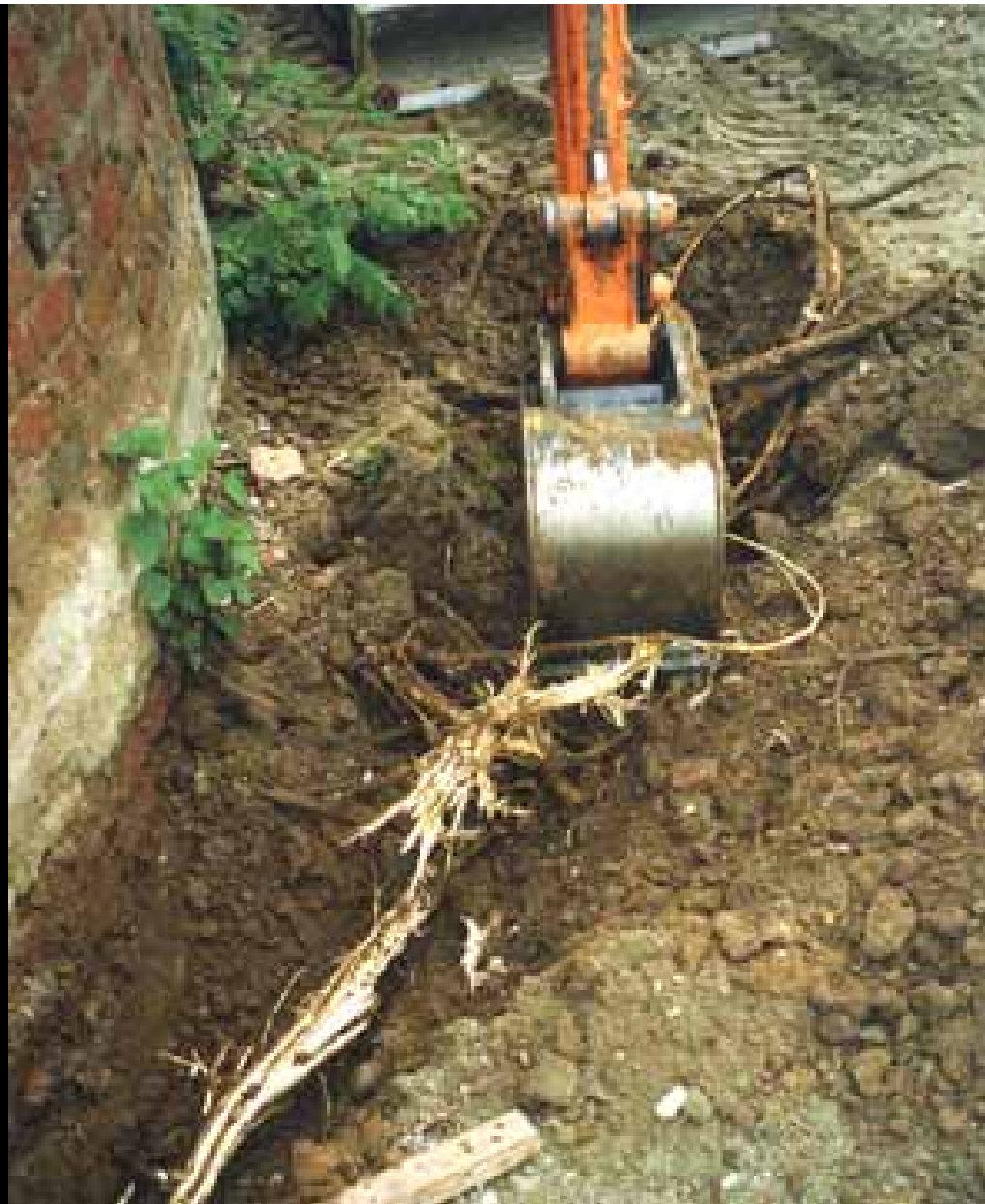
Vista dello scavo del vespaio attorno alle fondazioni ,con la rimozione della vegetazione
