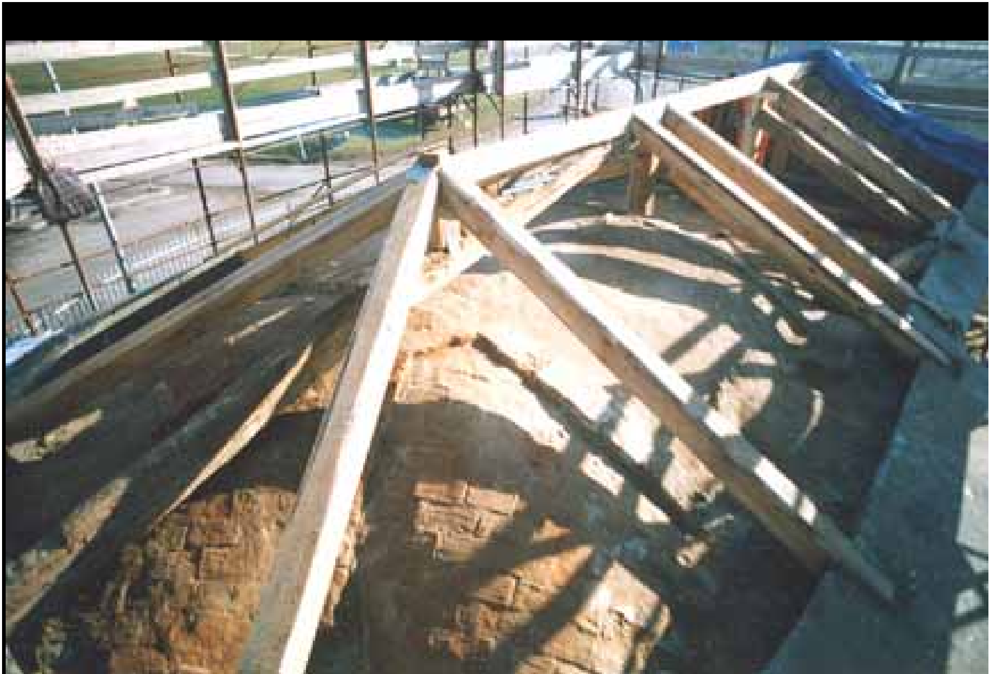
Vista dall'abside del ripristino del colmo e dei punti in legno del tetto, con il particolare del puntone originario connesso con il colmo e i con i punti
