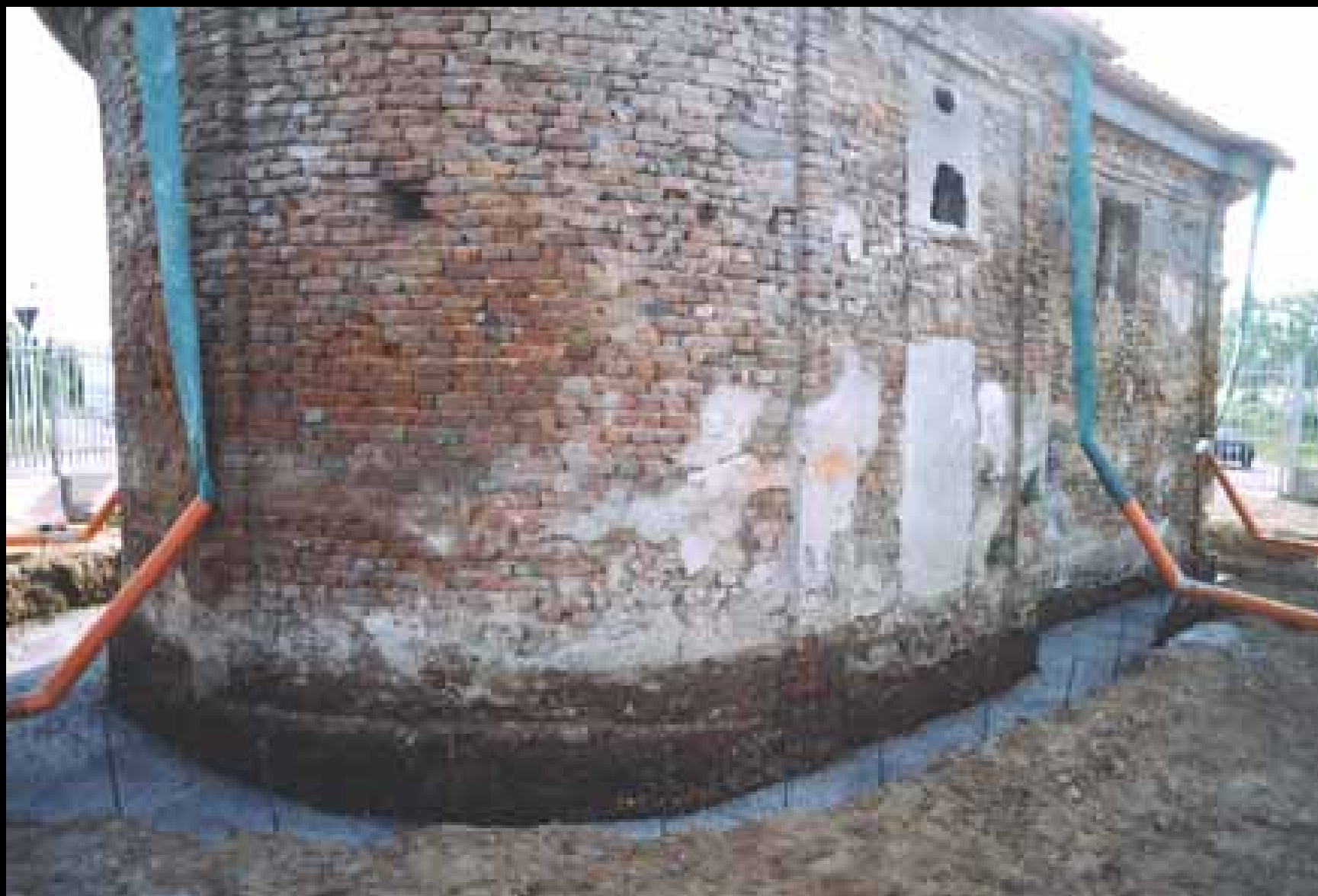
Vista dello scavo attorno alle fondazioni, per la formazione del vespaio aerato, con il getto in c.a. del sottofondo
