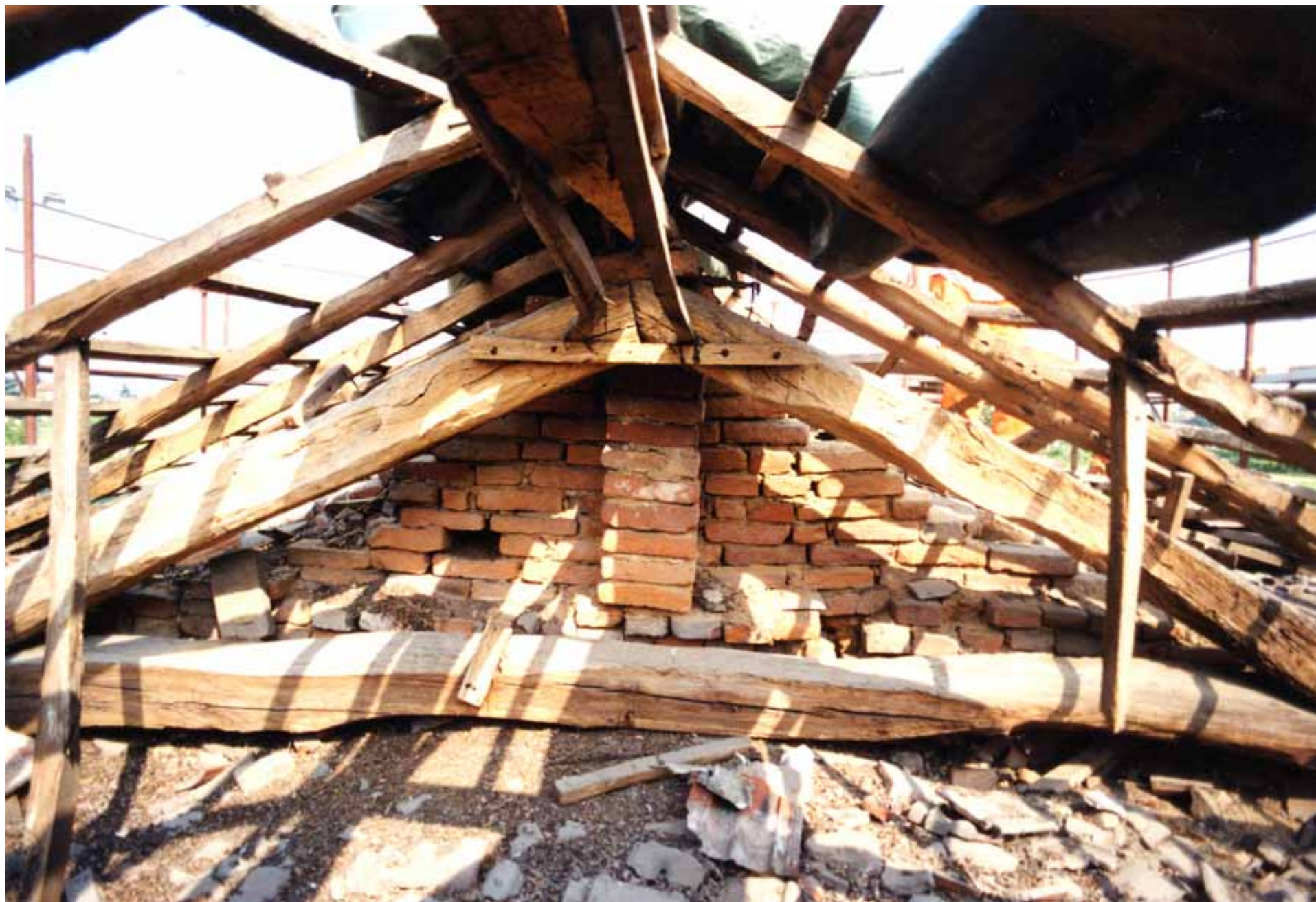
Stato di conservazione della carpenteria sopra la volta sfondata, lato facciata
