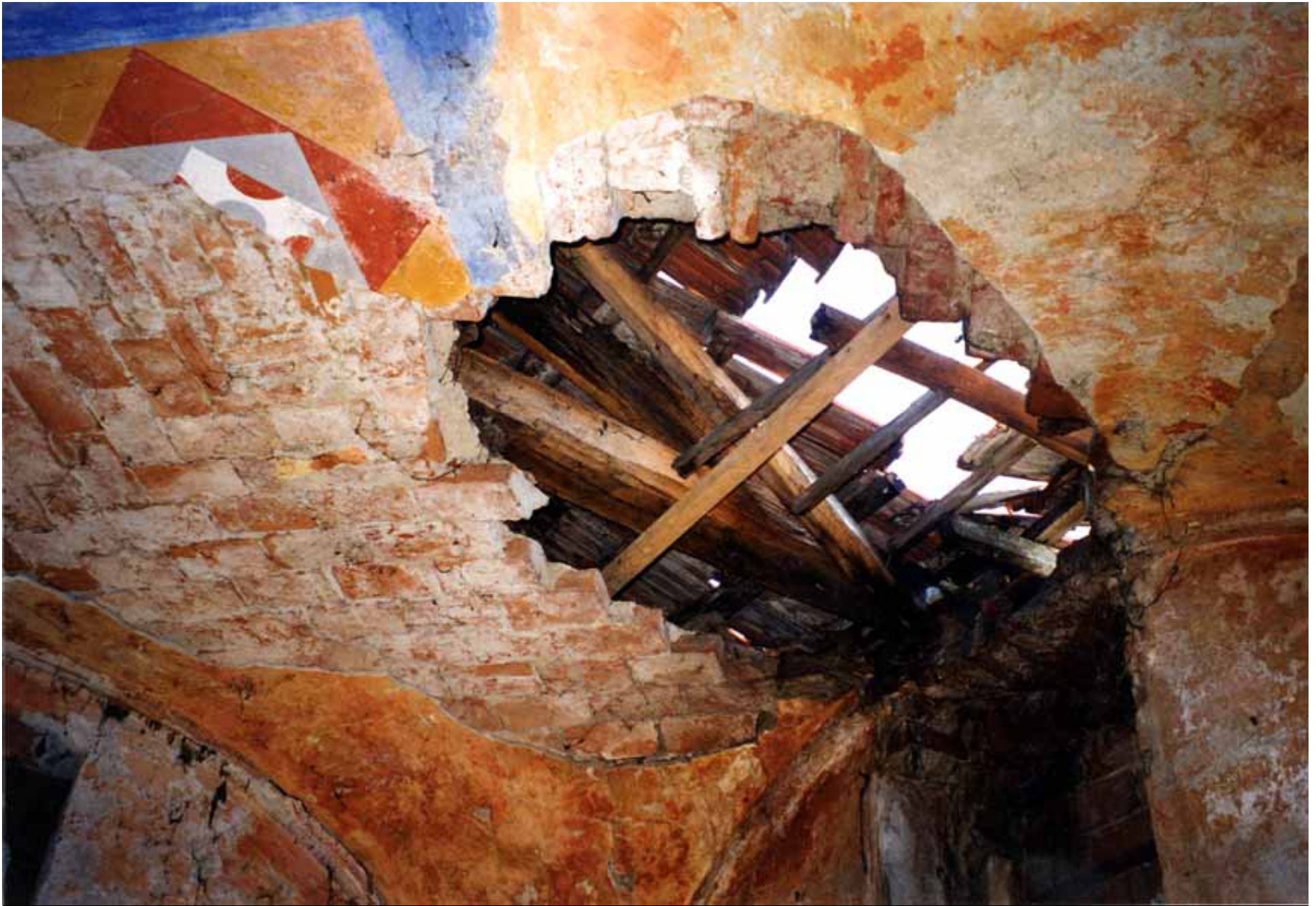
Particolare della volta crollata
