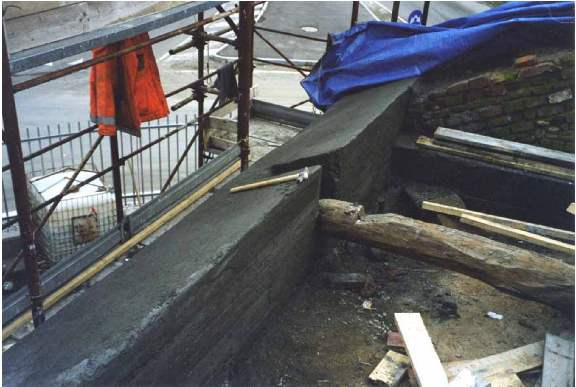
Vista del cordolo in c.a. dopo il getto, in corrispondenza della catene di una capriata
