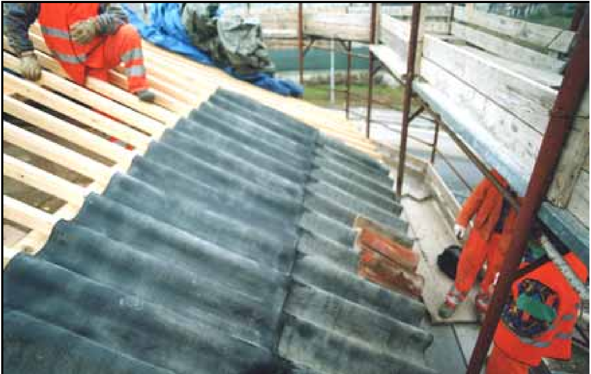
Particolare dell'impermeabilizzazione del tetto, mediante guaina catramata, prima della posa dei coppi
