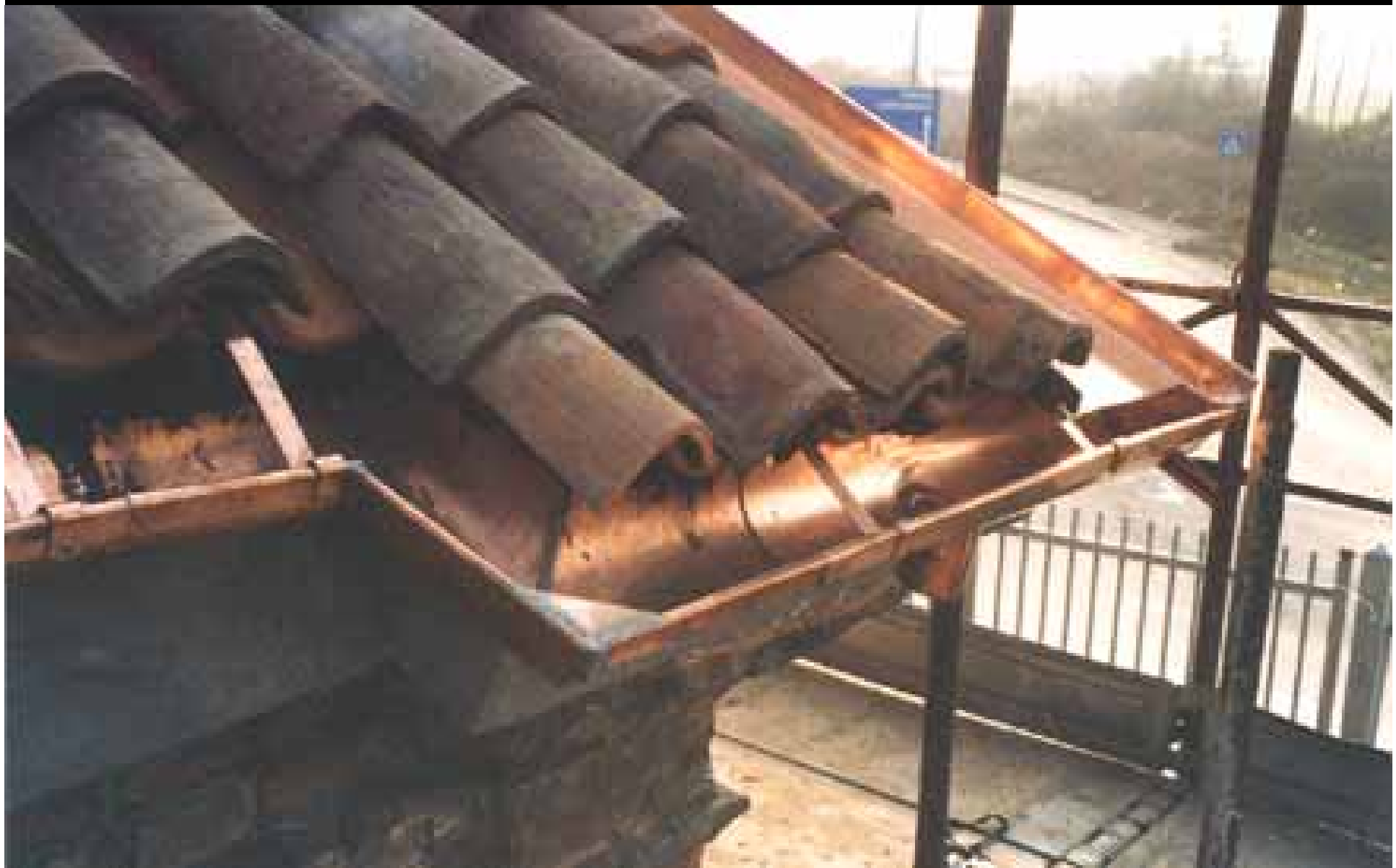
Particolare del tetto con la gronda in rame dal lato dell'ingresso
