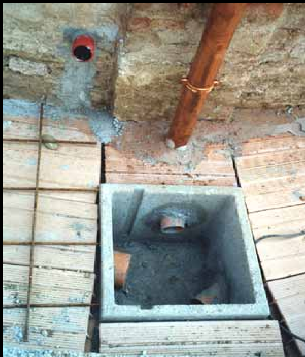
Particolare di un pozzetto in corrispondenza del pluviali, con le tubazioni di scarico
