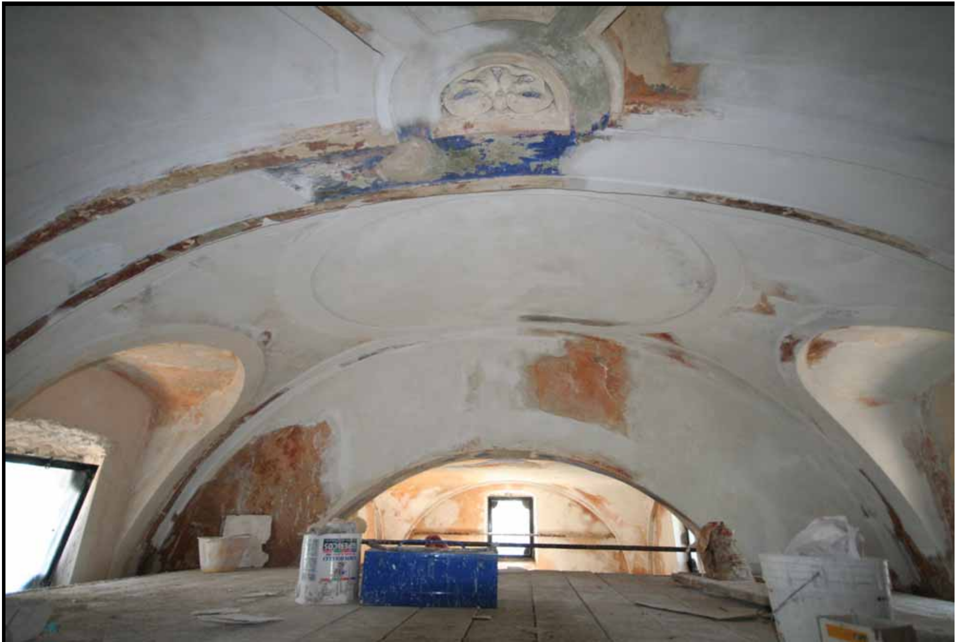
Le volte della sala centrale e dell'abside, prima del restauro delle coloriture
