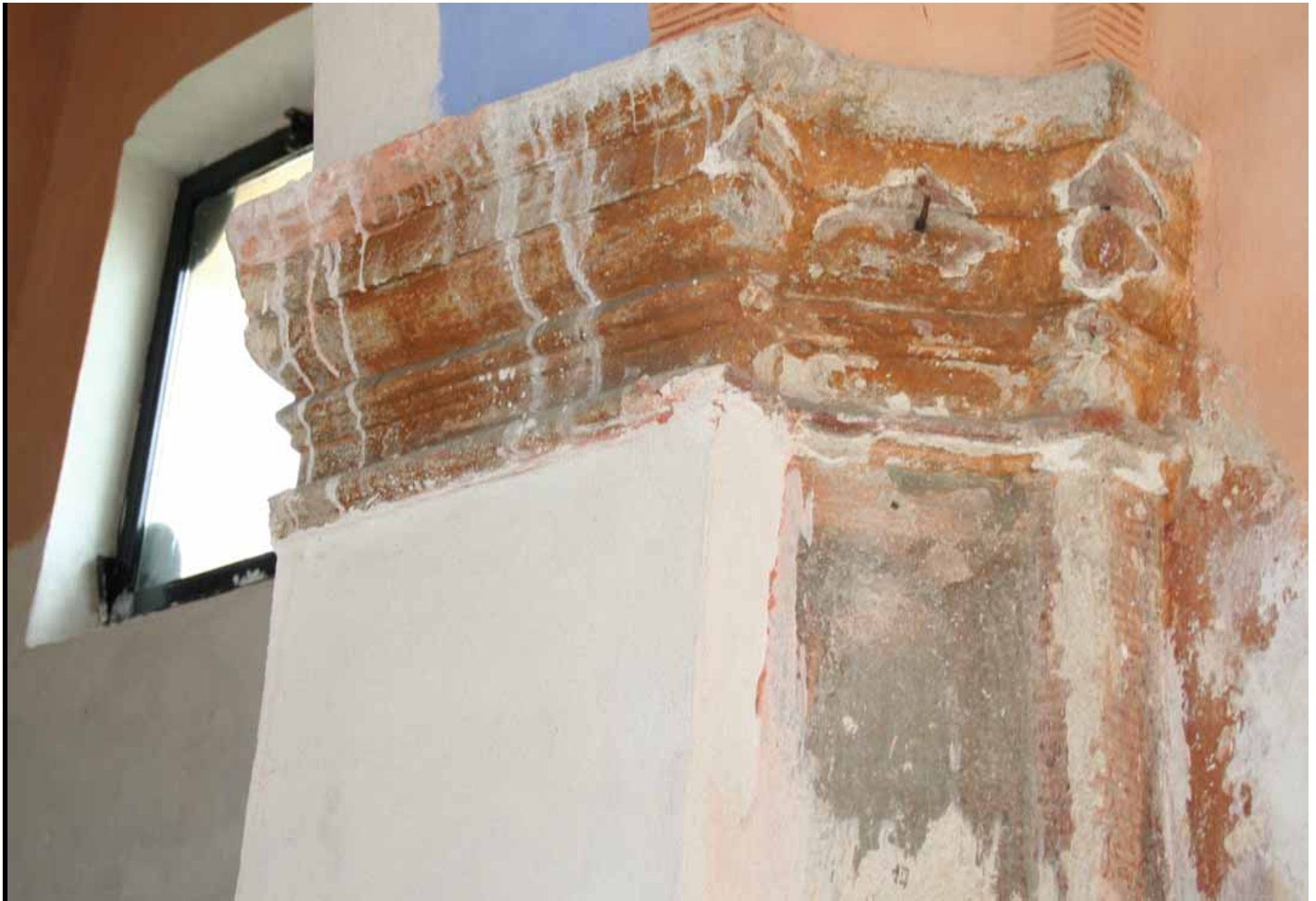
Uno dei capitelli in stucco dell'abside totalmente scomparso
