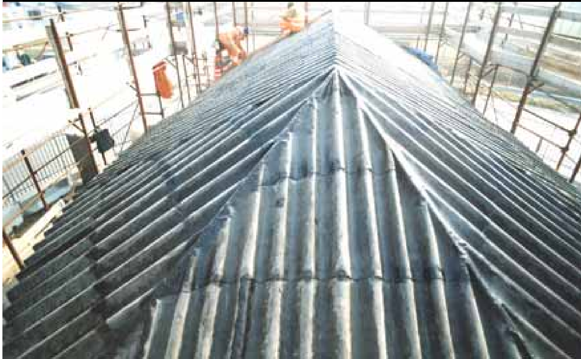
Vista dall'abside dell'impermeabilizzazione del tetto, prima della posa dei coppi
