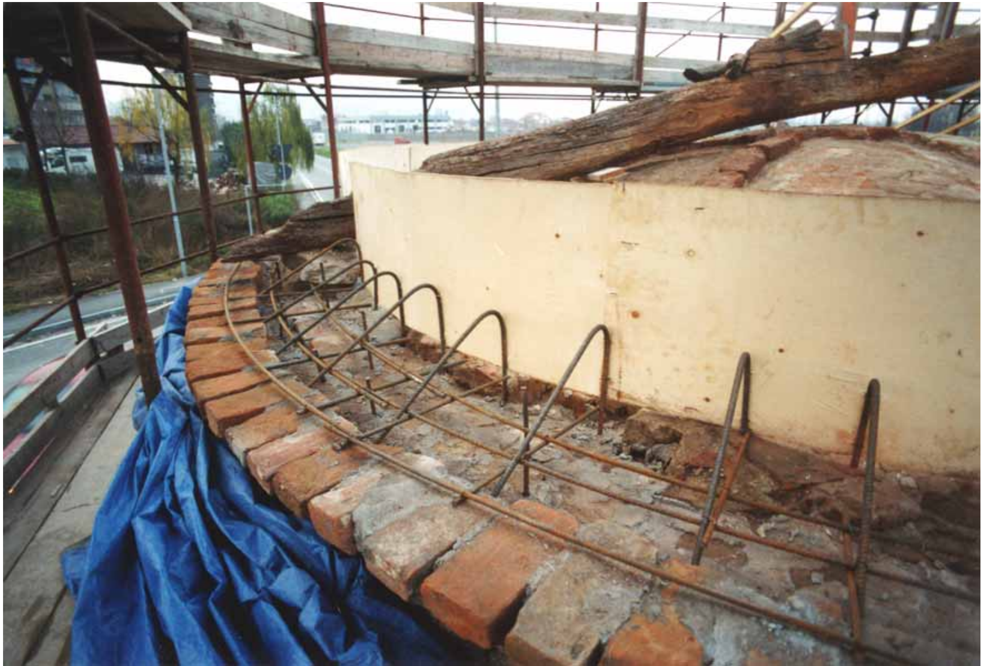
Vista dall'alto dell'armatura del cordolo in c.a., in corrispondenza dell'abside
