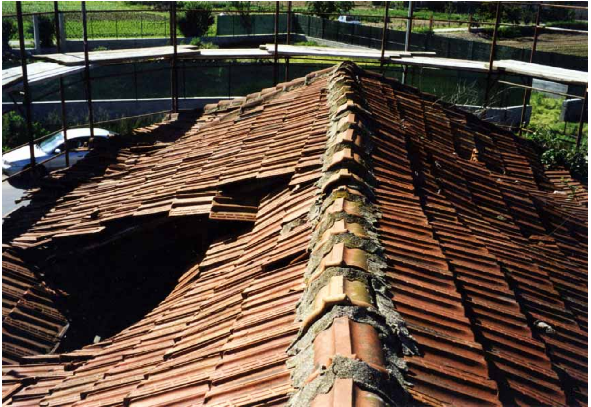
Stato di conservazione della copertura lato sud. prima del restauro
