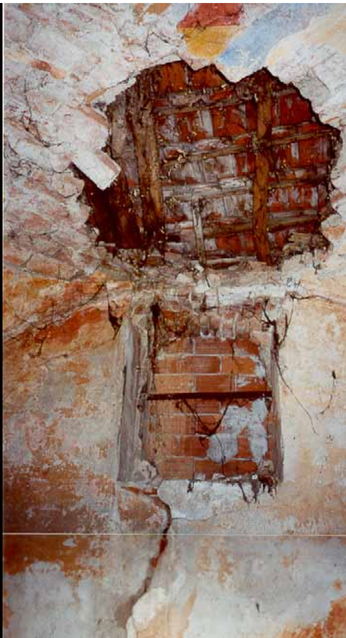
Vista dell'interno della Cappella dalla parte dell'ingresso con la volta parzialmente crollata
