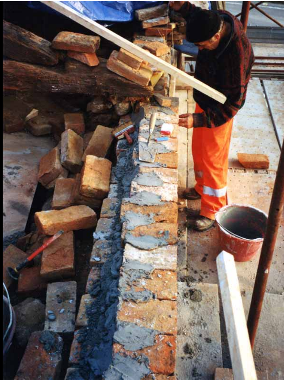
Particolare del ripristino del cornicione nella parte anteriore della Cappella
