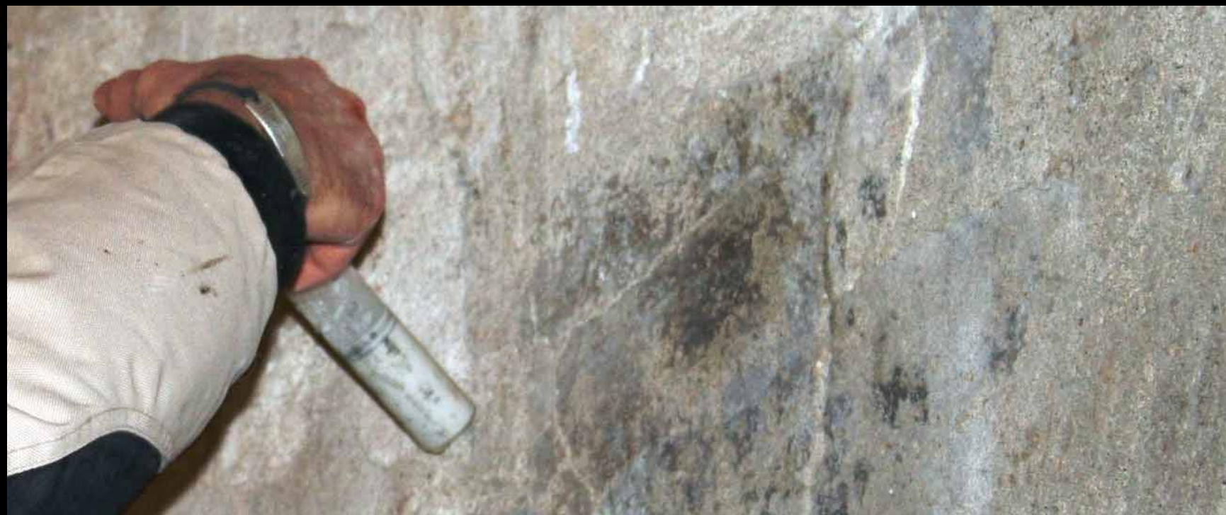
Infiltrazioni con apposita siringa ,per stabilizzare le parti di intonaco decoeso
