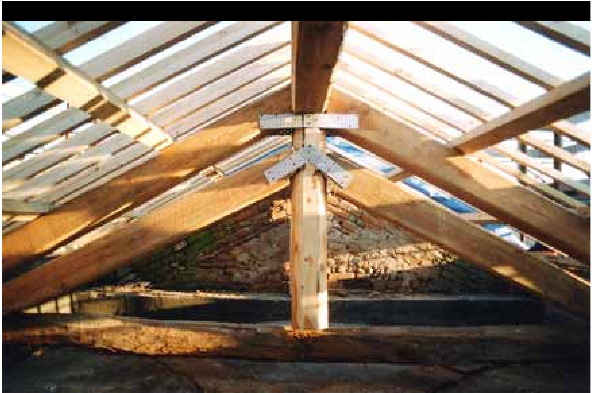
Particolare del sottotetto, dopo la posa dei correnti e dei listelli in legno con la vista delle capriate, in corrispondenza della volta restaurata
