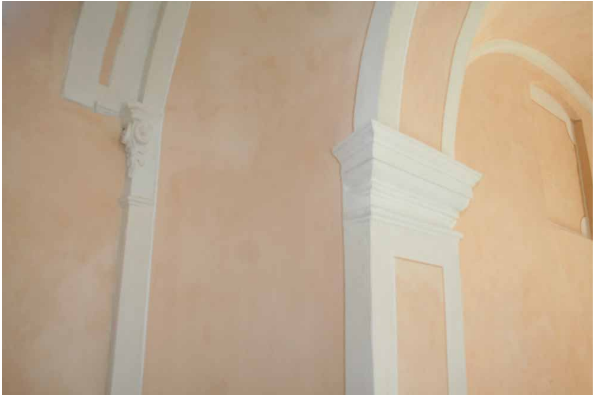
Particolari delle lesene e degli stucchi delle pareti delle volte, dopo il ripristino delle coloriture originarie
