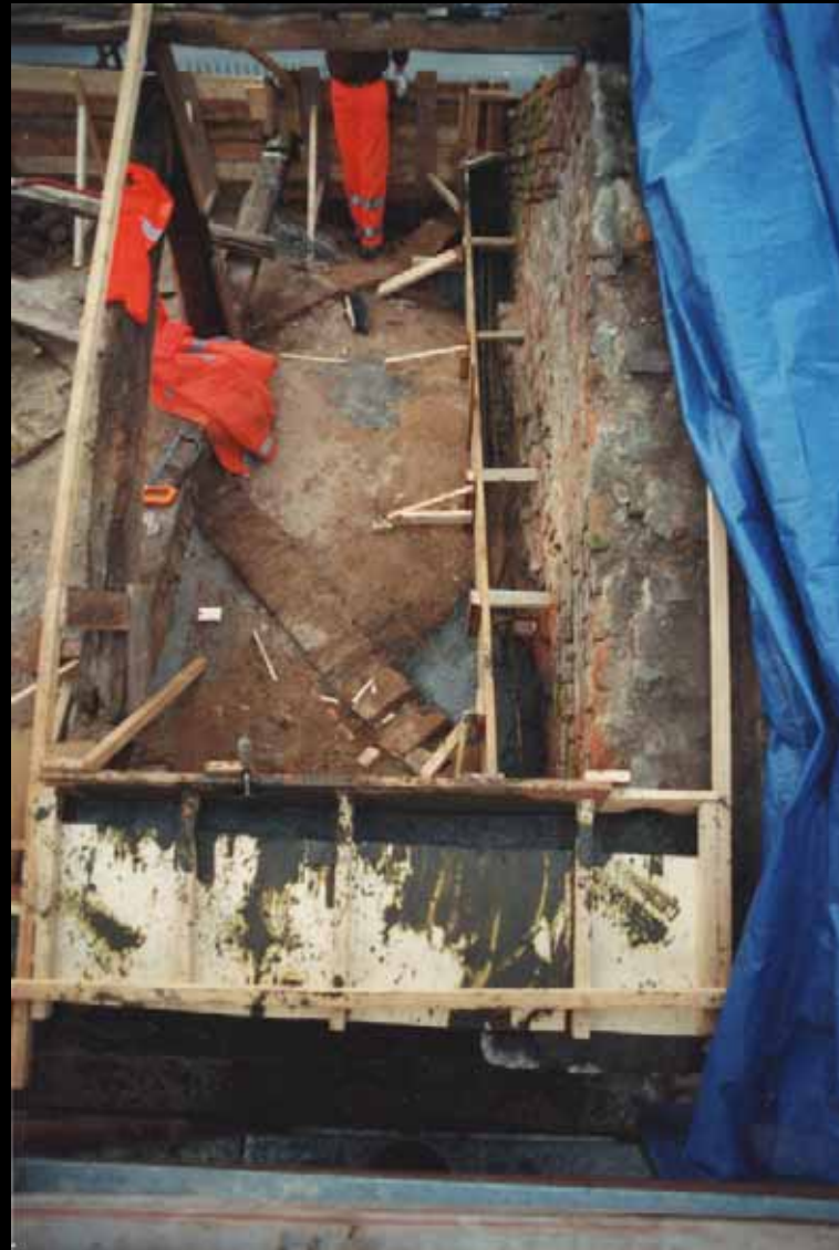
Particolare dell'armatura del cordolo trasversale in c.a., a livello del cornicione, in corrispondenza del retro della facciata
