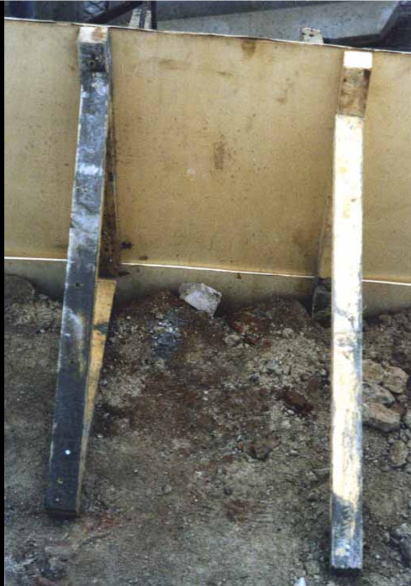
Particolare del supporto dell'armatura del cordolo in c.a. con fogli di compensato curvato, in corrispondenza dell' abside
