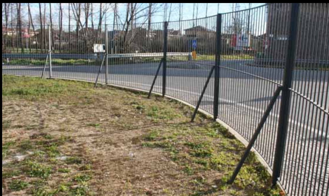
Lavori di finitura del cancello carrabile e della cancellata
