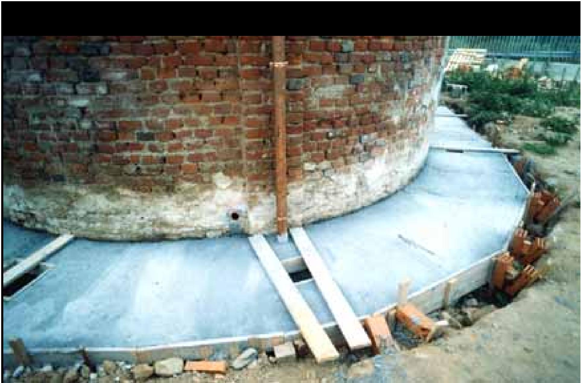
Vista del vespaio aerato attorno alle fondazioni dell'abside con i pozzetti in corrispondenza dei pluviali, dopo il getto della soletta di copertura
