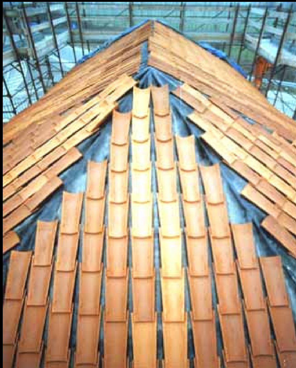
Vista del tetto dall'abside, con la posa del corso inferiore dei coppi
