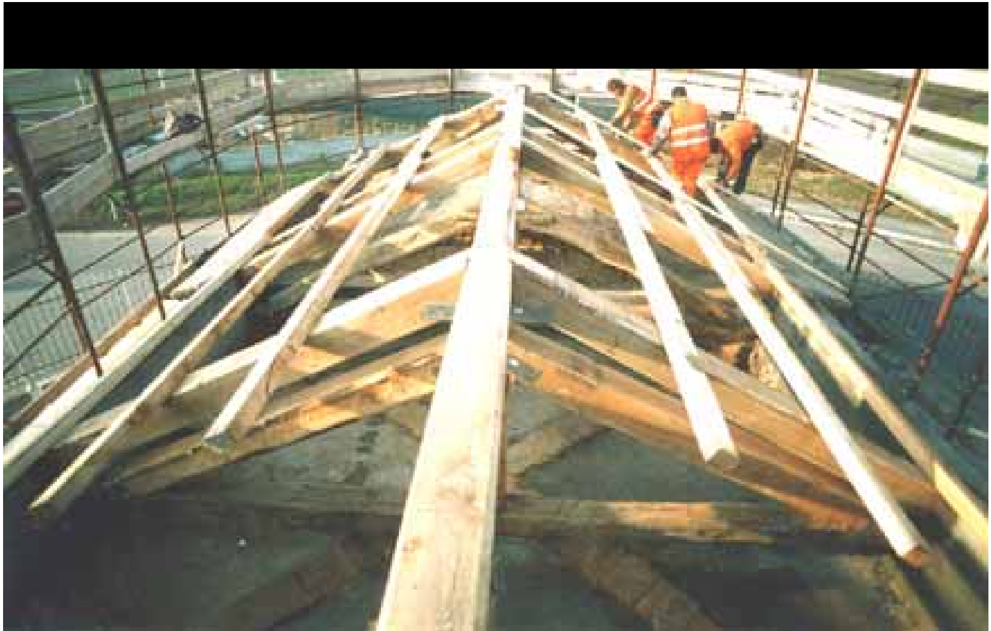
Particolare della posa dei correnti in legno del tetto, con la vista delle capriate e della volta restaurata sottostanti
