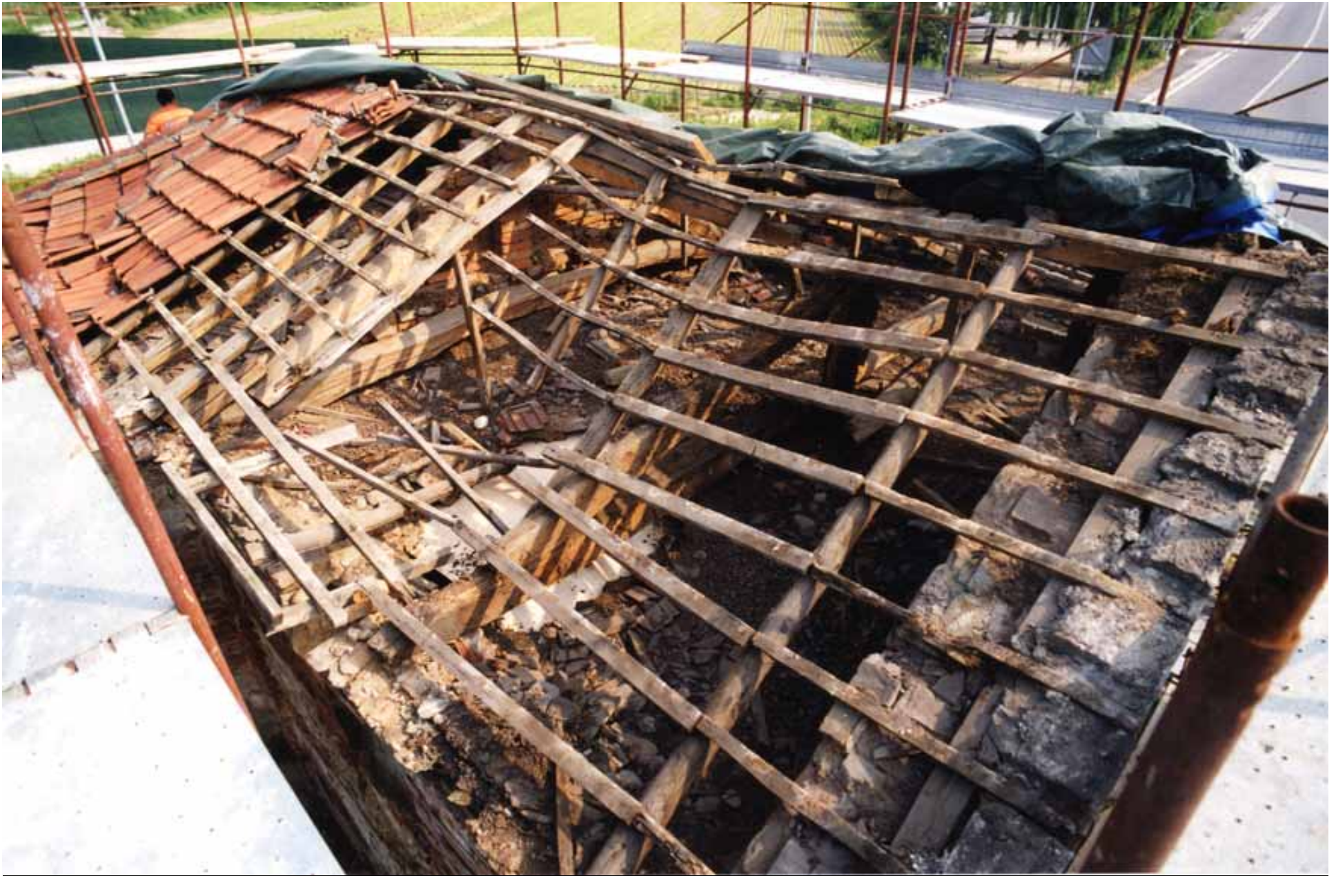
La rimozione delle tegole e la messa in luce del sottotetto
