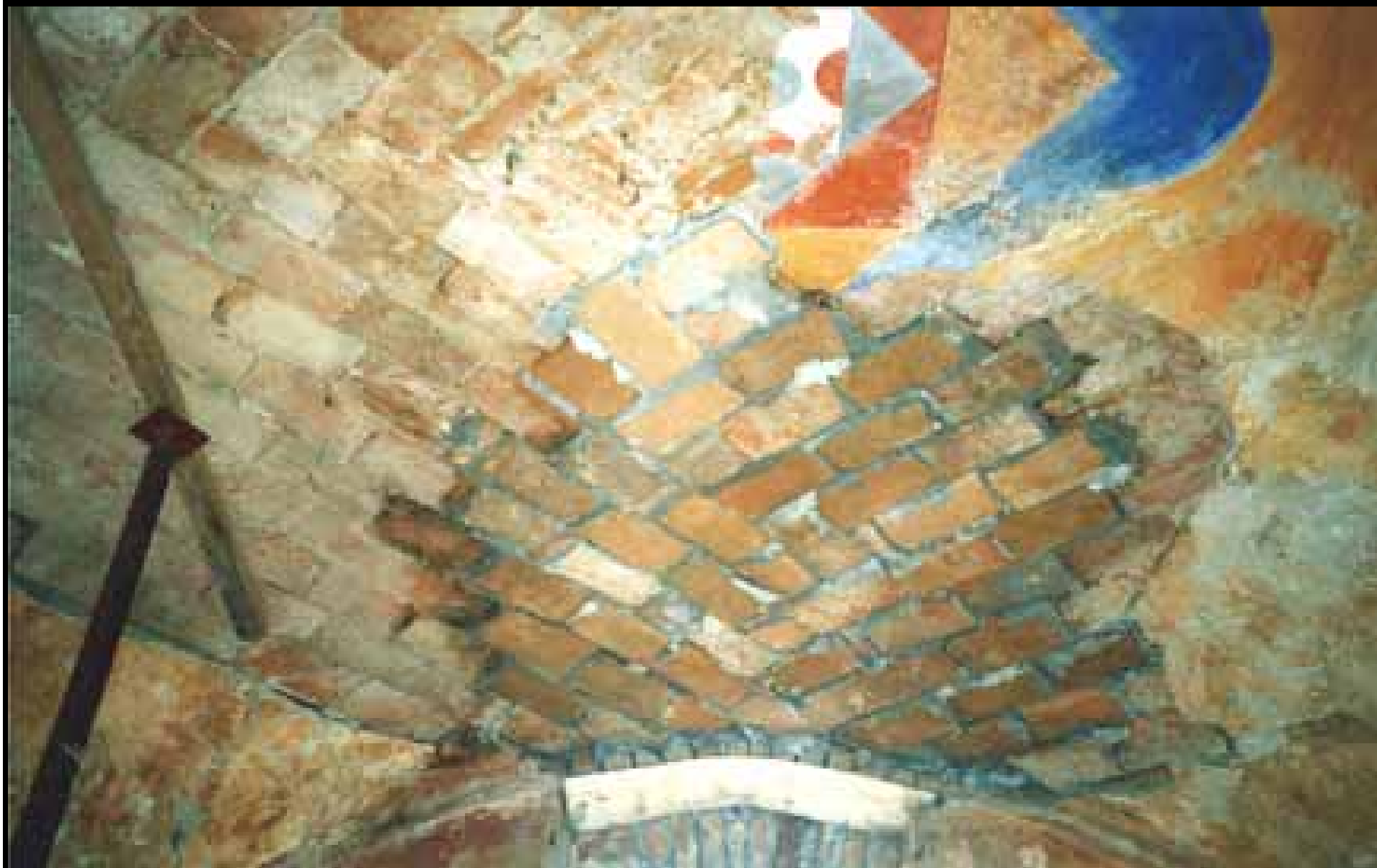
Particolare della volta restaurata, dopo la rimozione del puntellamento
