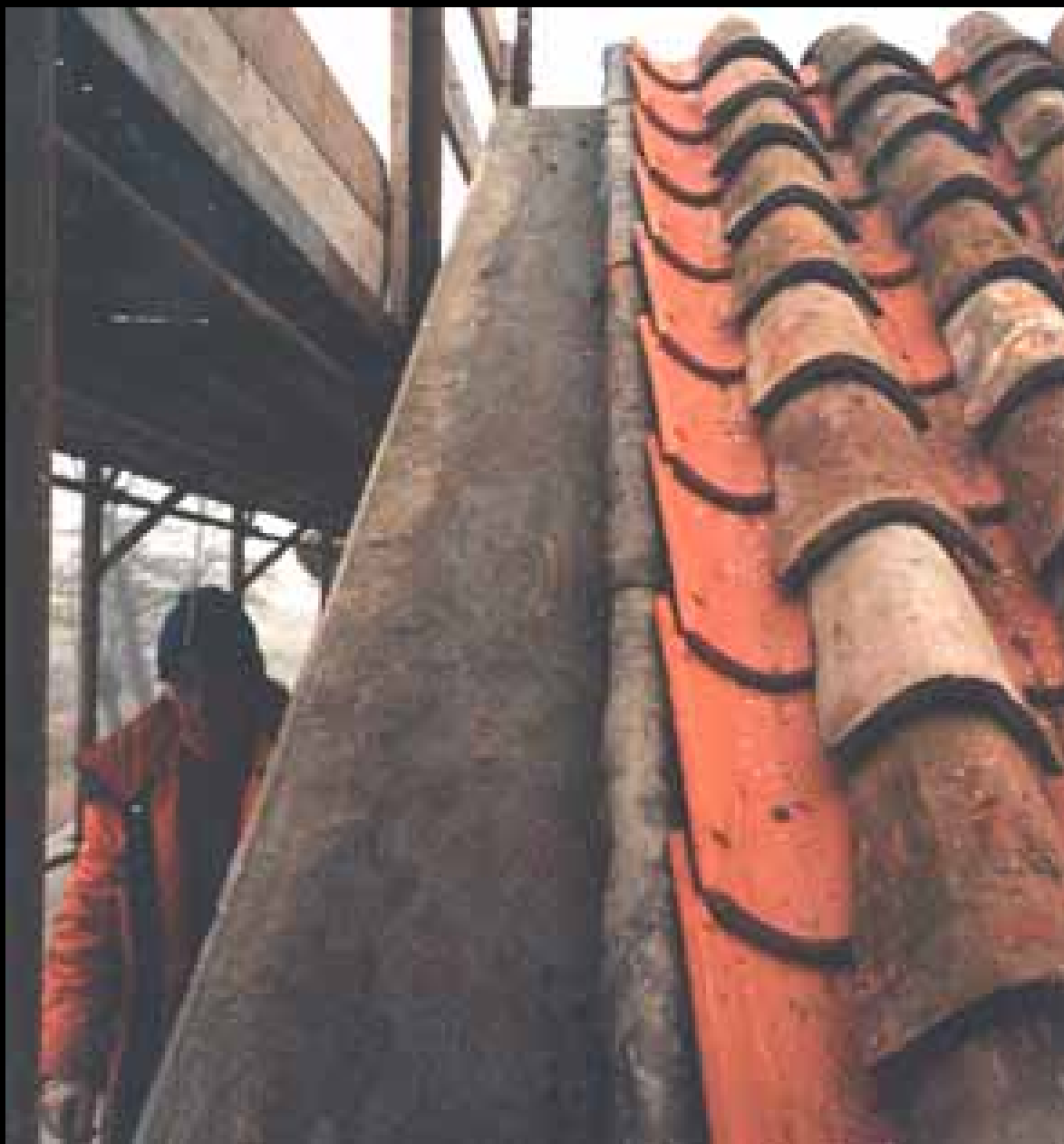
Particolare dei coppi, dal lato dell'ingresso, prima della posa della faldaleria in rame
