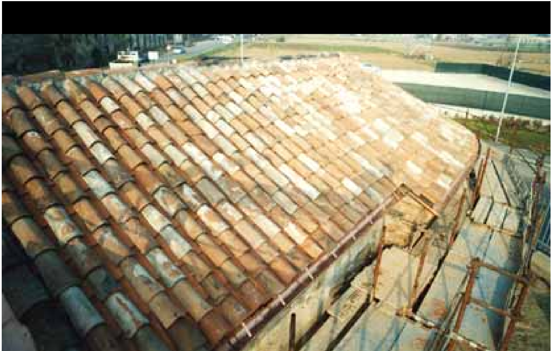
Vista del tetto della Cappella con i coppi e le gronde in rame, lato ingresso
