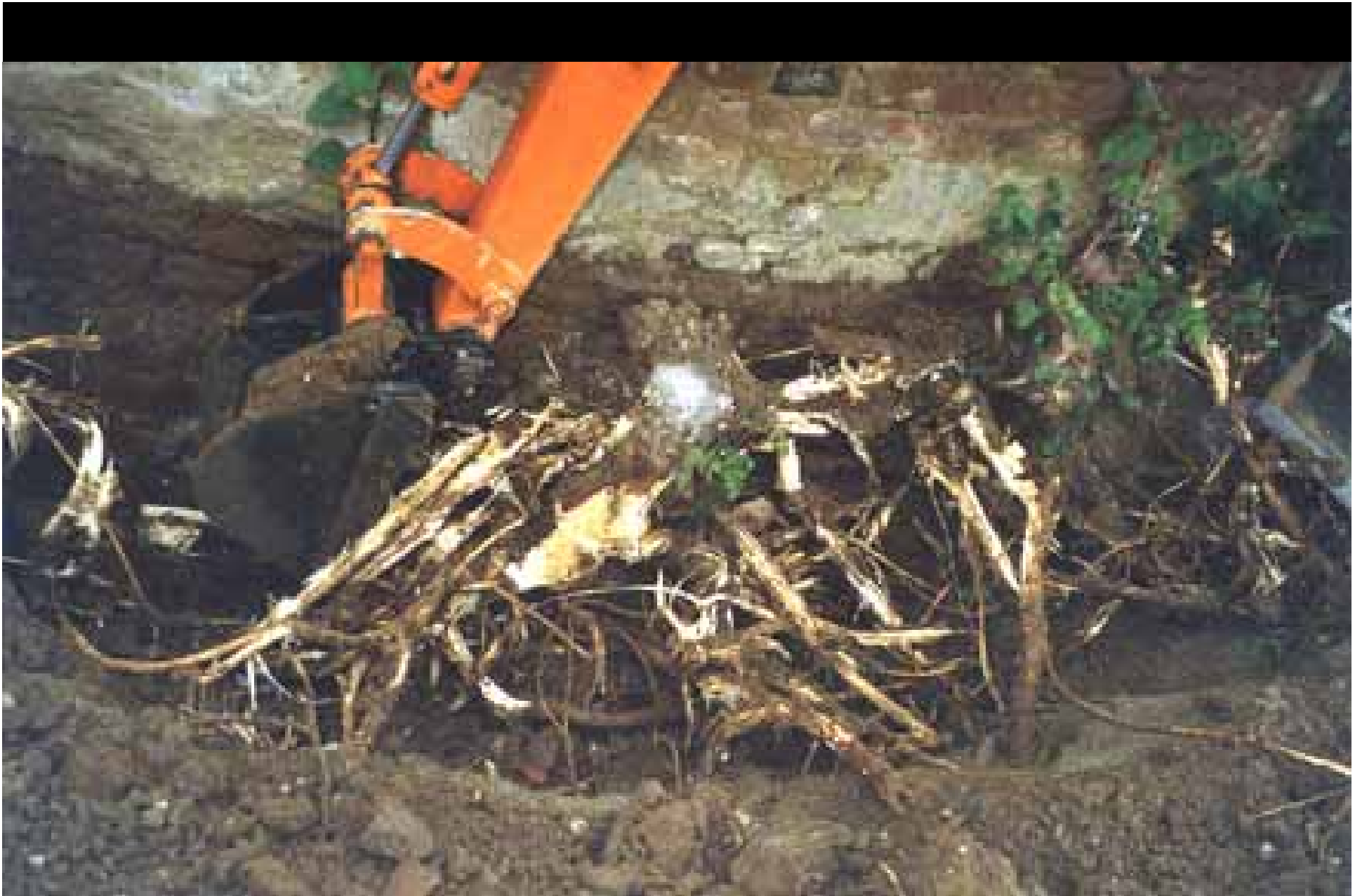
Particolare dello scavo attorno alle fondazioni, con la rimozione della vegetazione
