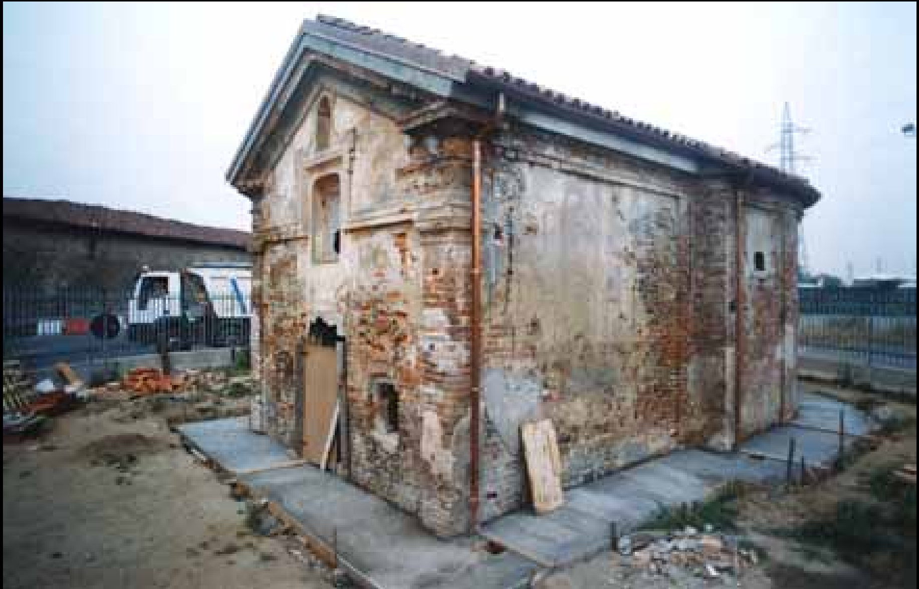
Vista del vespaio aerato attorno alle fondazioni, dal lato dell'ingresso, con i pozzetti in corrispondenza dei pluviali, dopo il getto della soletta di copertura
