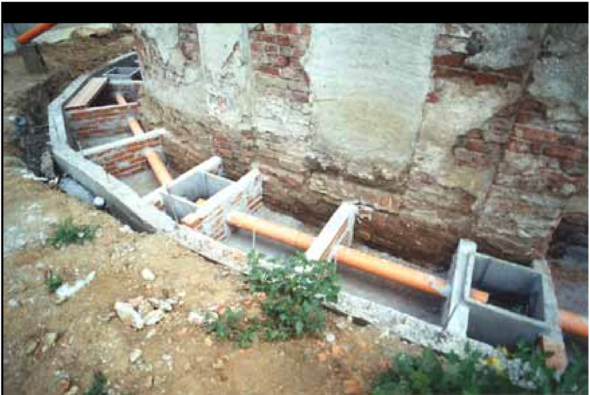
Vista generale del vespaio aerato attorno alle fondazioni con i pozzetti in corrispondenza dei pluviali e le tubazioni di scarico
