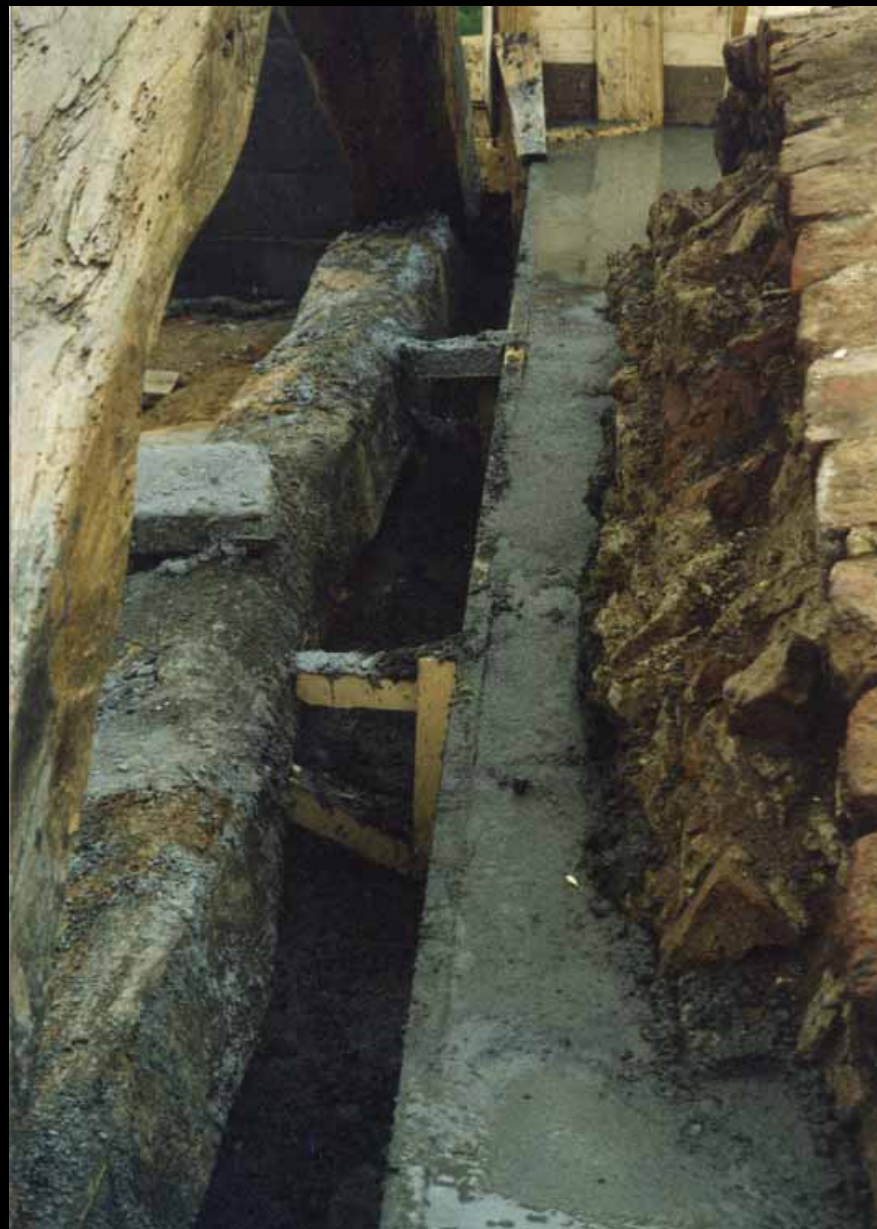
Particolare del getto del cordolo trasversale in c.a. a livello del cornicione
