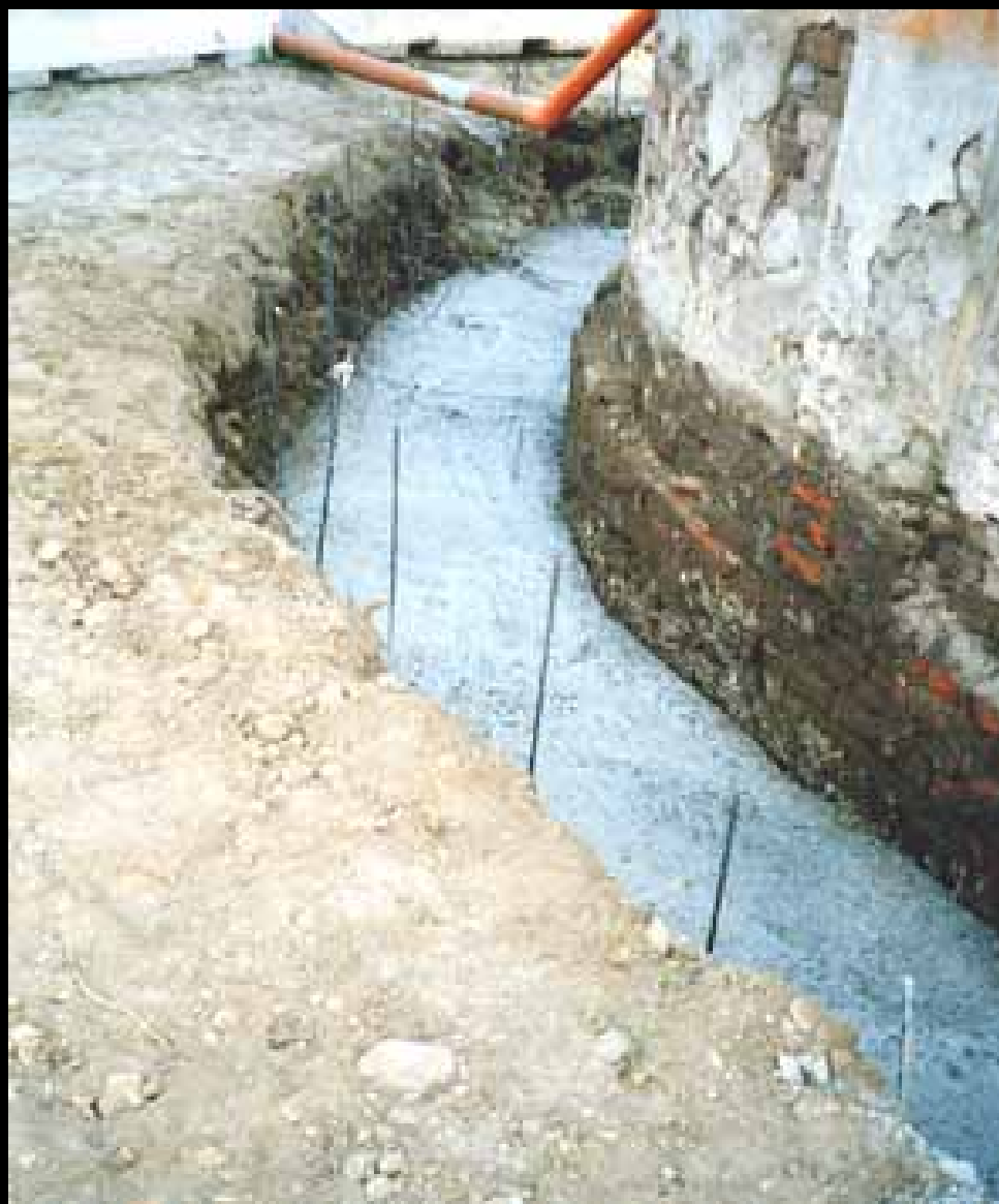
Vista dello scavo attorno alle fondazioni dopo la rimozione della vegetazione, con il getto in c.a. del sottofondo per la formazione del vespaio aerato
