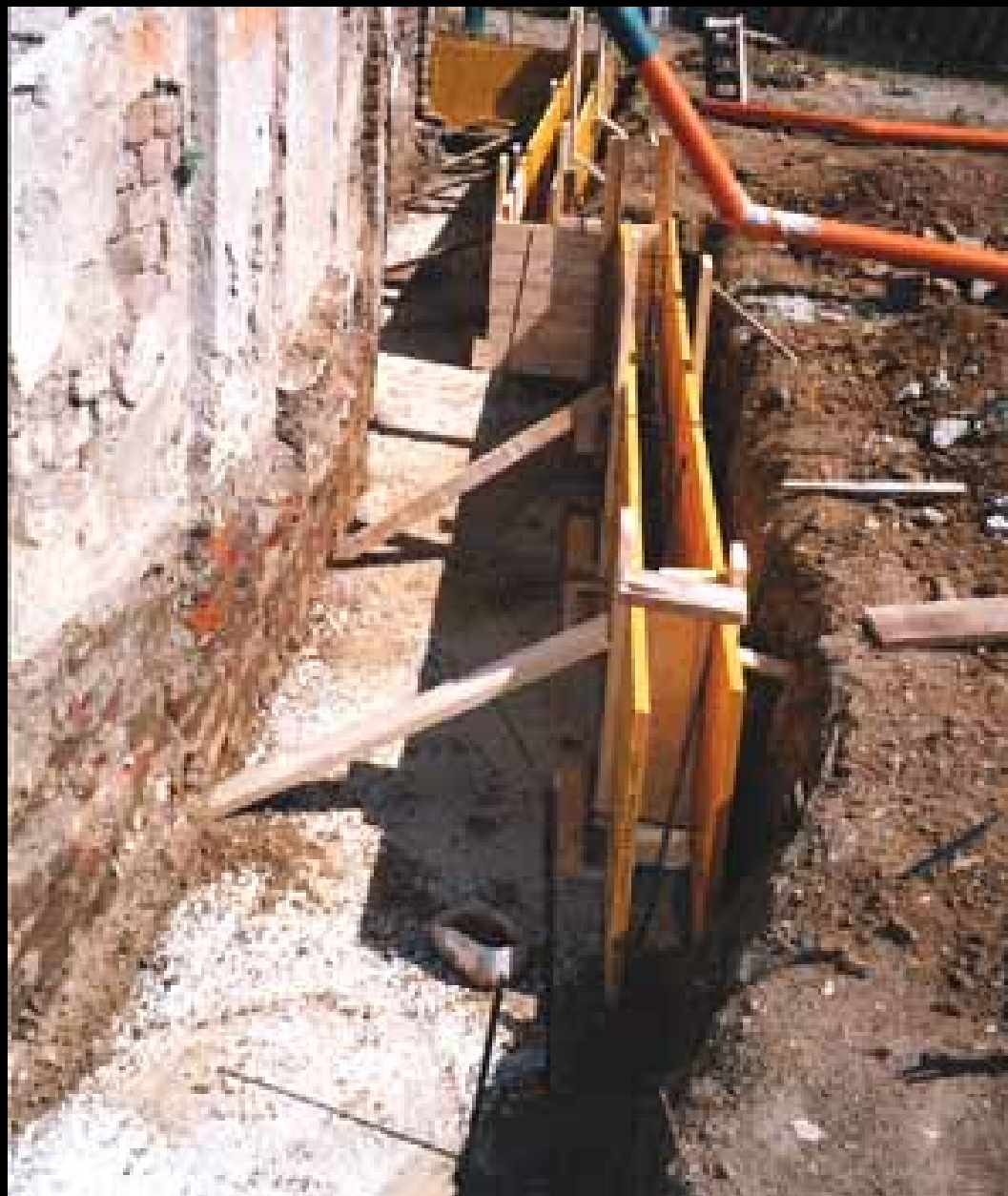
Particolare dell'armatura per il getto in c.a. del muro d'ambito del vespaio aerato
