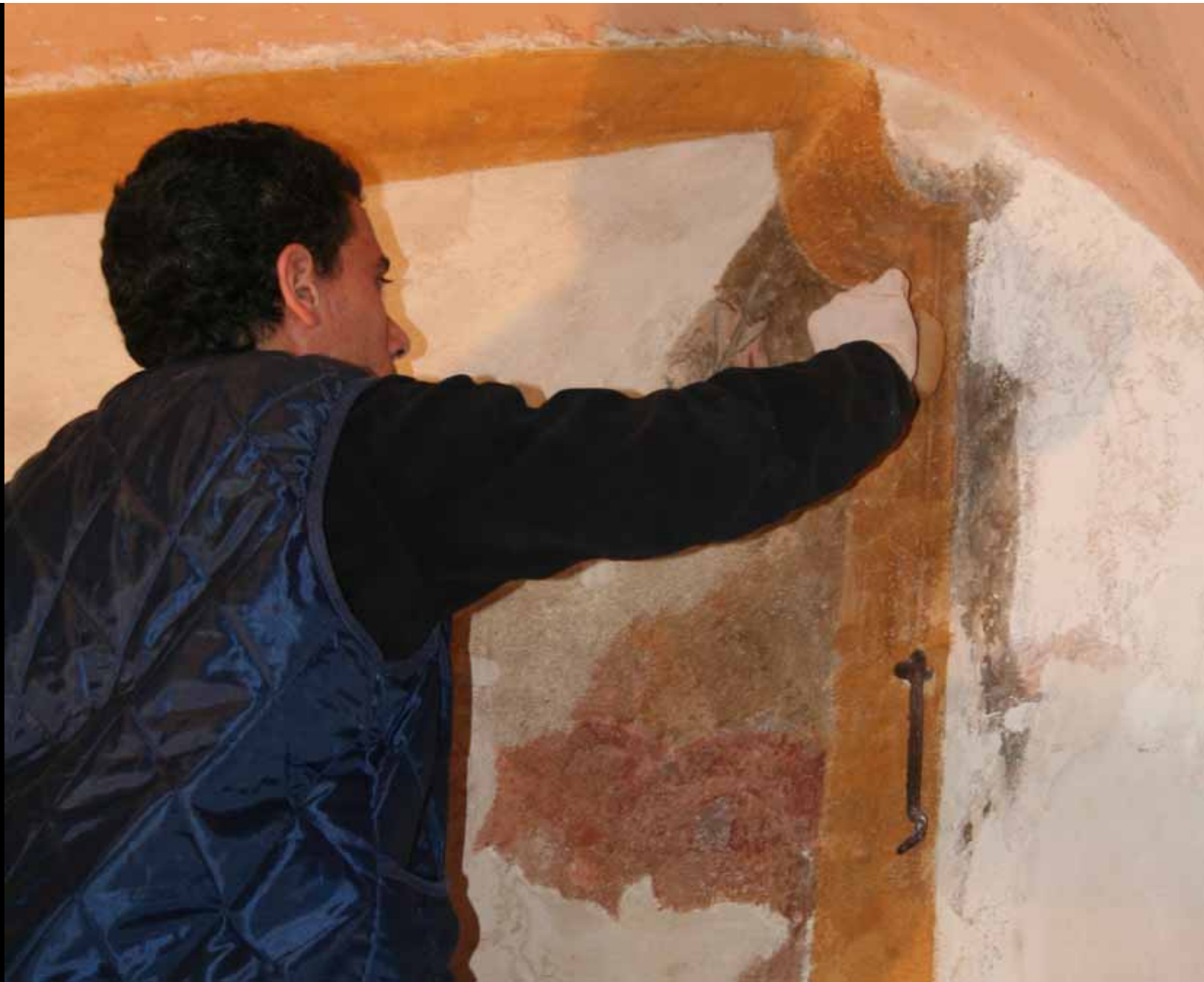
Restauro e ripristino della cornice in trompe-l'oeil dell'affresco
