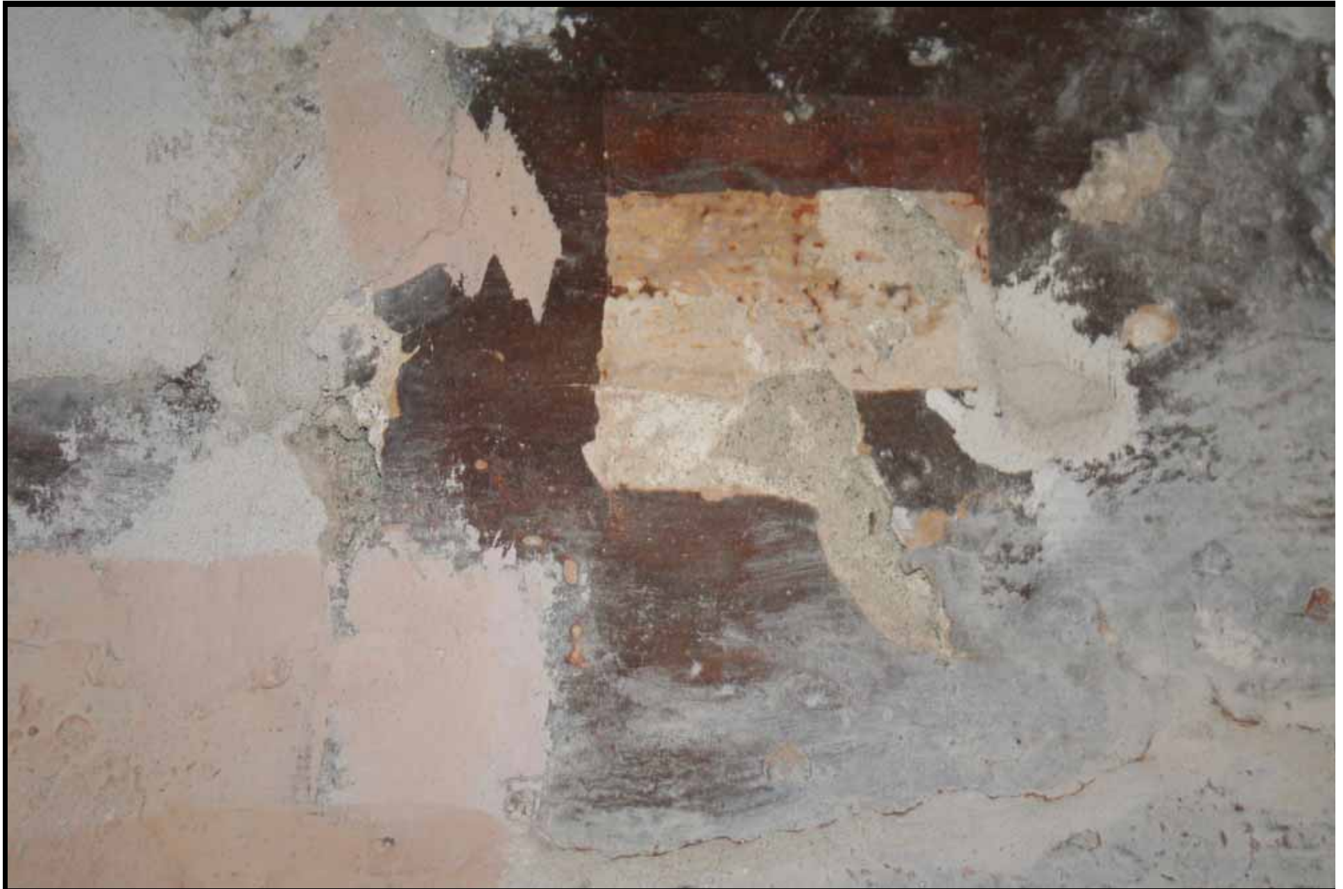
Particolare dei saggi stratigrafici sulle pareti della Cappella
