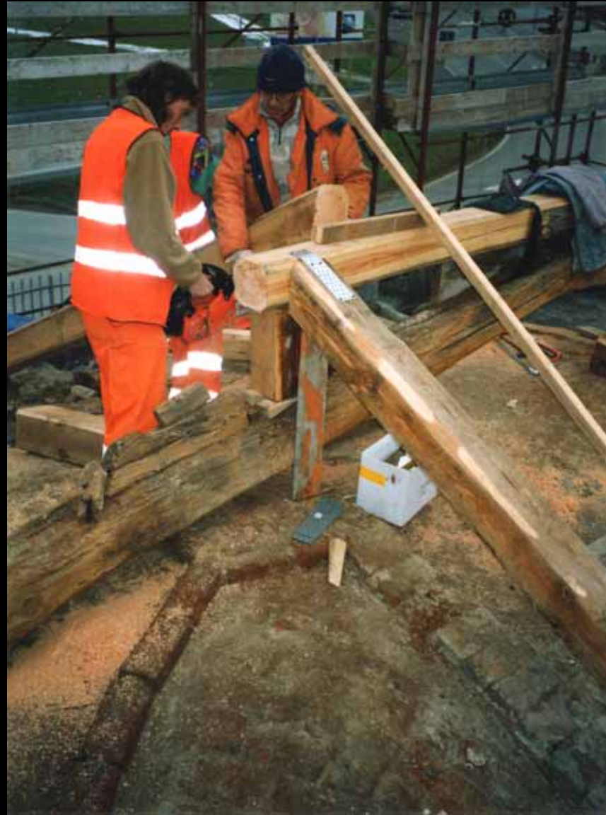
Particolare del colmo in legno del tetto, collegato col puntone longitudinale originario, connesso con i puntoni trasversali, poggianti sul cordolo in c.a. e sul colmo
