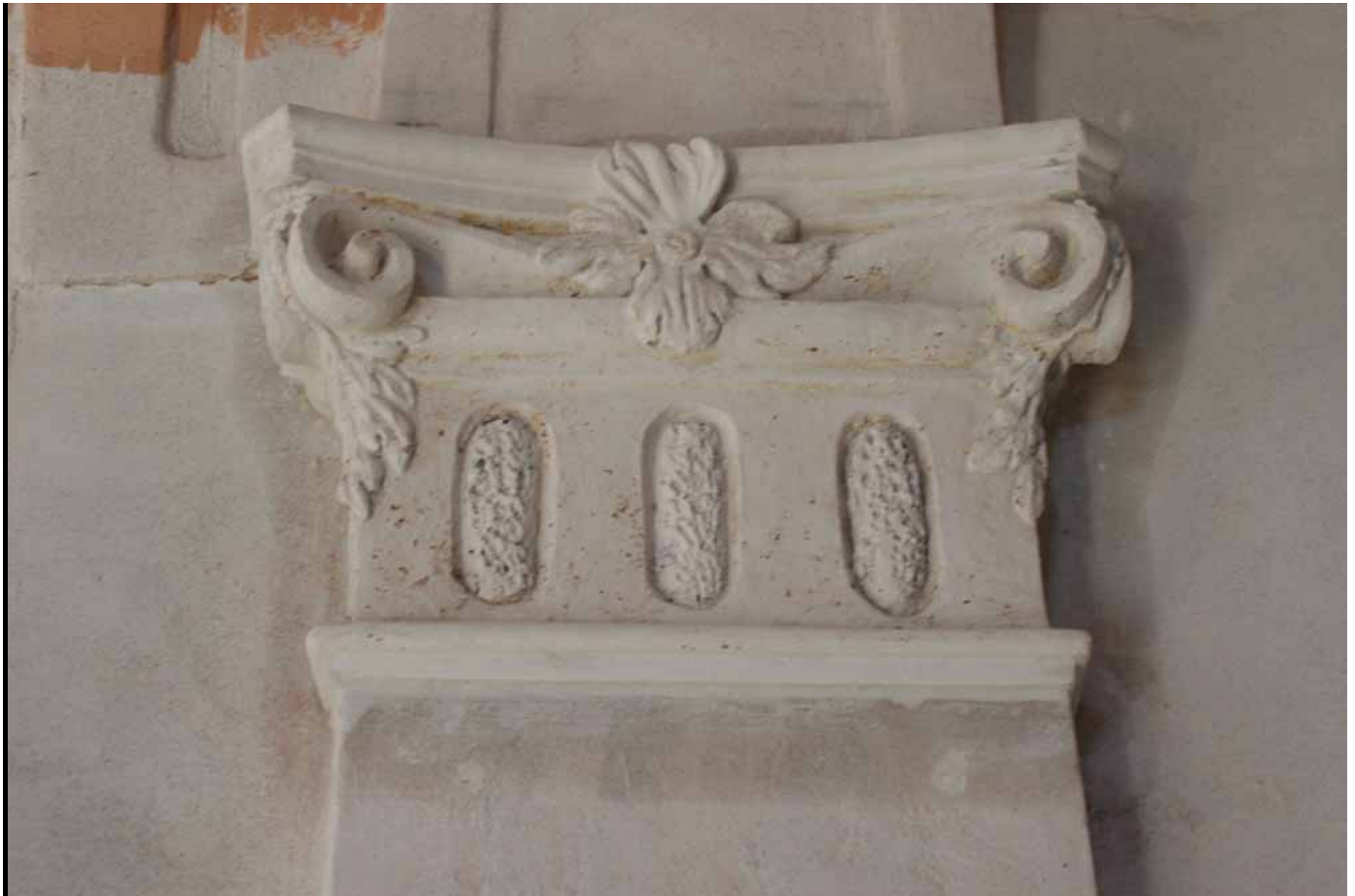
Ripristino del capitello in stucco mancante, in base al calco
