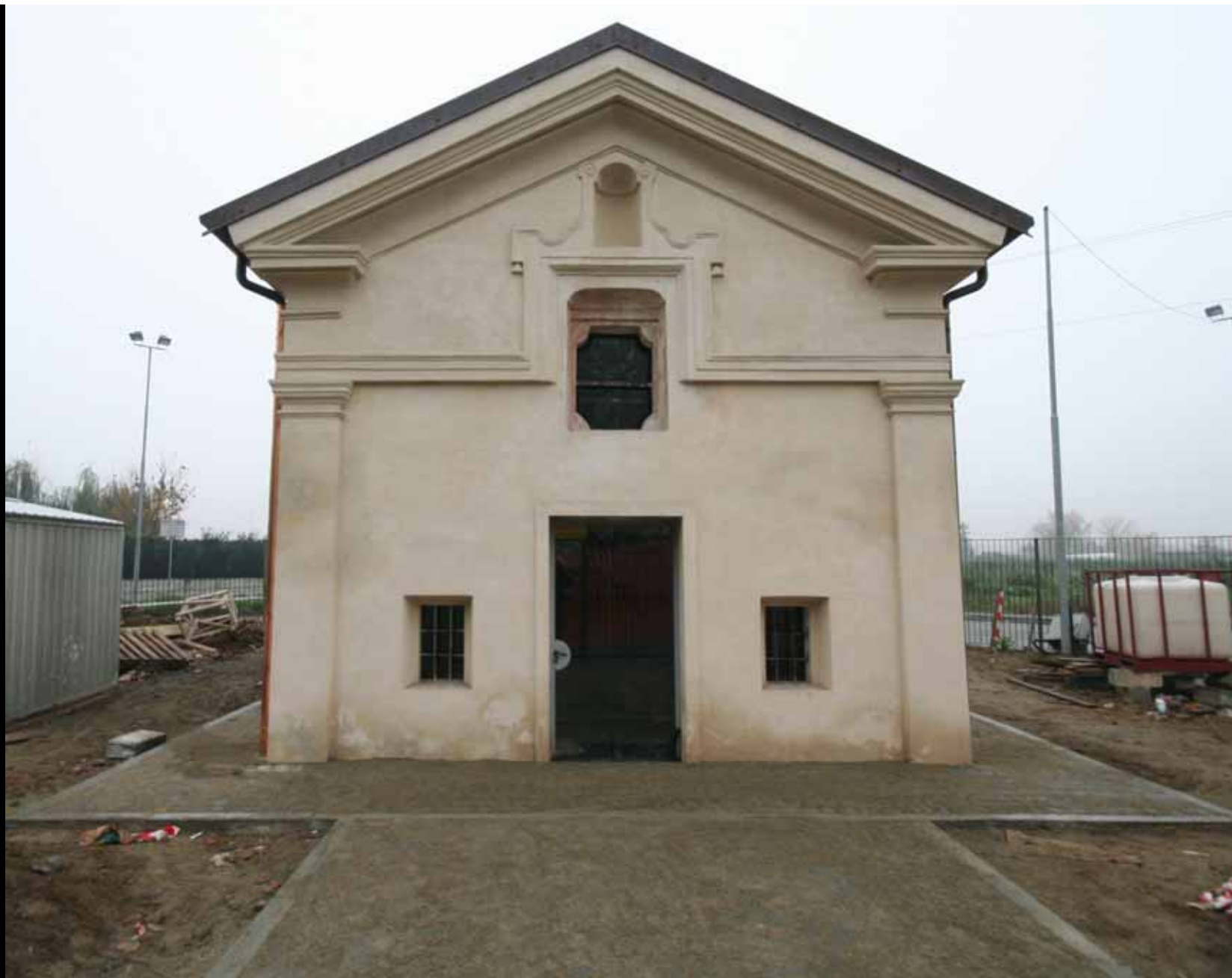
Particolare della facciata della Cappella dopo l'intonacatura
