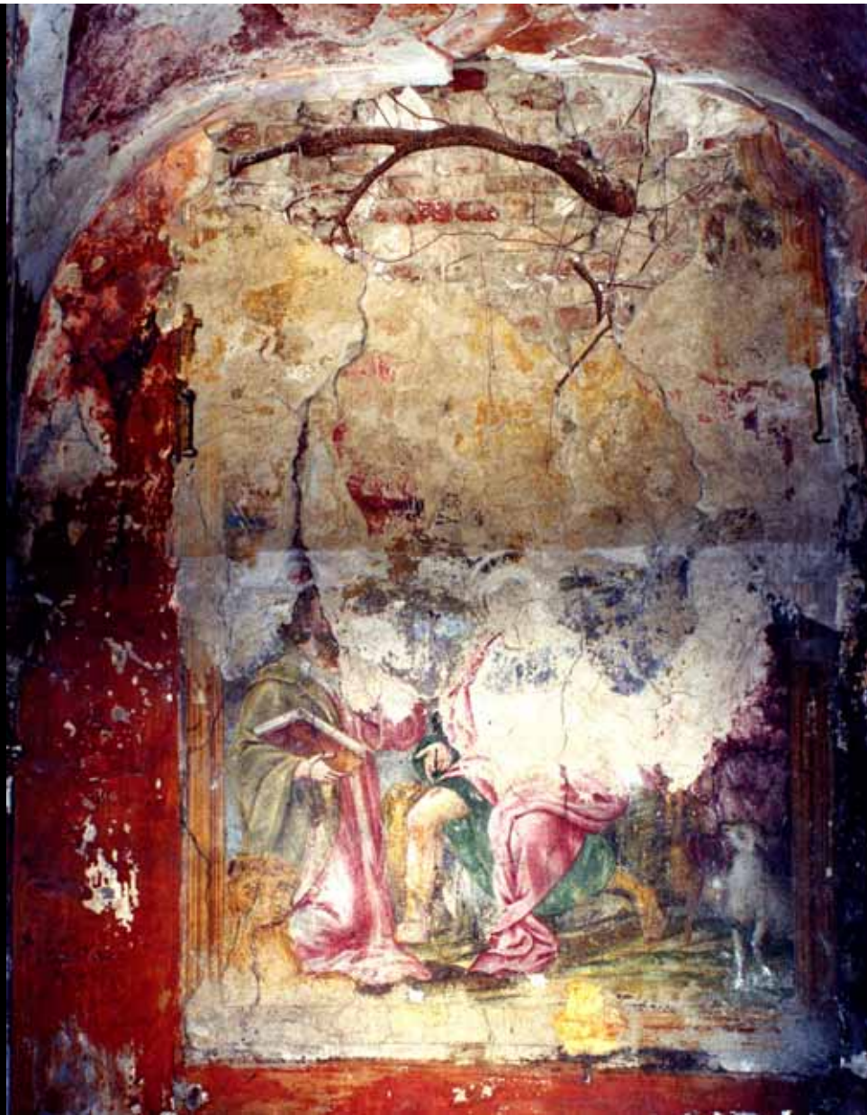
Stato di conservazione dell'affresco prima del restauro con la vegetazione che invadeva la parte alta
