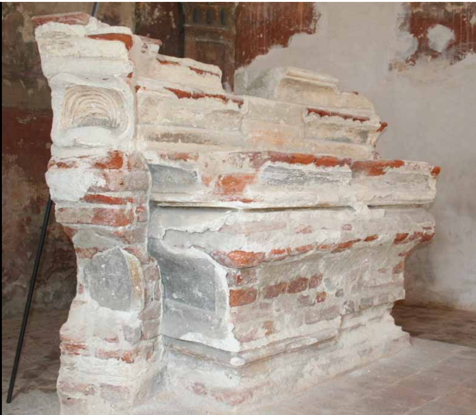
Stato di conservazione dell'altare in stucco dell'abside, prima del restauro
