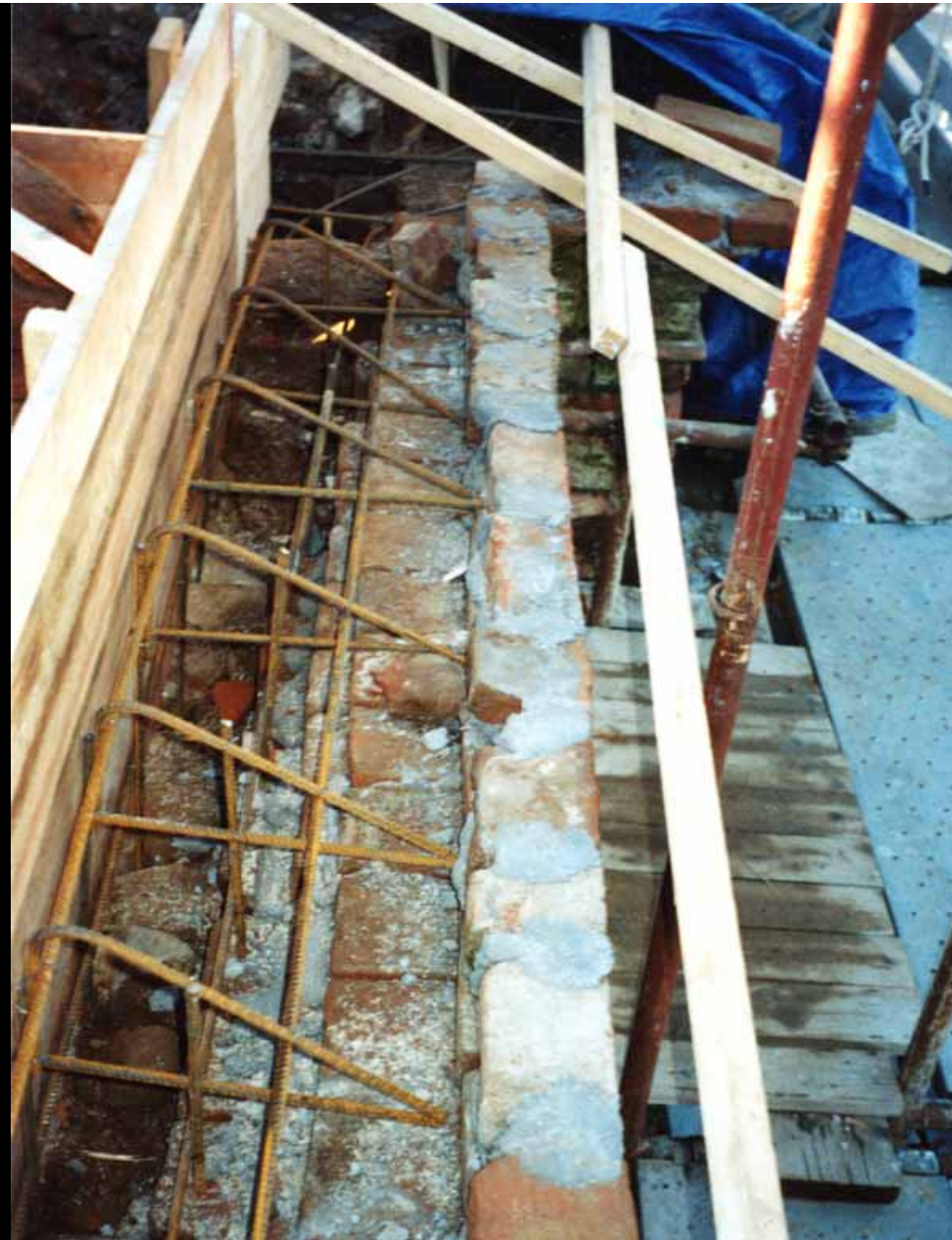
Particolare dell'armatura del cordolo in c.a., a livello del cornicione
