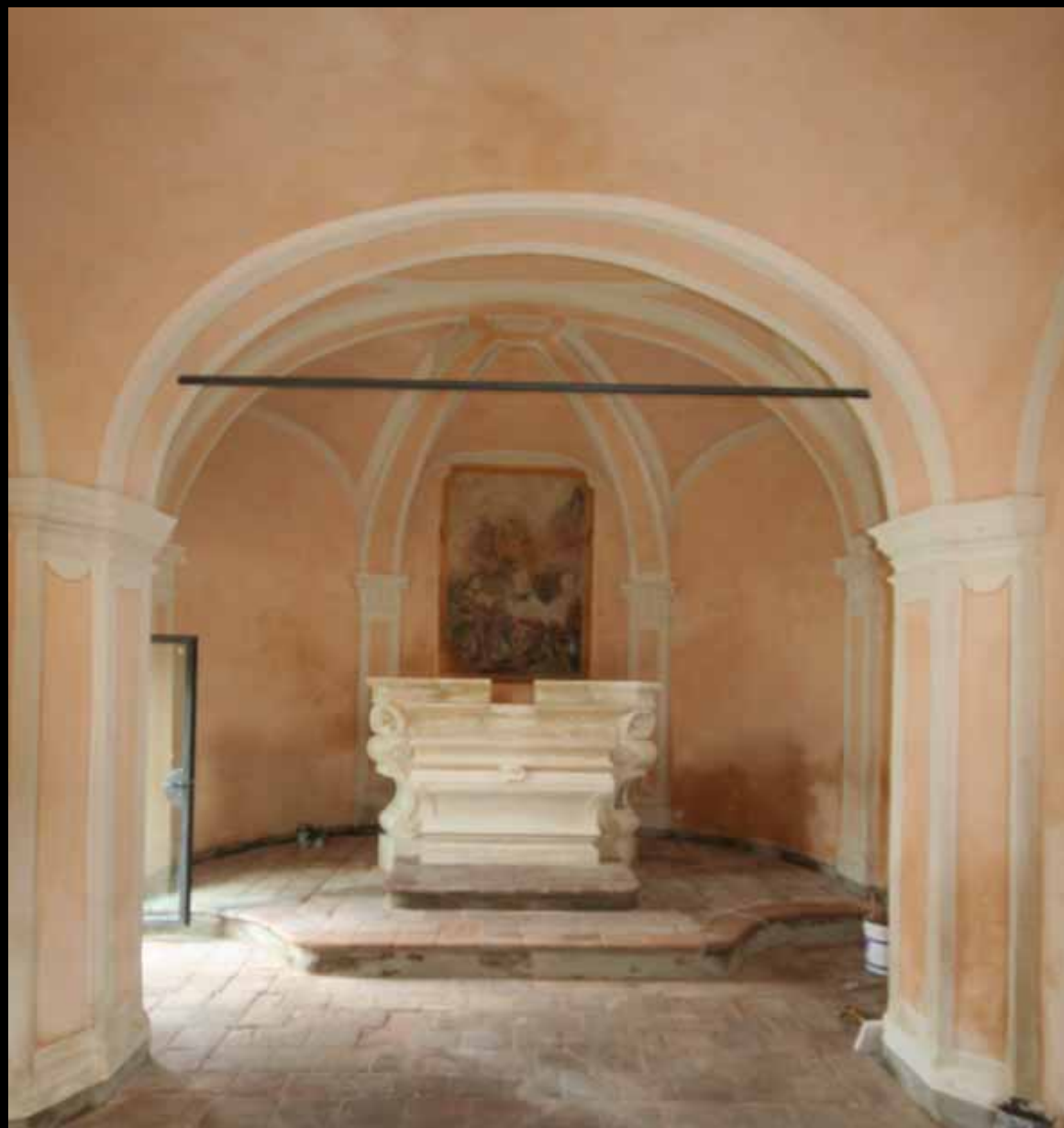
Vista generale dell'interno dell'abside, dopo il restauro delle coloriture
