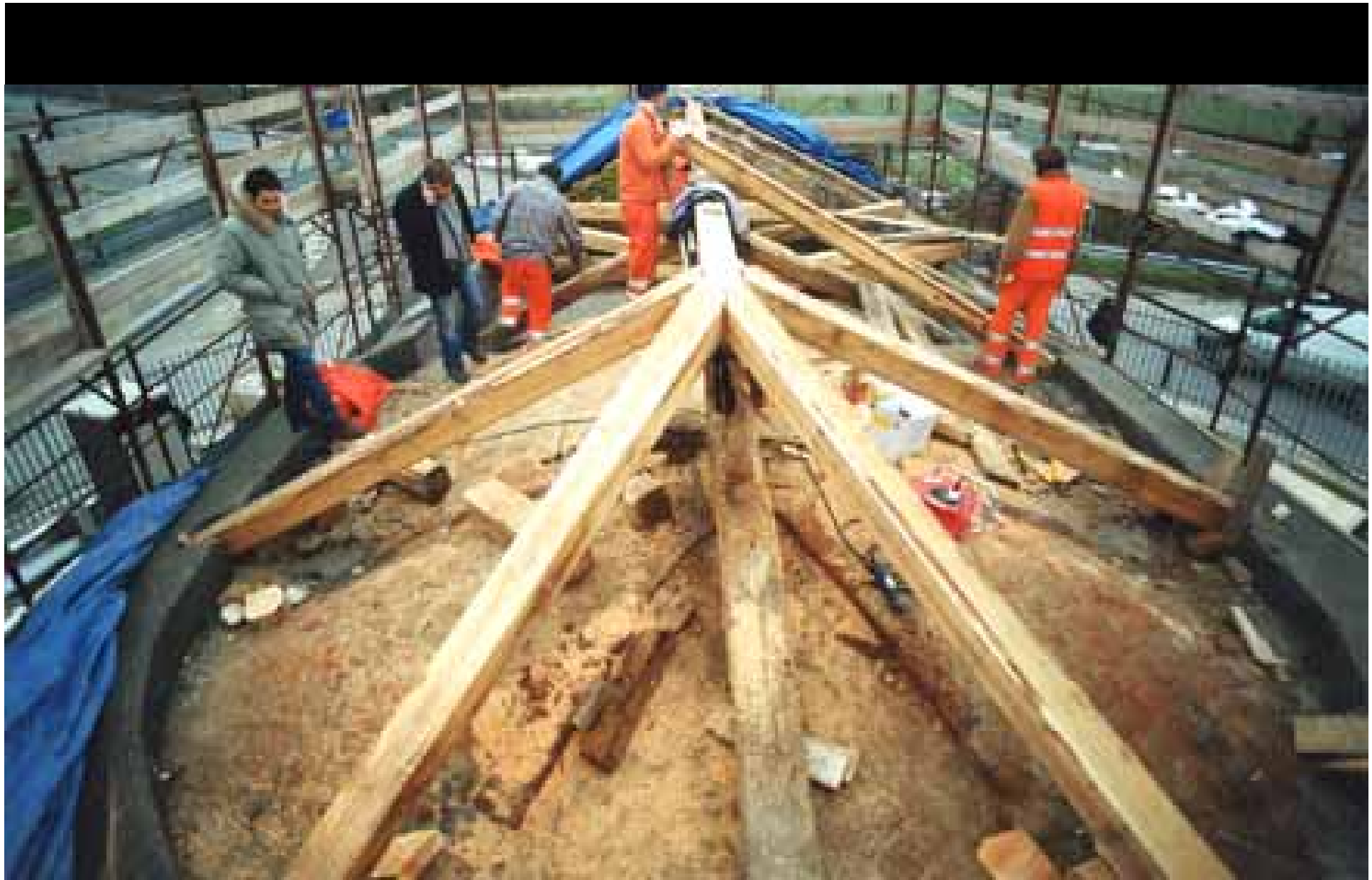
Vista dall'abside del ripristino del colmo e dei puntoni in legno del tetto, poggianti sul cordolo in c.a.
