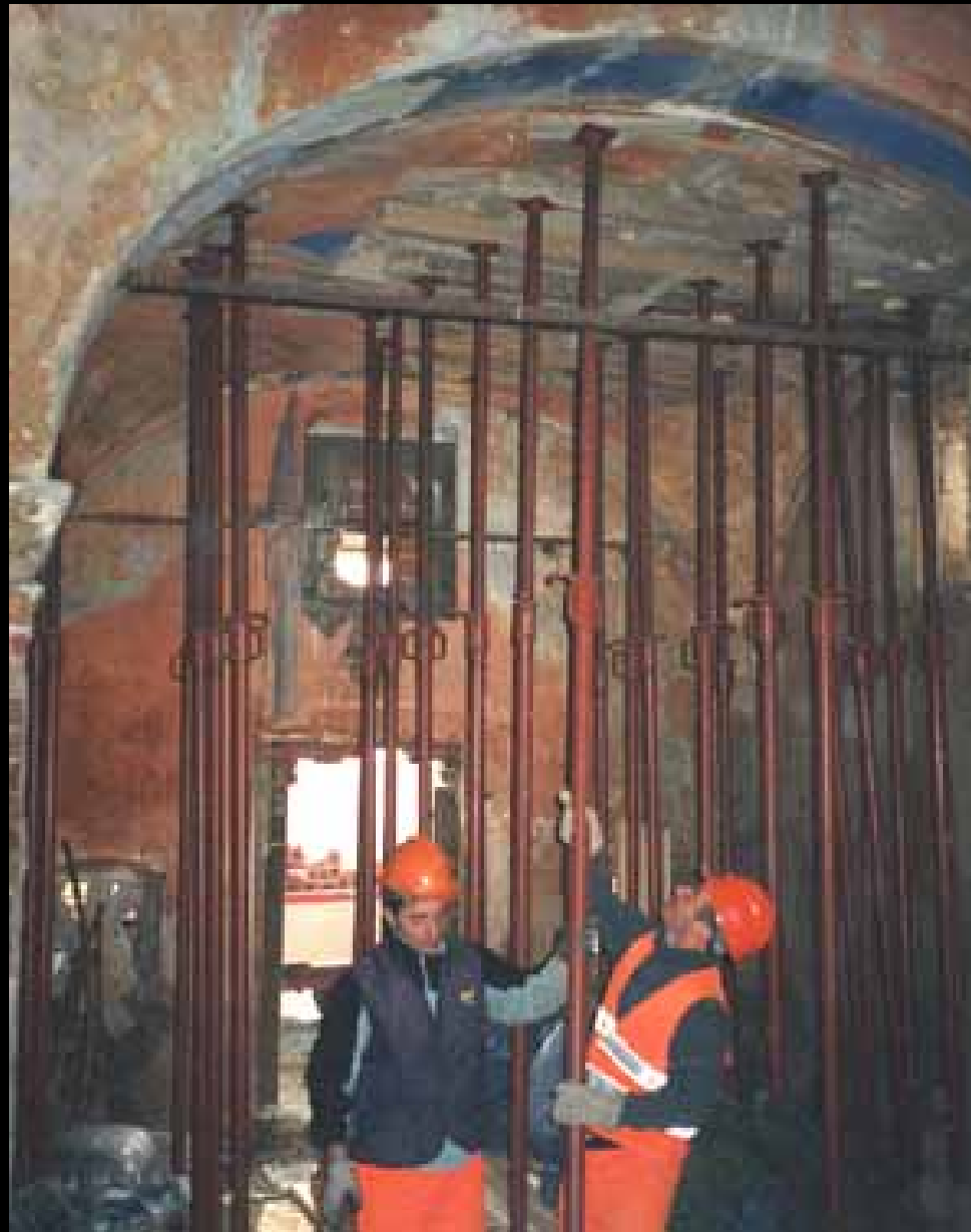
Rimozione del puntellamento in corrispondenza della volta restaurata
