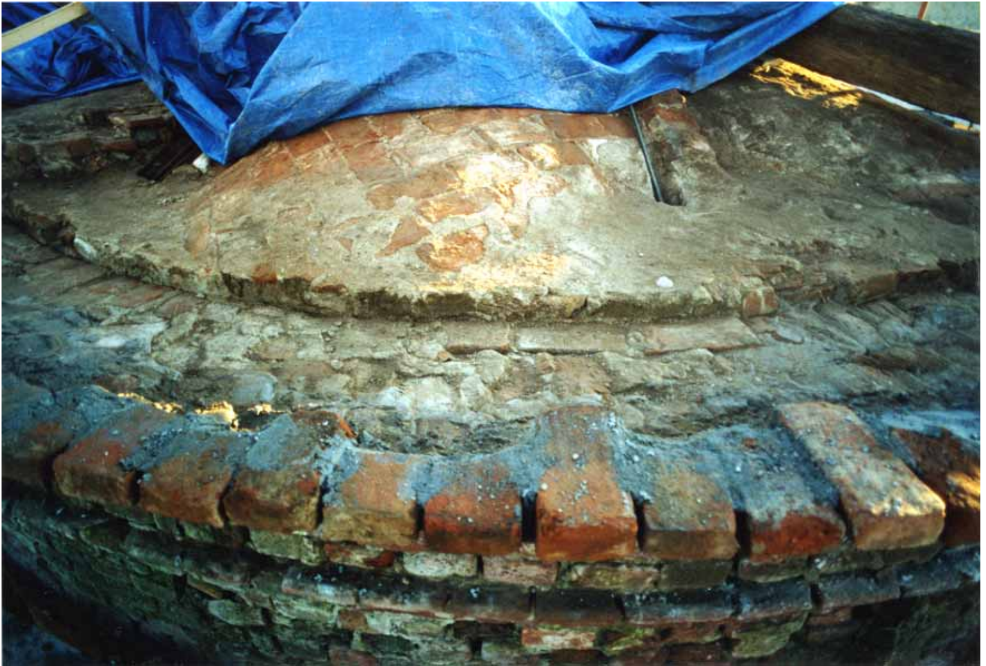
Ripristino del cornicione dell'abside, dopo la rimozione della vegetazione
