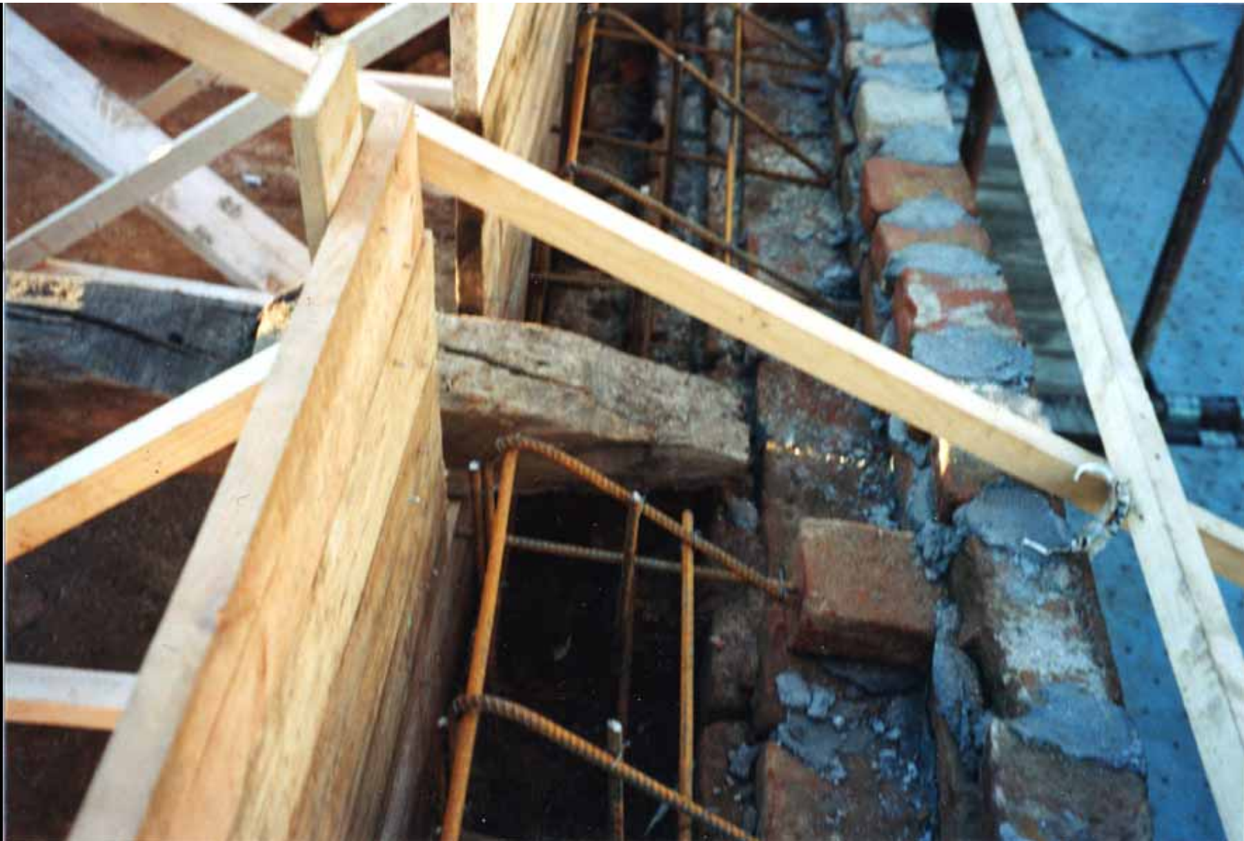
Particolare dell'armatura del cordolo in c.a., in corrispondenza delle capriate
