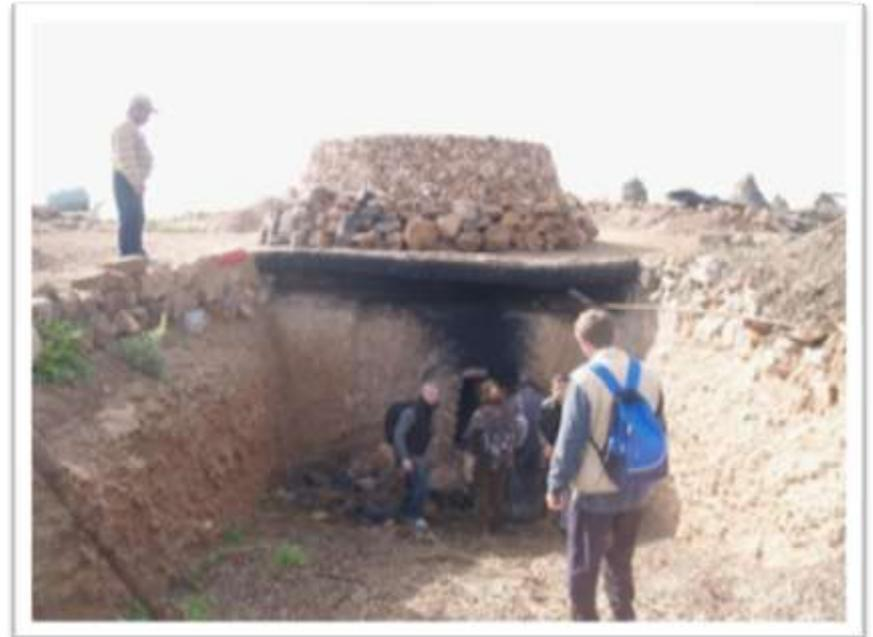
Visita delle fornaci di calce di Marrakech : l'interno di una fornace pronta per la cottura
