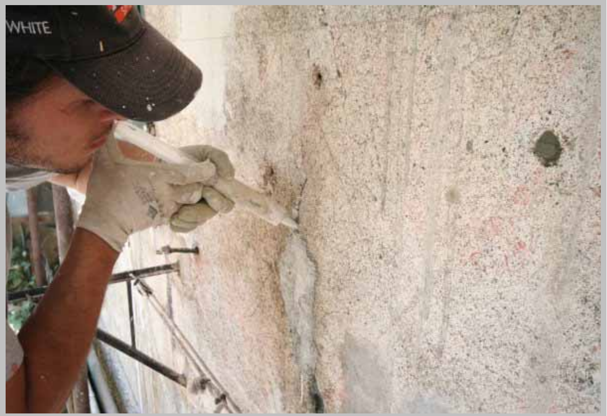
3 - Consolidamento degli intonaci de-coesi dal supporto murario
