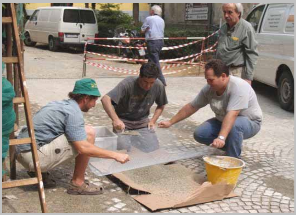
11 - Setacciatura della sabbia di fiume locale per il ripristino del basamento
