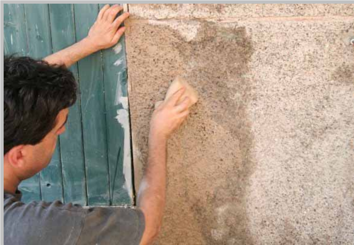
13 - Lavaggio superficiale della malta per fare risaltare i granelli della sabbia di fiume
