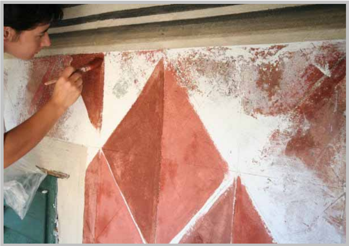
7 - Tinteggiatura dei fondi con pittura di calce colorata con terre naturali
