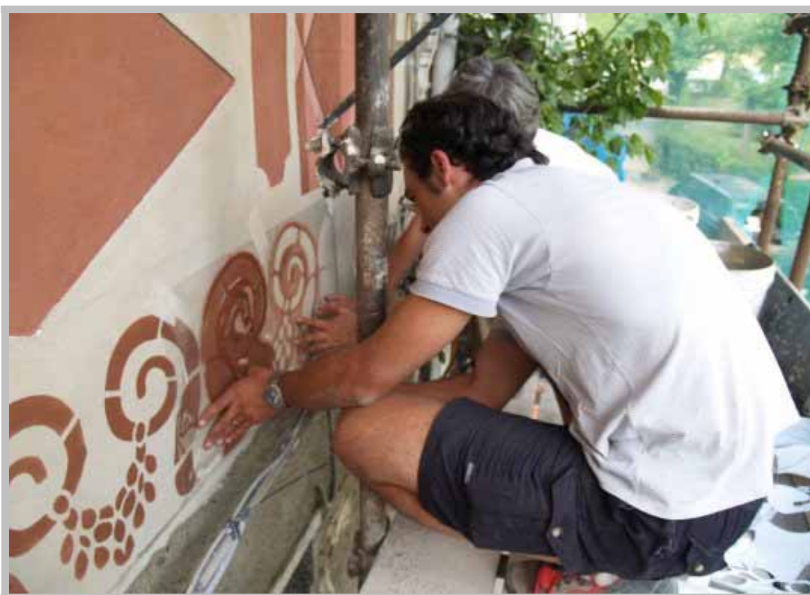
10 - Rifacimento della decorazione con la tecnica dello stencil
