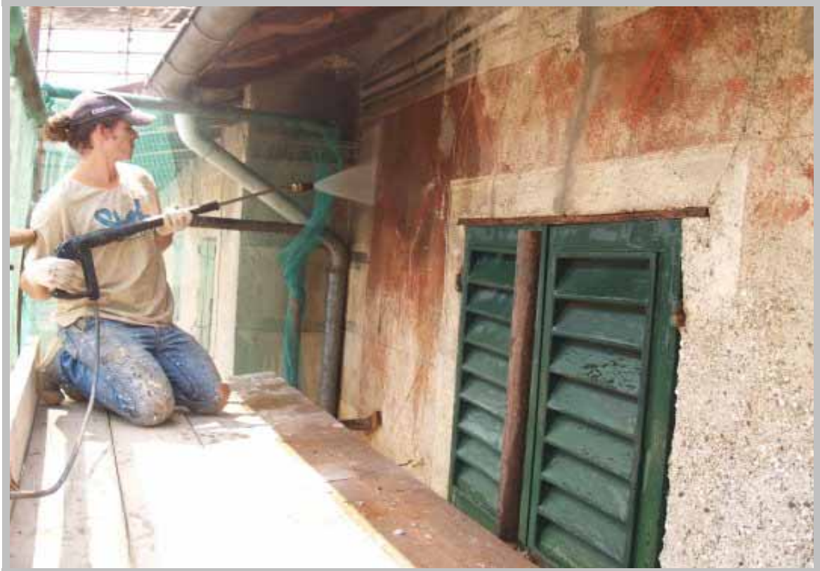
2 - Lavaggio della facciata a bassa pressione
