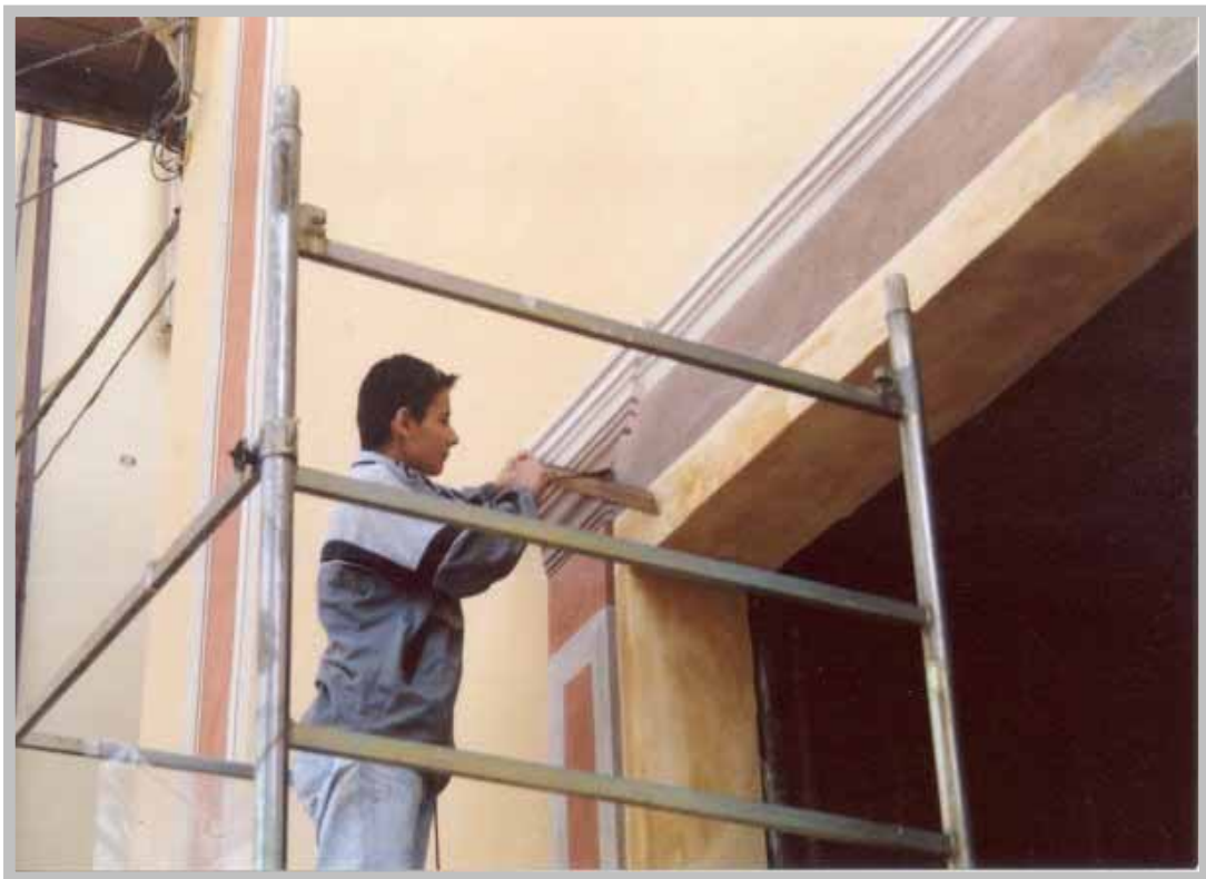
8 - Riproduzione della finta cornice in trompe-l'oeil
