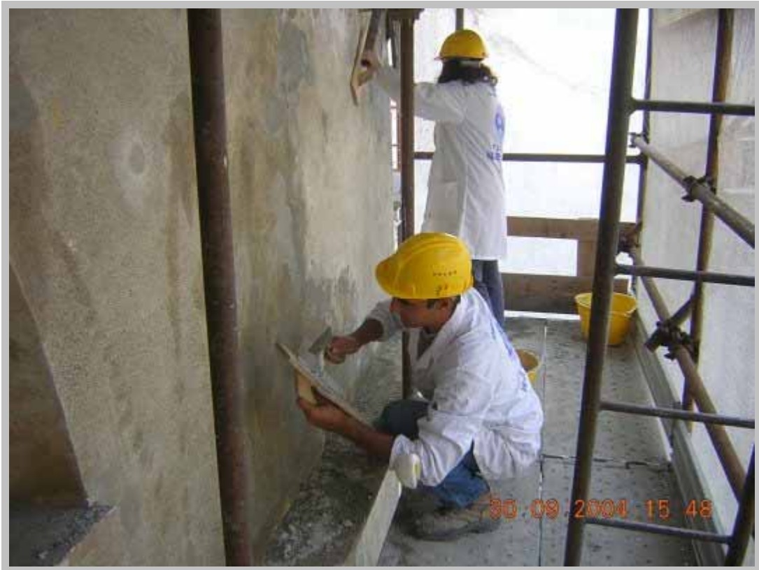
3 - Ripristino dell'intonaco (sabbia fine e grassello di calce)
