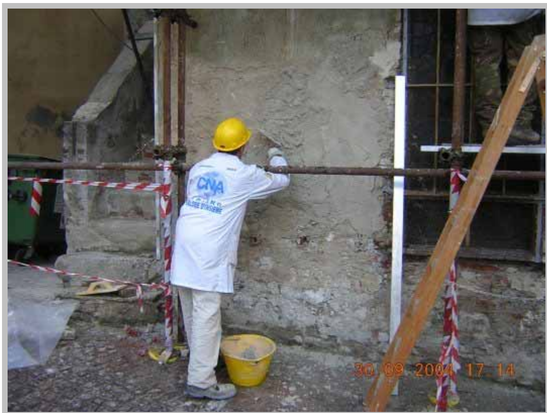
2 - Rifacimento dell'intonaco con malta di calce e cocchiopesto
