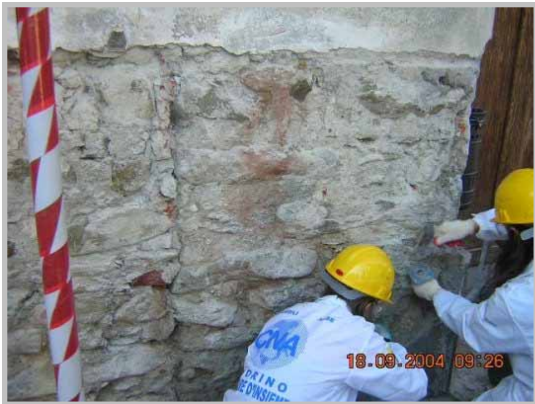
1 - Rimozione dell'intonaco del basamento ammalorato dall'umidità
