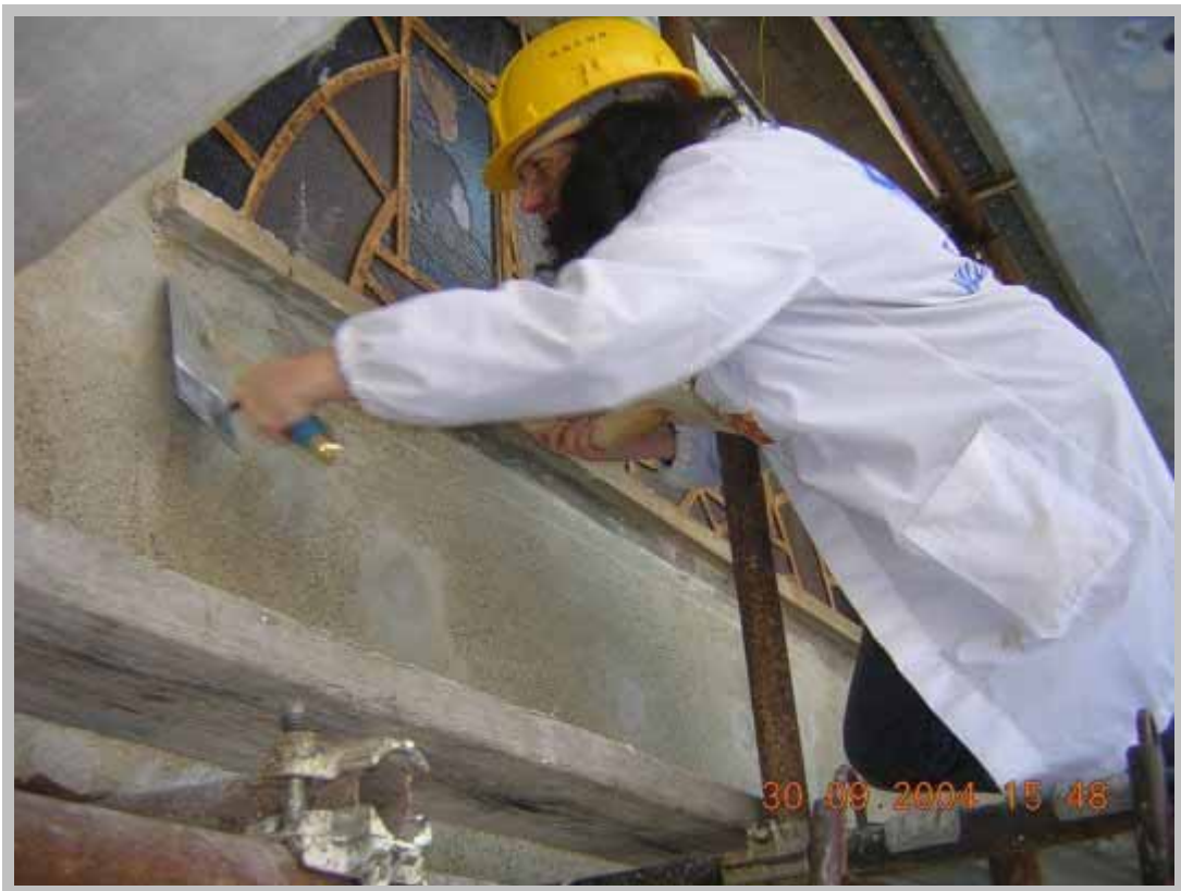
4 - Ripristino dell'intonaco (sabbia fine e grassello di calce)
