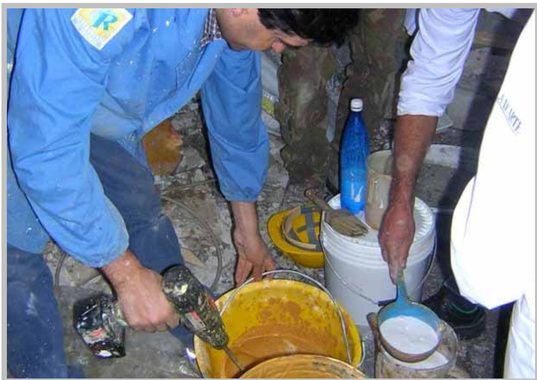
6 - Preparazione delle pitture a calce colorate con terre naturali
