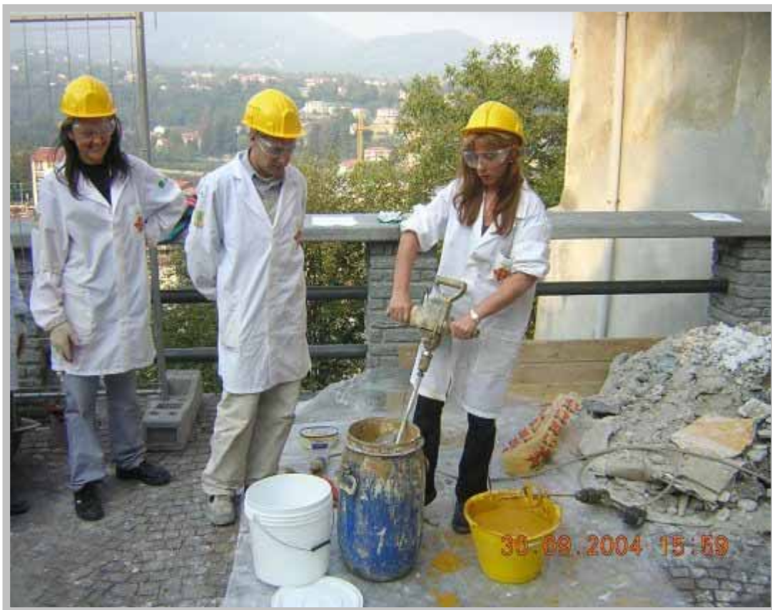
5 - Preparazione delle pitture a calce colorate con terre naturali
