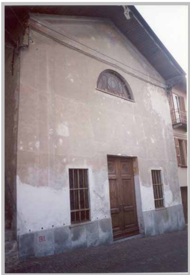
Prima del restauro
