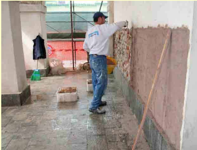
Applicazione dell'intonaco di cocchiopesto alle pareti del portico
