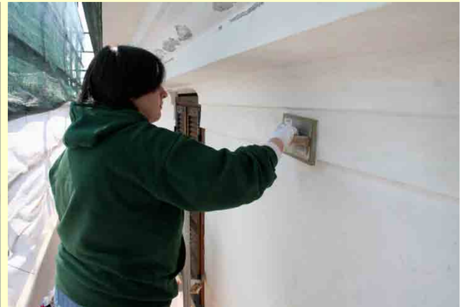
Rasatura con stucco dell'intonaco corroso del cornicione
