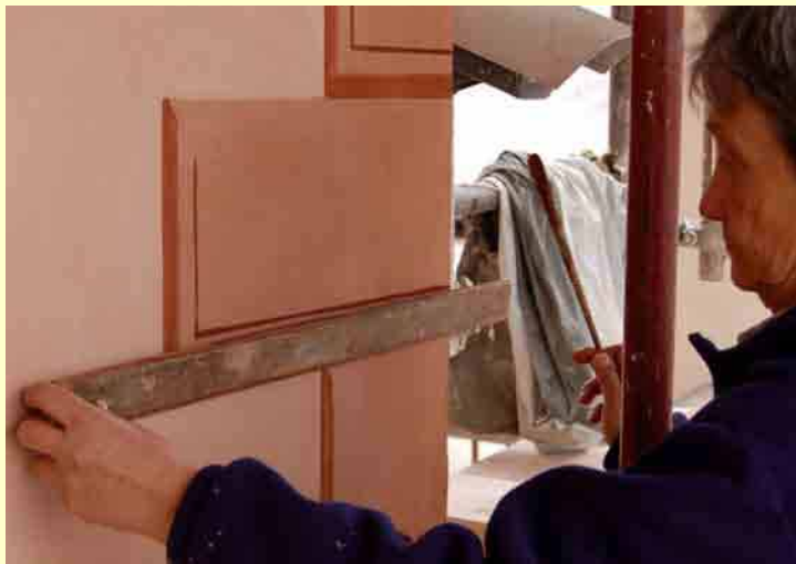
Realizzazione dei bugnati angolari ai lati delle facciate
