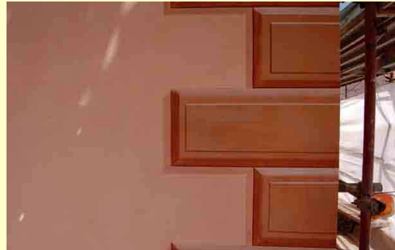
Realizzazione dei bugnati angolari ai lati delle facciate
