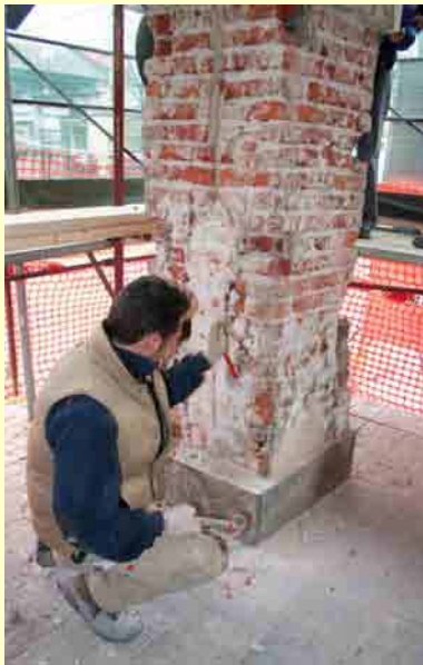
La demolizione degli intonaci cementizi dei pilastri del portico con la rimozione degli angolari metallici
