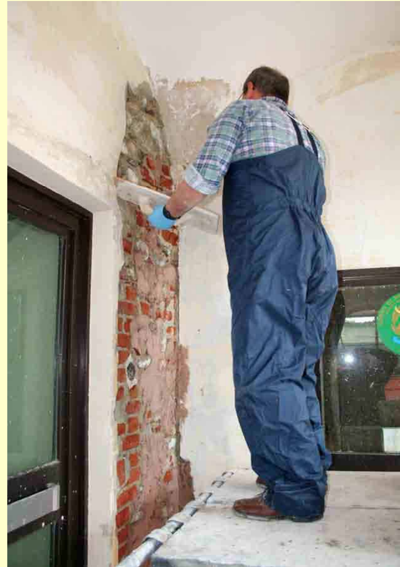
Applicazione dell'intonaco di cocchiopesto alle pareti del portico
