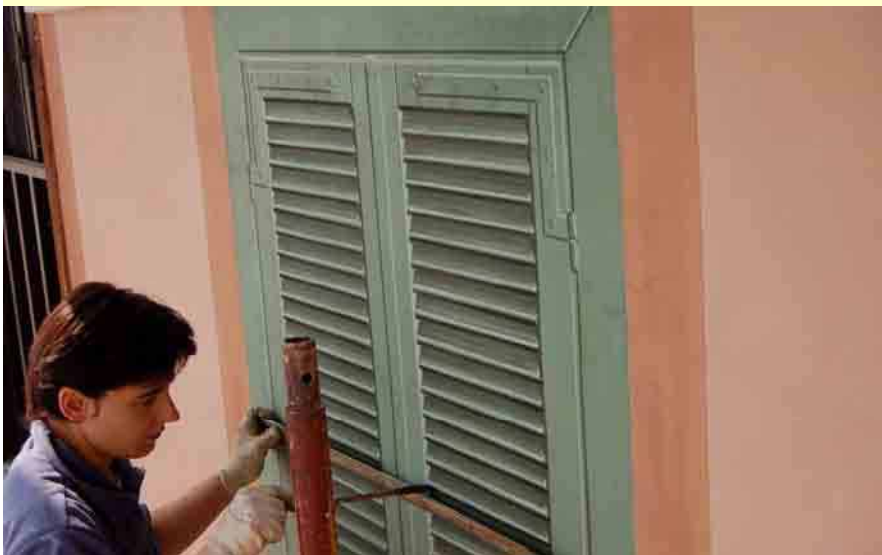
Realizzazione delle persiane in trompe-l'oeil
