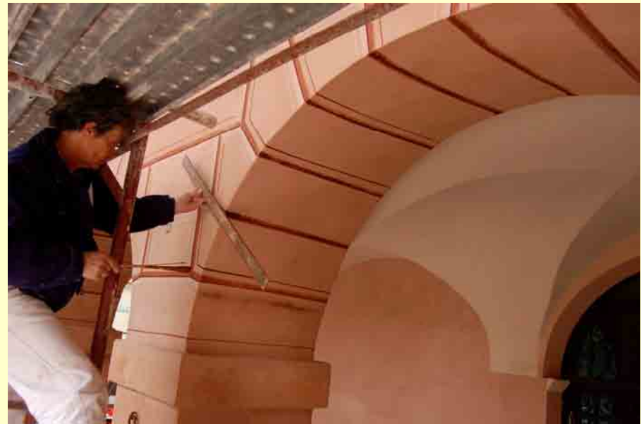
Particolari della realizzazione dei bugnati originali del portico, in base alle tracce e alle foto d'epoca
