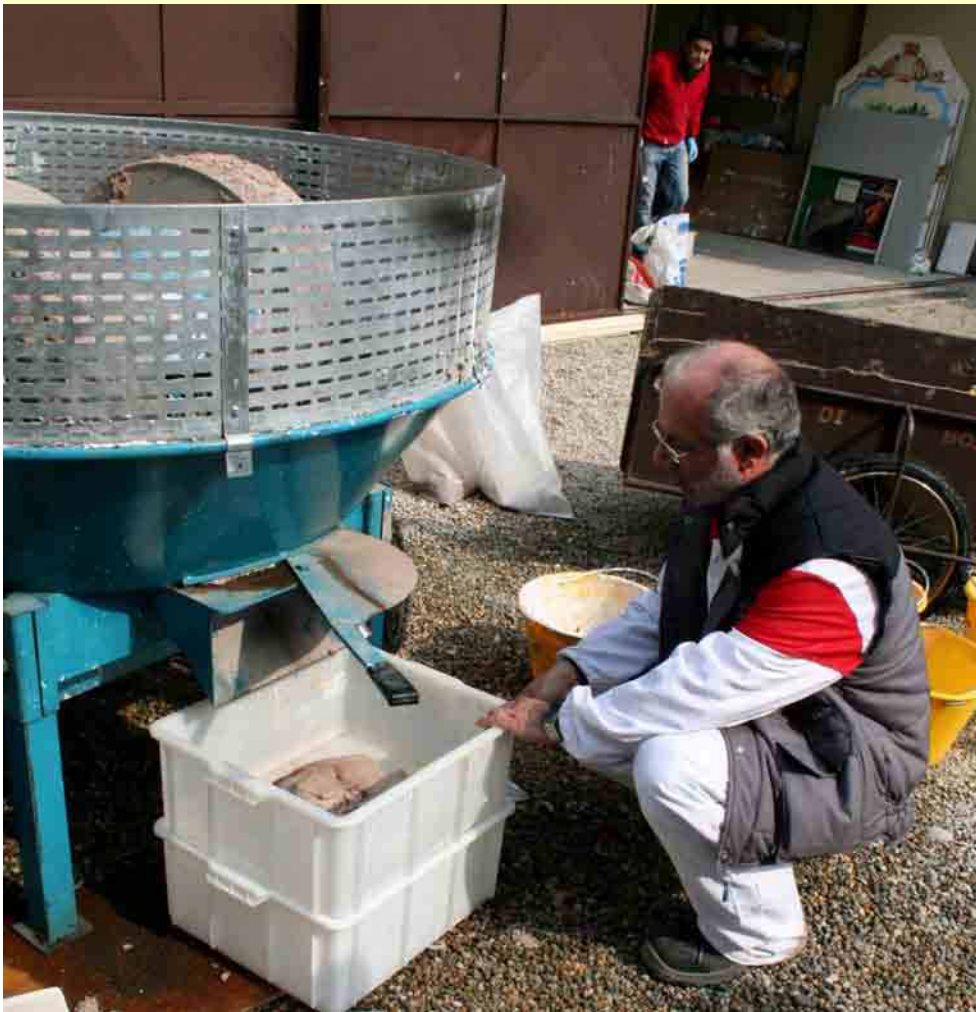
Preparazione dell'intonaco di "cocciopesto" con la molazza da applicare ai pilastri e alle pareti del portico
