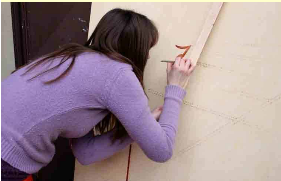
Formazione dello "spolvero" della meridiana e riproduzione della stessa su pannello intonacato all'interno del "Laboratorio"
