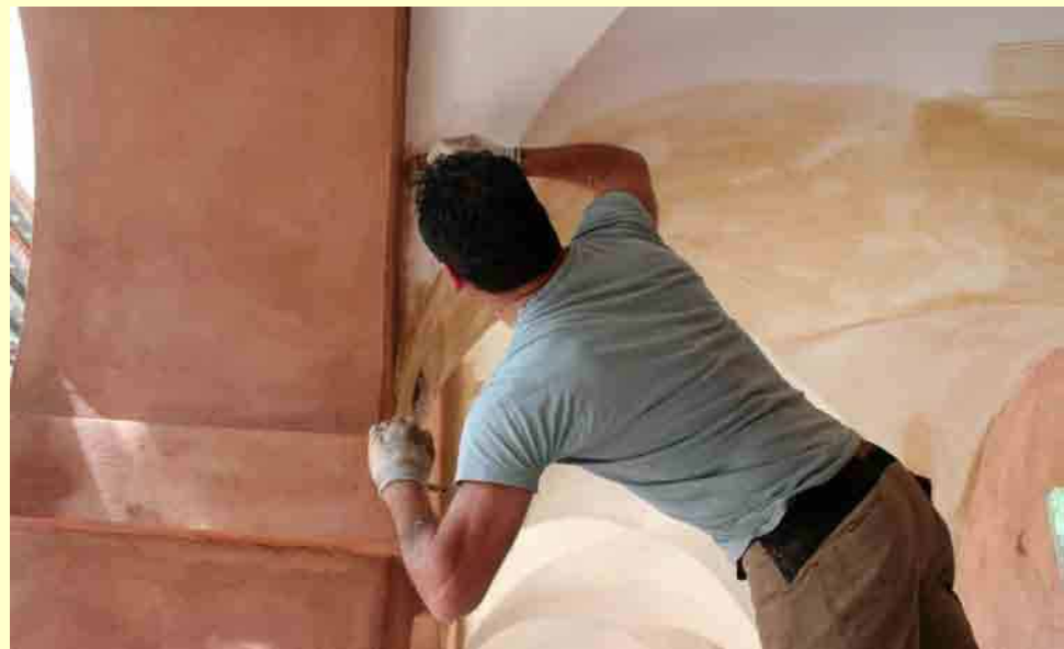
Tinteggiatura dei pilastri, delle pareti e della volta del portico
