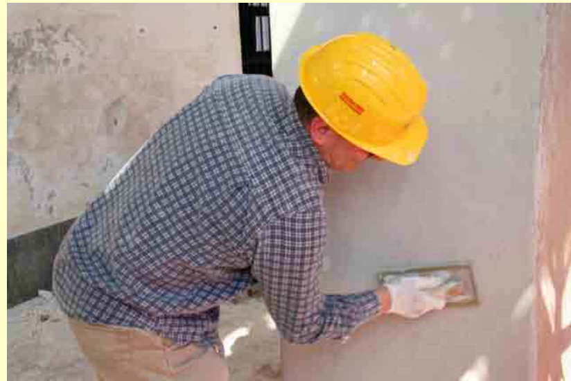
Applicazione dell'intonaco di finitura ai pilastri del portico
