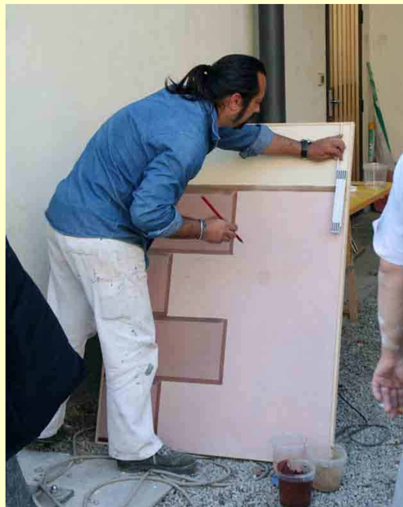
Ricostruzione, su pannelli intonacati, del bugnato angolare della facciata del Municipio in base alle foto d'epoca e ai campioni di intonaco originario
