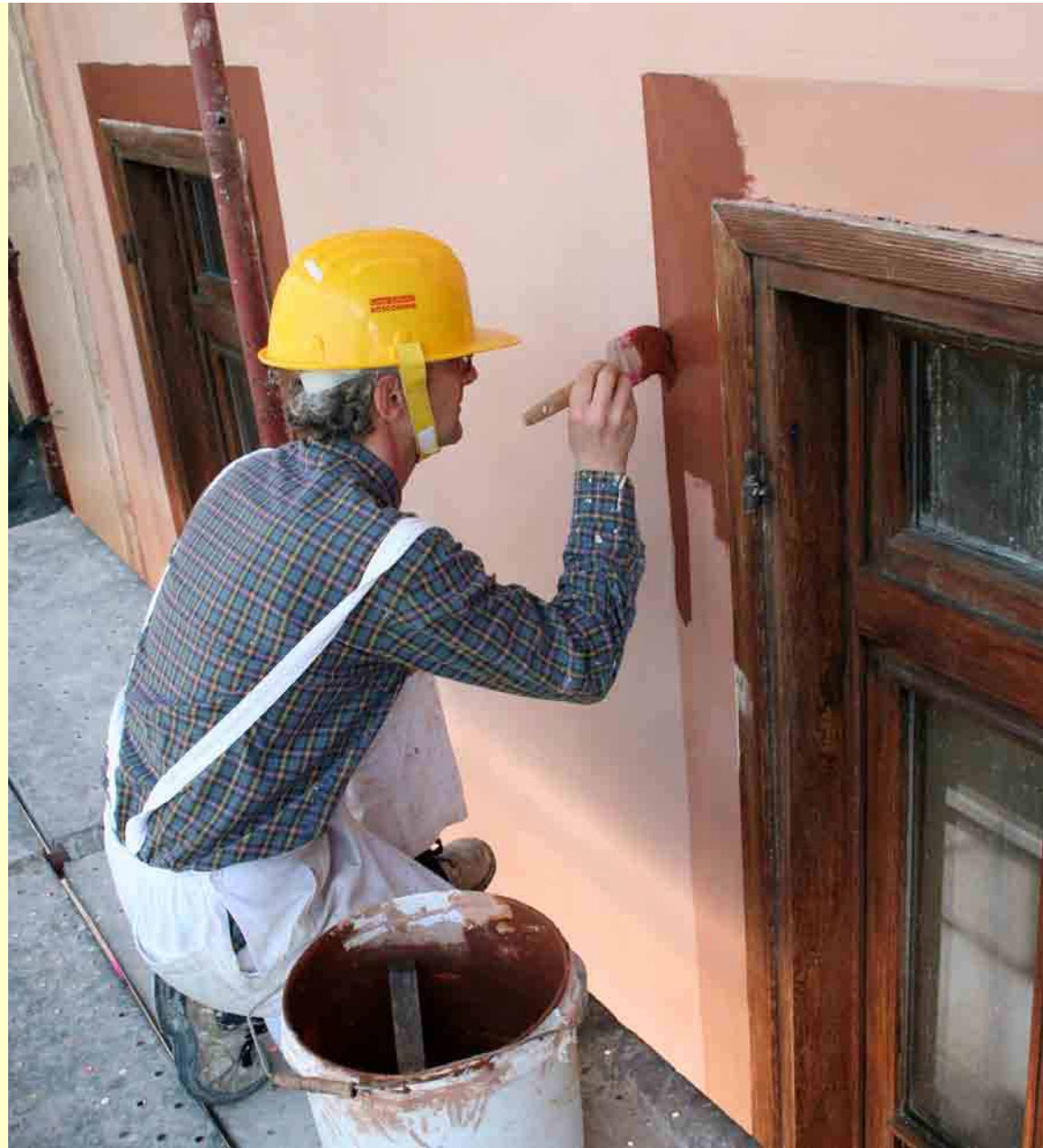
Realizzazione, in trompe-l'oeil, delle cornici delle finestre
