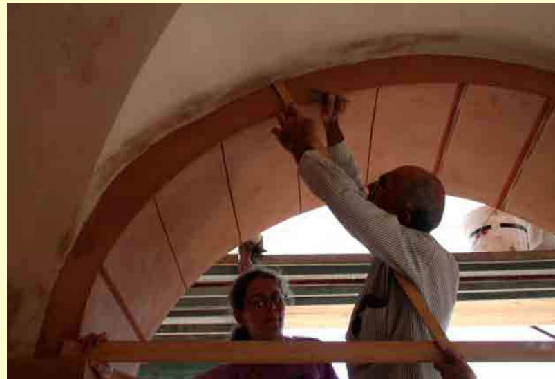
Tracciamento dei bugnati originali del portico, in base ai “lacerti” e alle foto d’epoca
