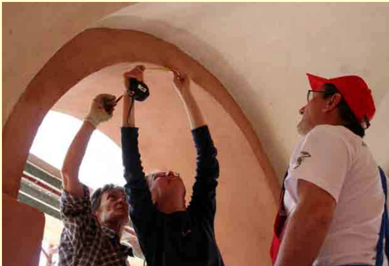
Tracciamento dei bugnati originali del portico, in base ai “lacerti” e alle foto d’epoca
