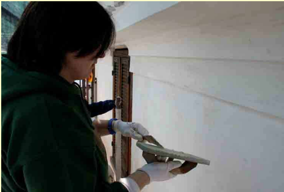
Rasatura con stucco dell'intonaco corroso del cornicione
