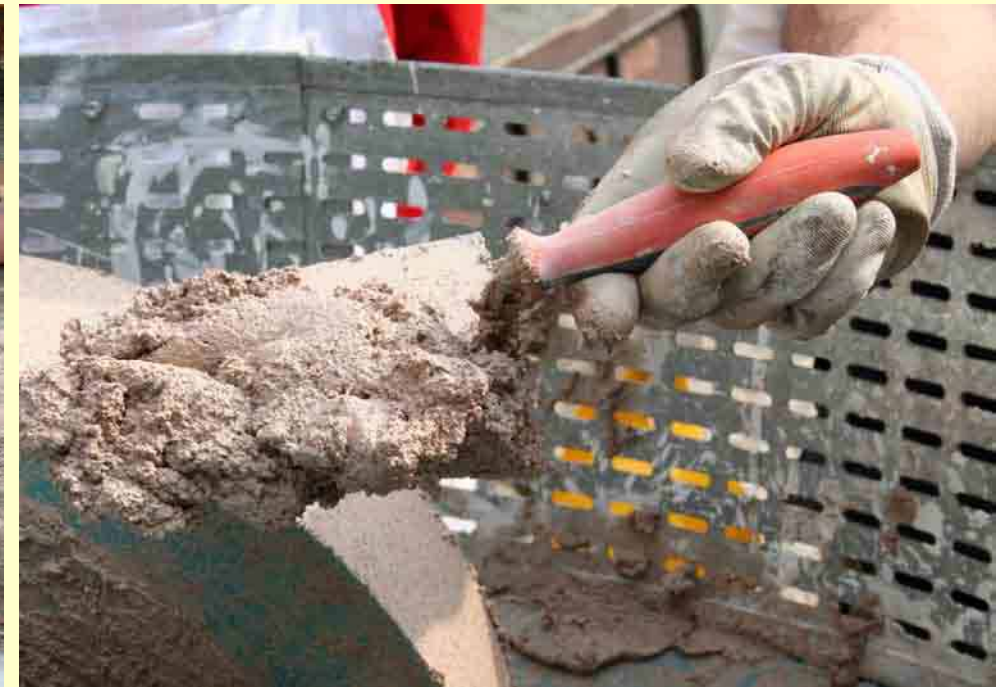
Preparazione dell'intonaco al cocchiopesto con la molazza da applicare ai pilastri e alle pareti del portico
