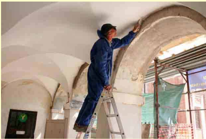
Applicazione dell'intonaco di finitura ai pilastri del portico
