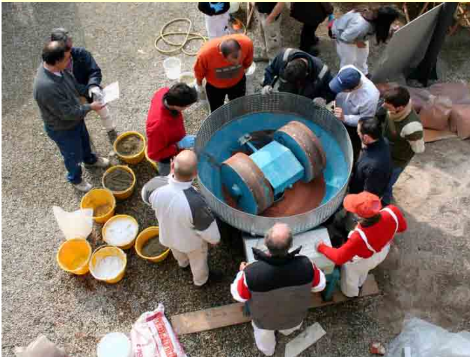
Preparazione dell'intonaco al cocchiopesto con la molazza da applicare ai pilastri e alle pareti del portico
