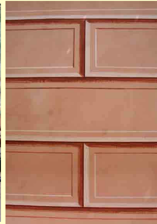
Ripristino dei bugnati originari del basamento lato via Villafranca
