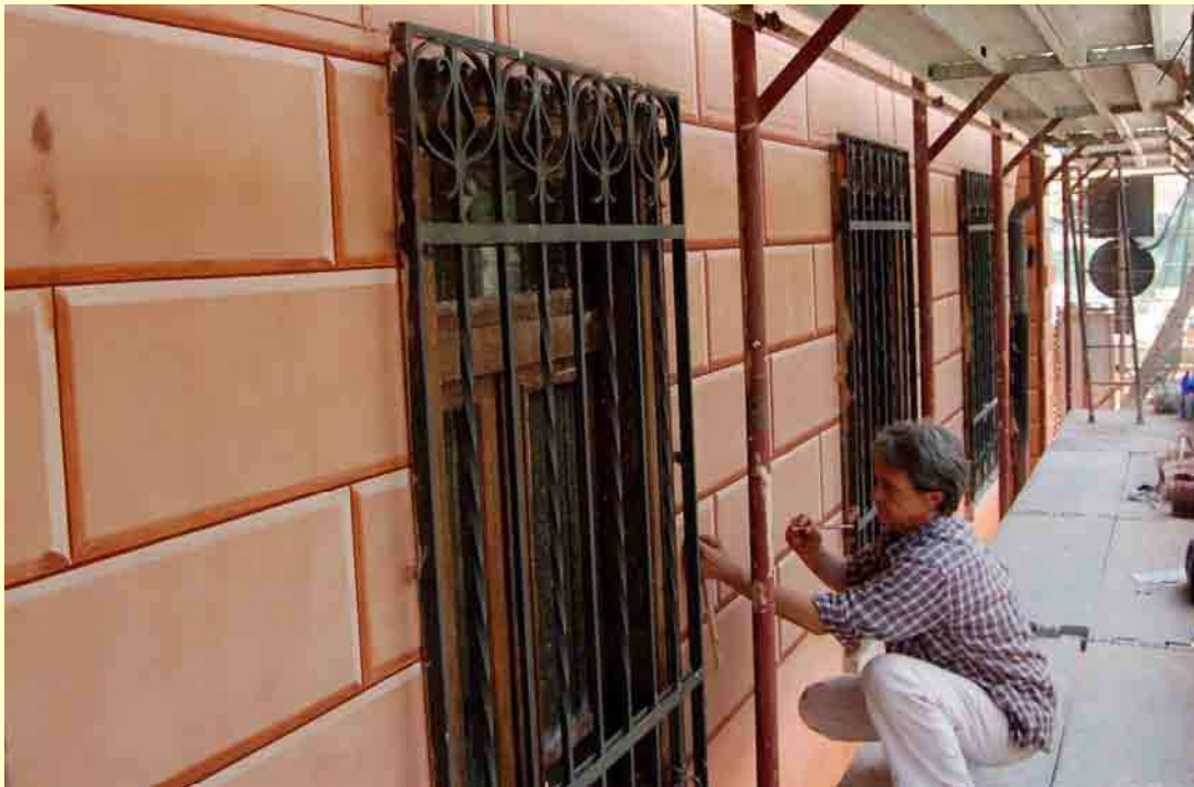
Ripristino dei bugnati originari del basamento lato via Villafranca
