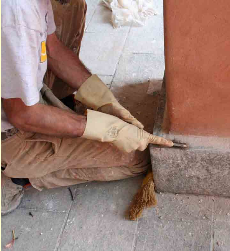
Pulizia dello zoccolo dei pilastri del portico
