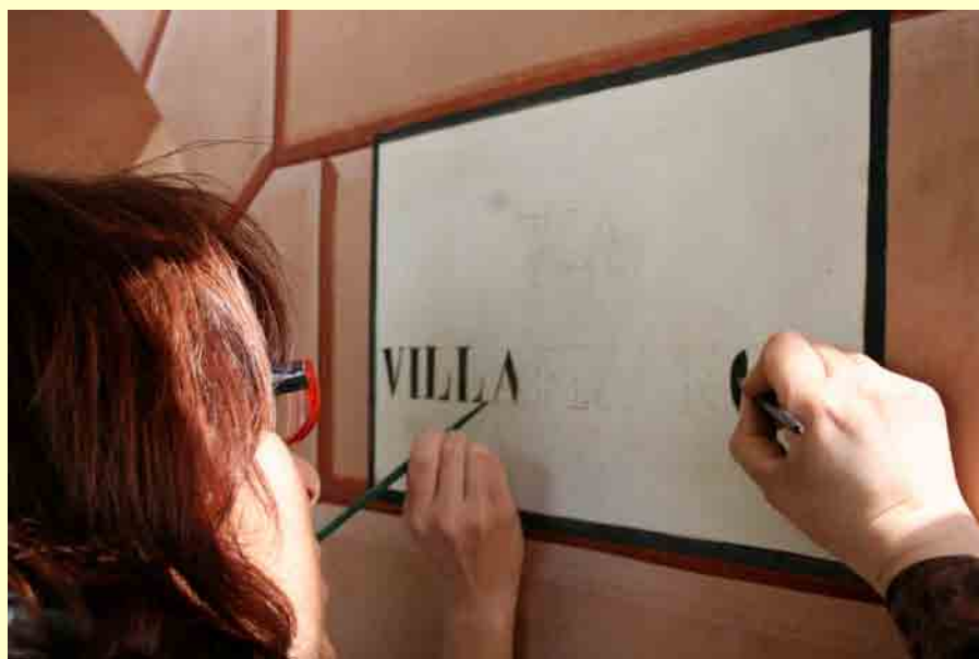
Realizzazione della targa viaria del Comune, lato via Villafranca, in base ai modelli originari rilevati in sito e allestiti in Laboratorio
