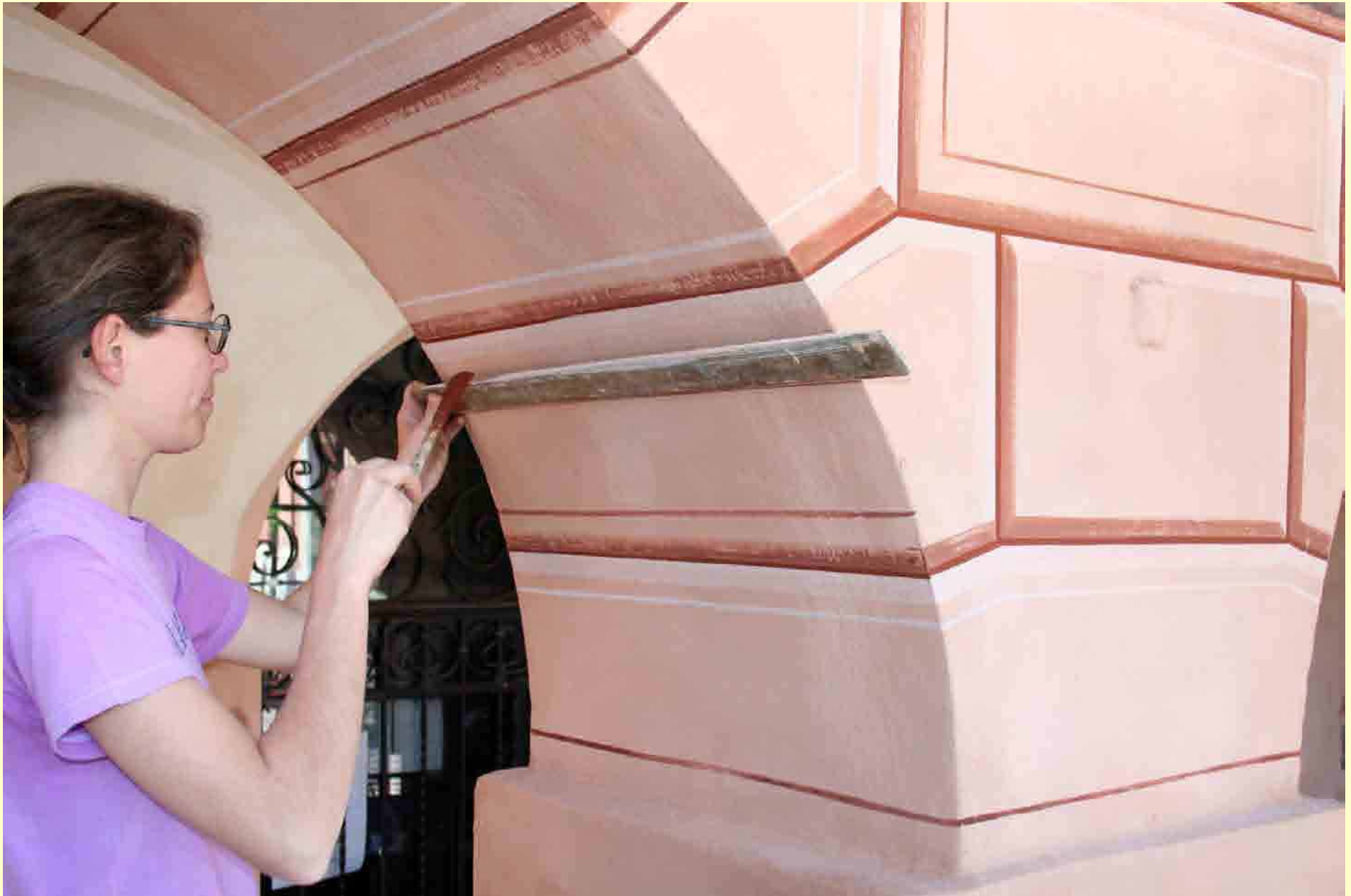
Particolare della realizzazione dei bugnati originari del portico
