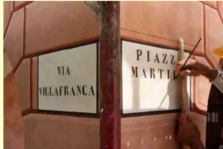
Realizzazione della targa viaria del Comune, lato piazza Martiri della Libertà, in base ai modelli originari rilevati in sito e allestiti in Laboratorio
