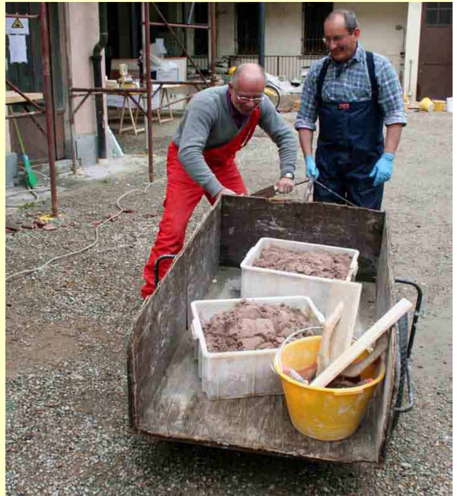
Preparazione dell'intonaco di "cocciopesto" con la molazza da applicare ai pilastri e alle pareti del portico
