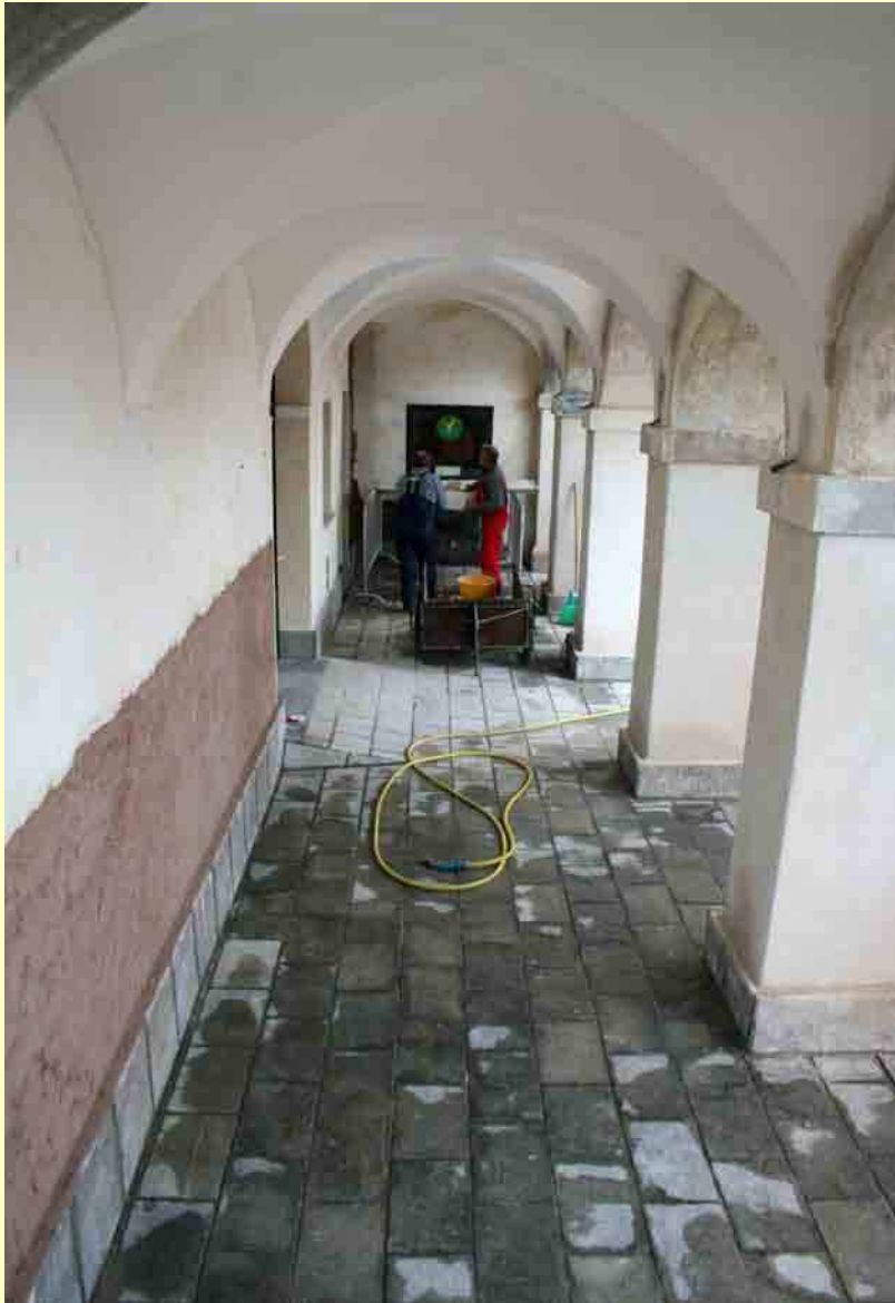
Applicazione dell'intonaco di cocchiopesto alle pareti del portico
