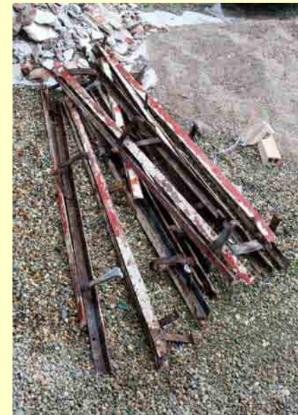
La demolizione degli intonaci cementizi dei pilastri del portico con la rimozione degli angolari metallici
