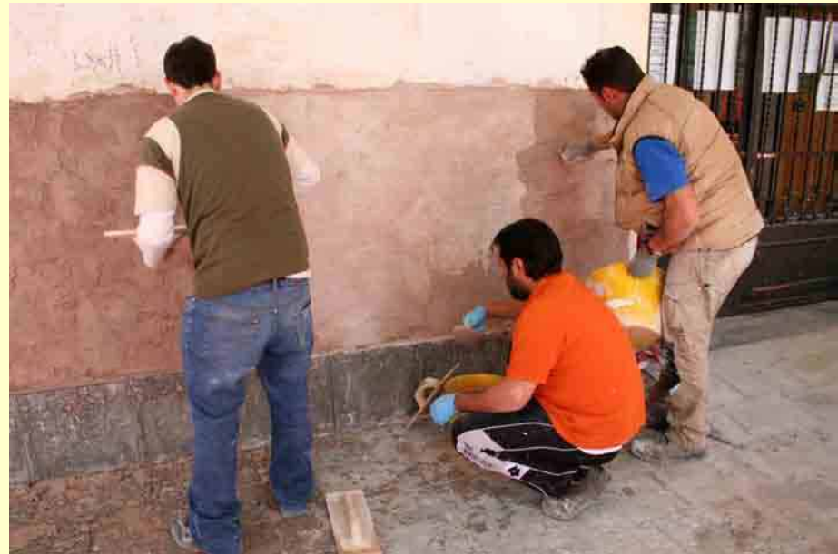
Applicazione dell'intonaco di cocchiopesto alle pareti del portico
