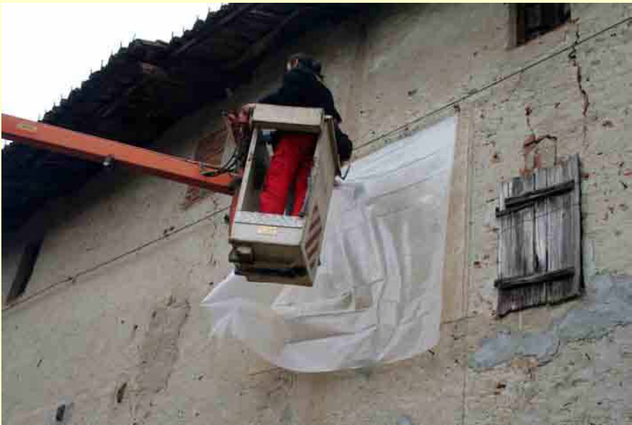
Meridiana in Vicolo Monte Grappa rilevata col cestello e poi riprodotta su pannello intonacato in Laboratorio
