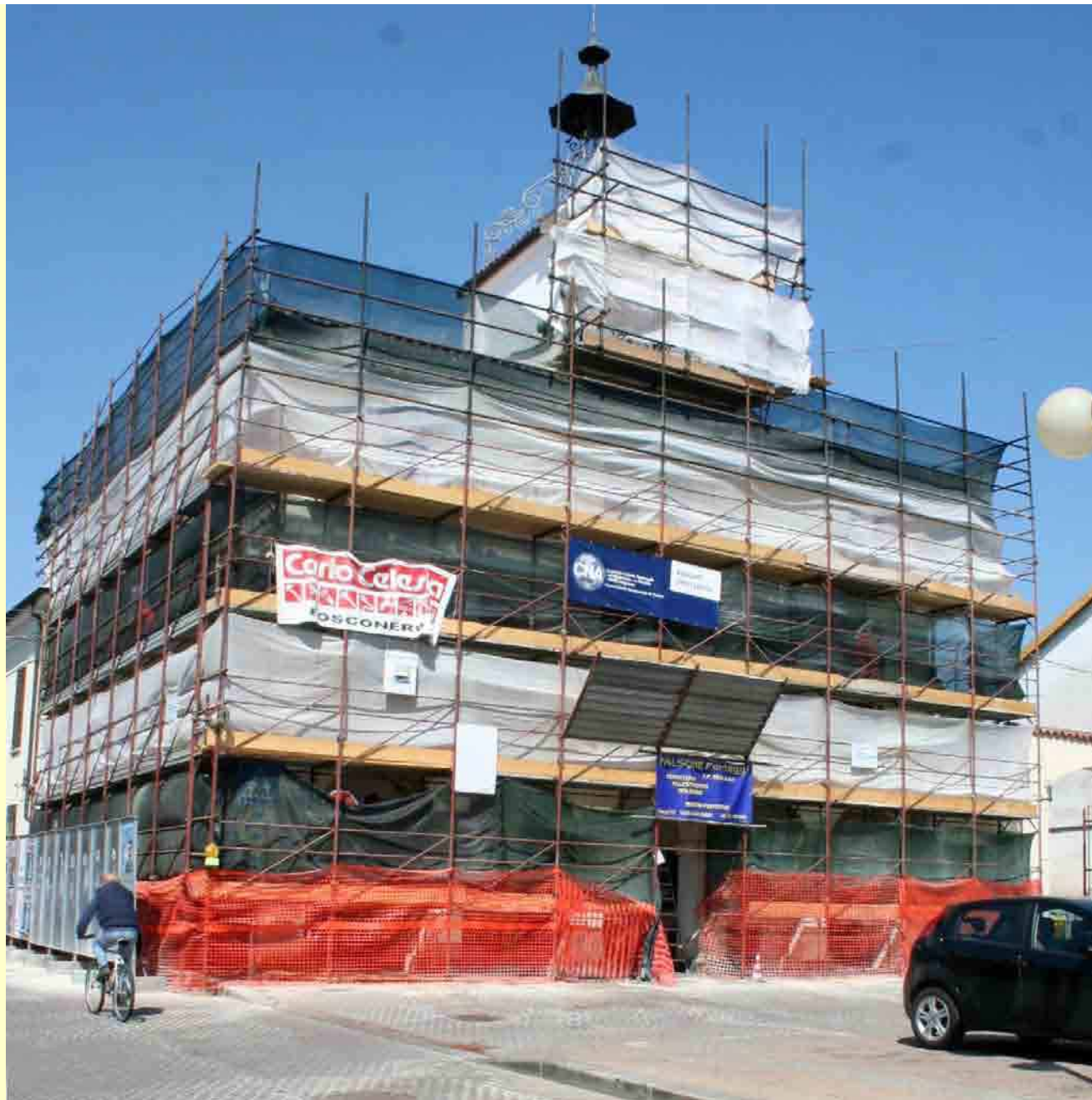
Il montaggio dei ponteggi
