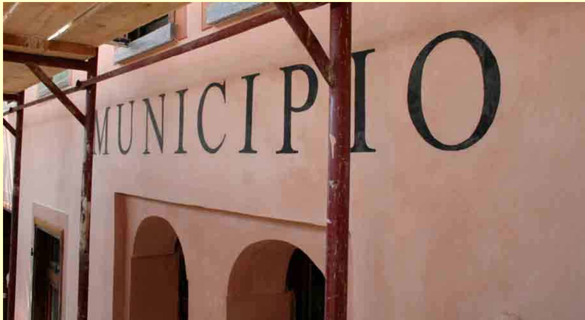
Realizzazione della scritta "Municipio" sulla facciata del Comune
