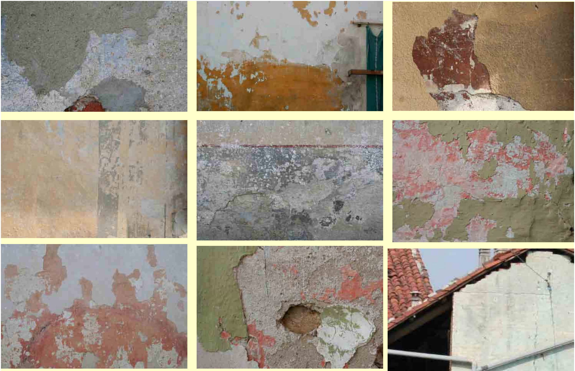
Il rilievo dei colori di Bosconero realizzato dal “Laboratorio Mobile”, con il cestello messo a disposizione dal Municipio
