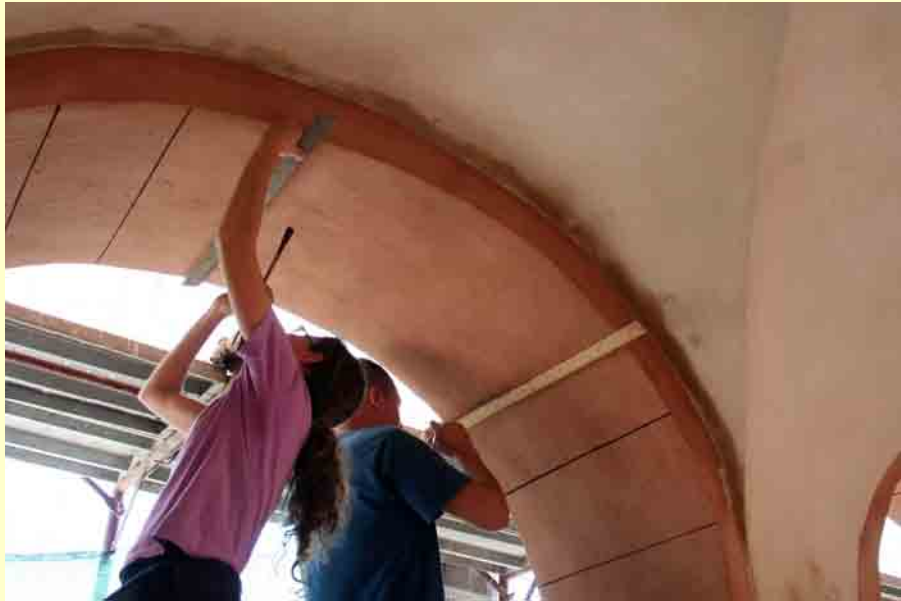
Particolari della realizzazione dei bugnati originali del portico, in base alle tracce e alle foto d'epoca
