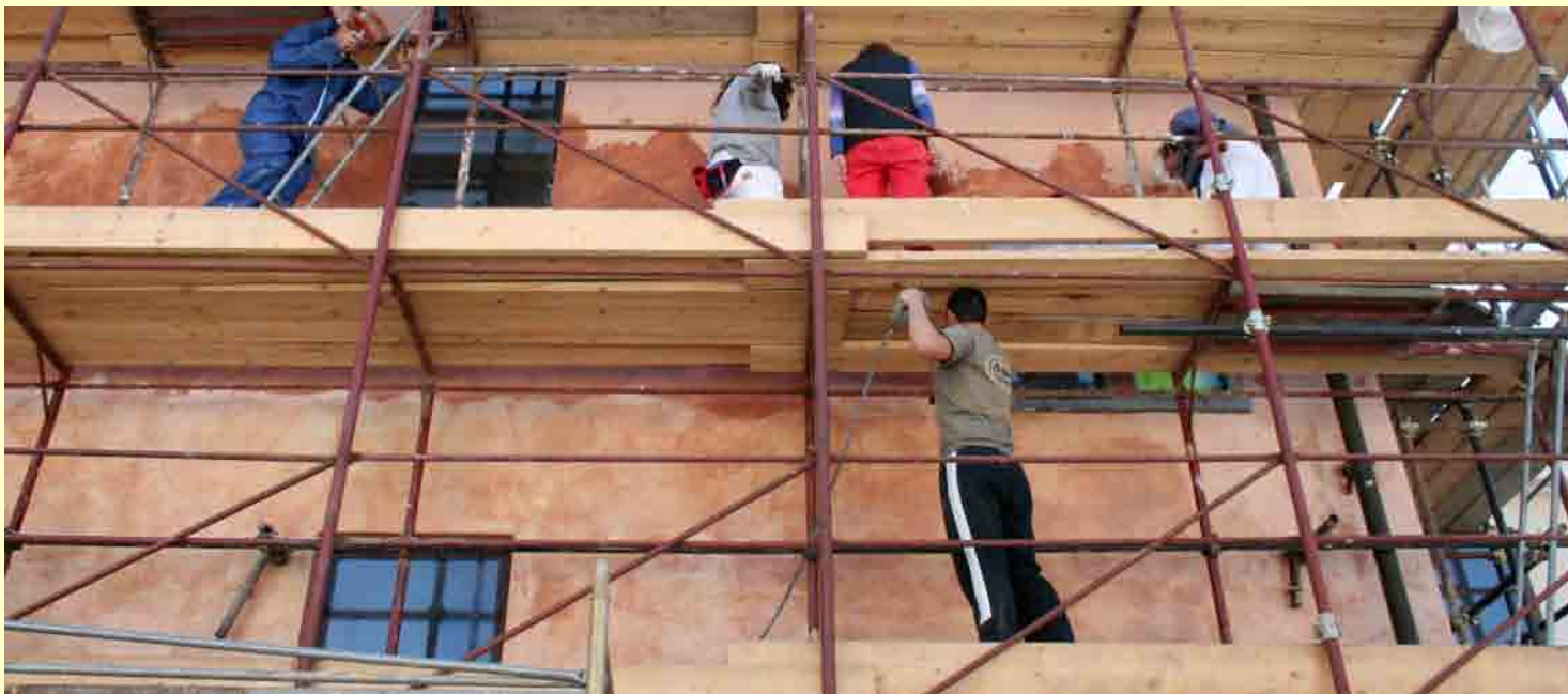
Applicazione dei colori originari sui fondi delle facciate
