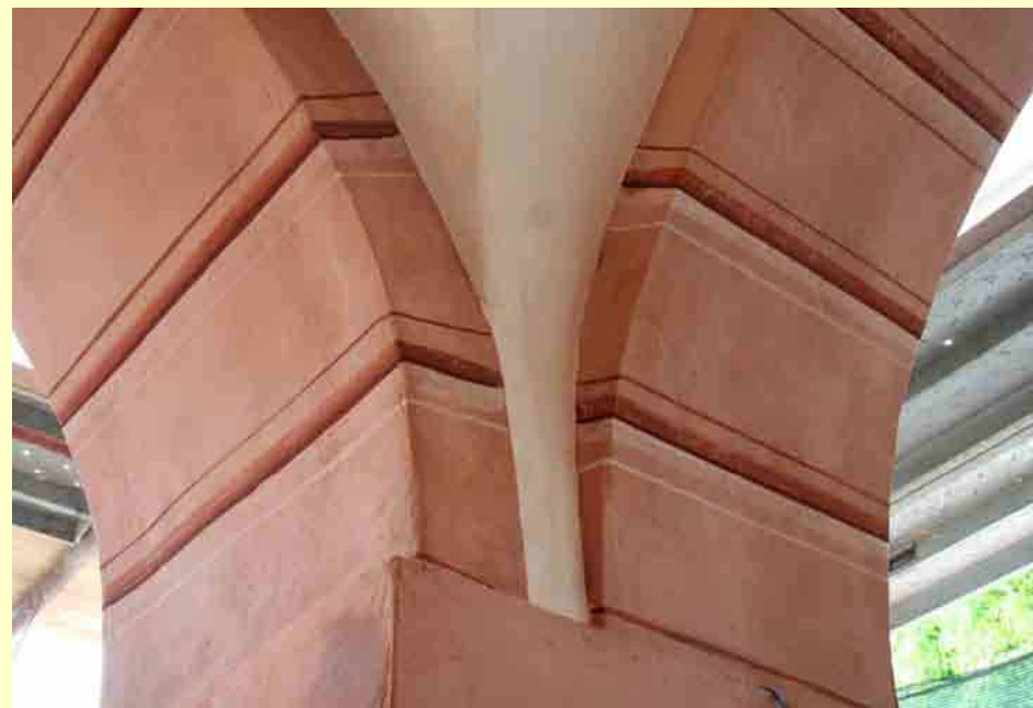
Realizzazione dei bugnati originali dei pilastri del portico
