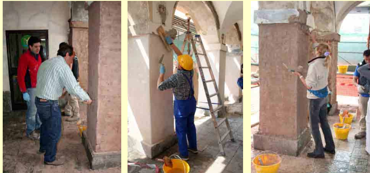
Applicazione dell'intonaco di cocchiopesto ai pilastri del portico
