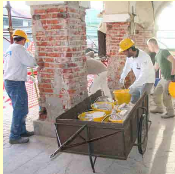
La demolizione degli intonaci cementizi dei pilastri del portico con la rimozione degli angolari metallici
